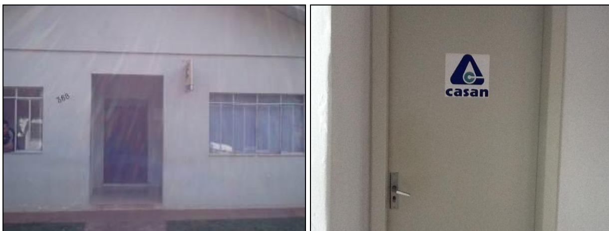
Figura 1: Fachada sem identificação. Somente adesivo na porta interna
