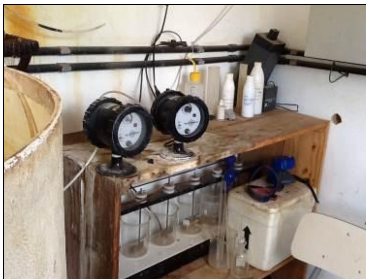
Figura 12: Laboratório em condições inadequadas.
