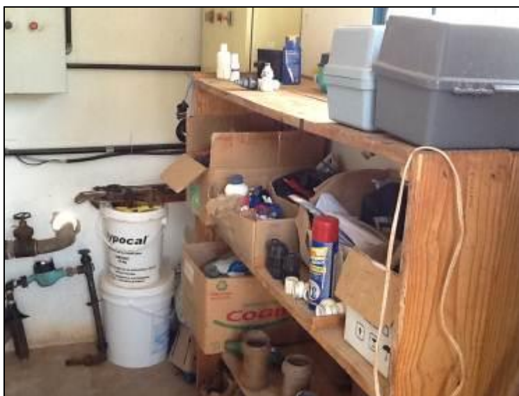
Figura 4: Almoxarifado junto à antiga ETA (desativada)
