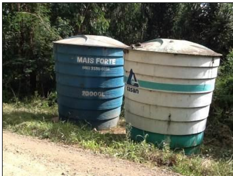
Figura 154: Reservatórios R-01 e R-02.
