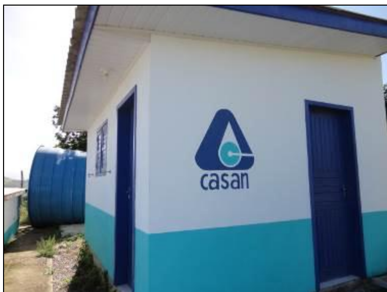
Figura 10:10 Construção de Casa de Química da CASAN no R-02
