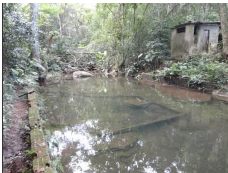
Figura 6 – Captação sem qualquer proteção.
