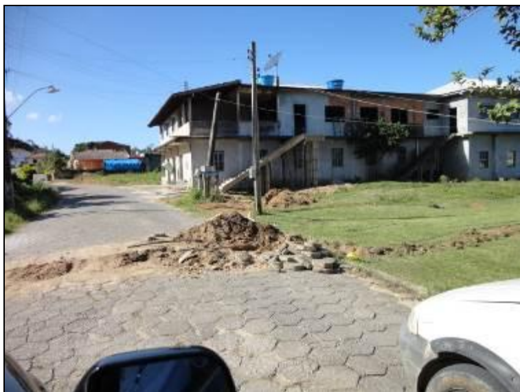
Figura 182: Obras dos funcionários da Prefeitura
