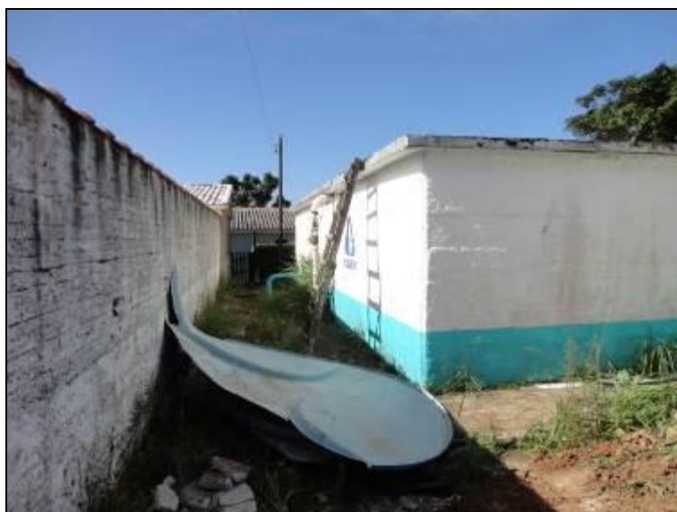
Figura 12: Acesso entorno do reservatório
