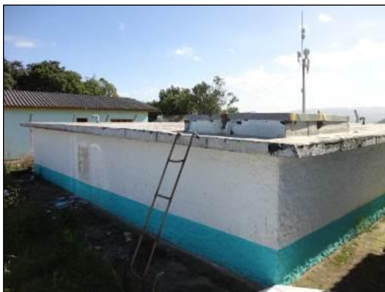
Figura 19: Escada de Acesso R2
