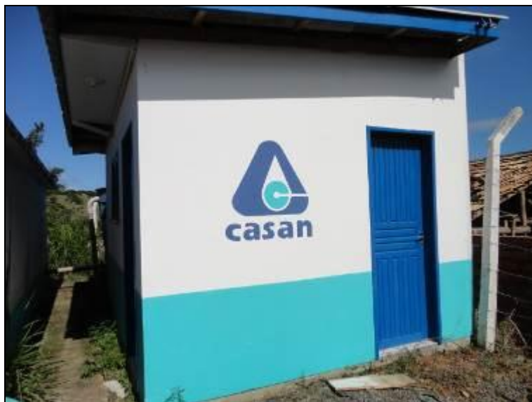
Figura 9: Construção de casa de Química da CASAN no R-01
