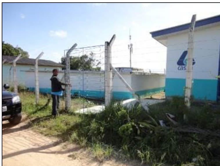
Figura 158: R-02 Devidamente cercado
