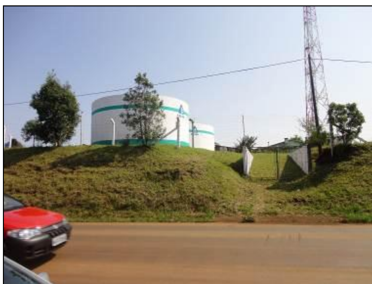
Áreas de entorno dos Reservatórios do SAA.
