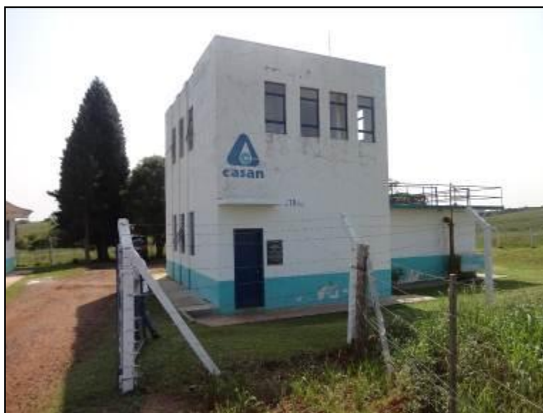
Fachadas da ETA
