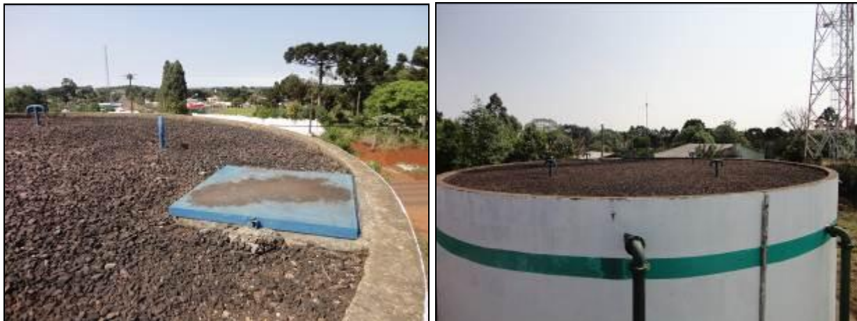
Coberturas dos Reservatórios
