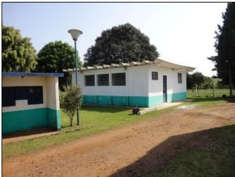
Áreas externas em bom estado de conservação.
