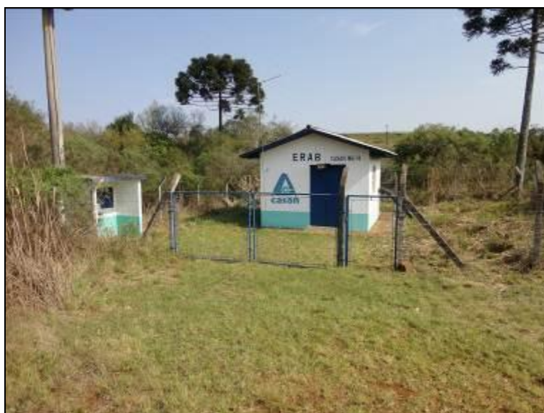
Cada das máquinas onde é feito o recalque para a ETA
