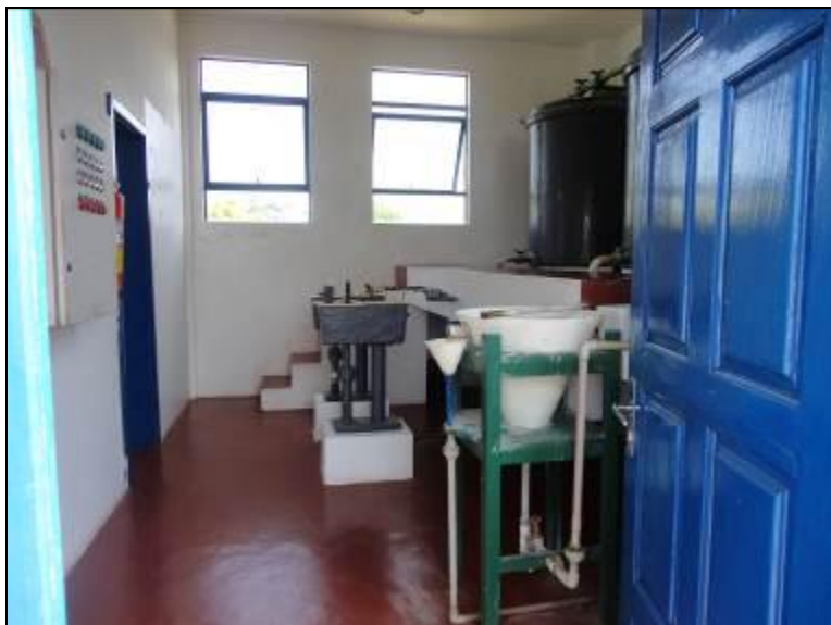
Casa de Química da ETA.
