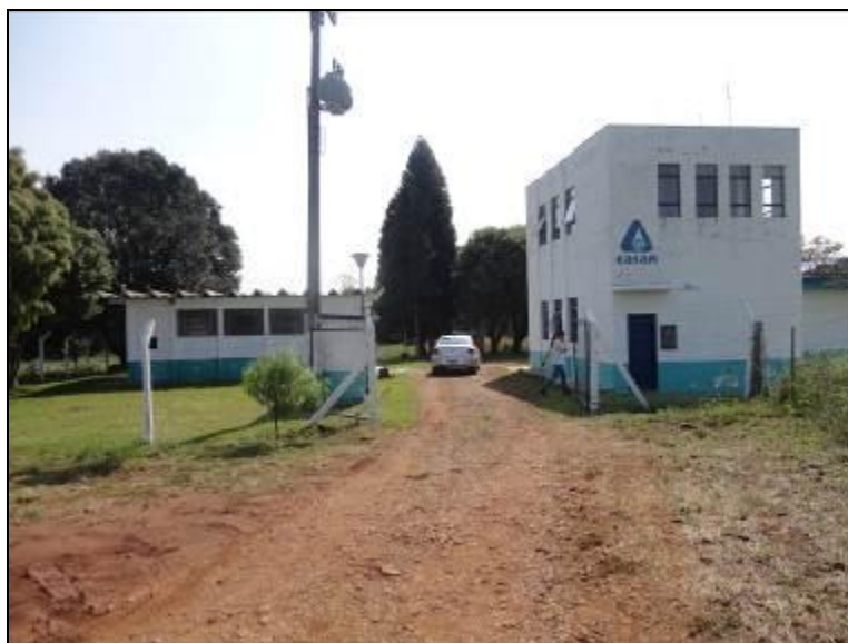
Acesso e entrada da ETA
