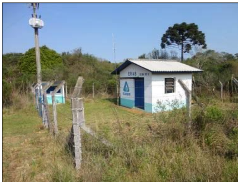
Estação de Recalque é cercada, e identificada.
