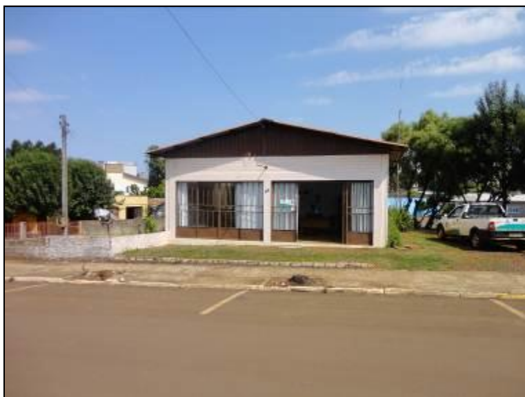
Fachada do Escritório
