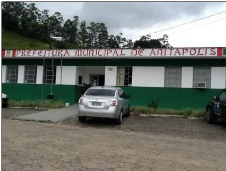
Figura 1 – Fachada do Prédio
