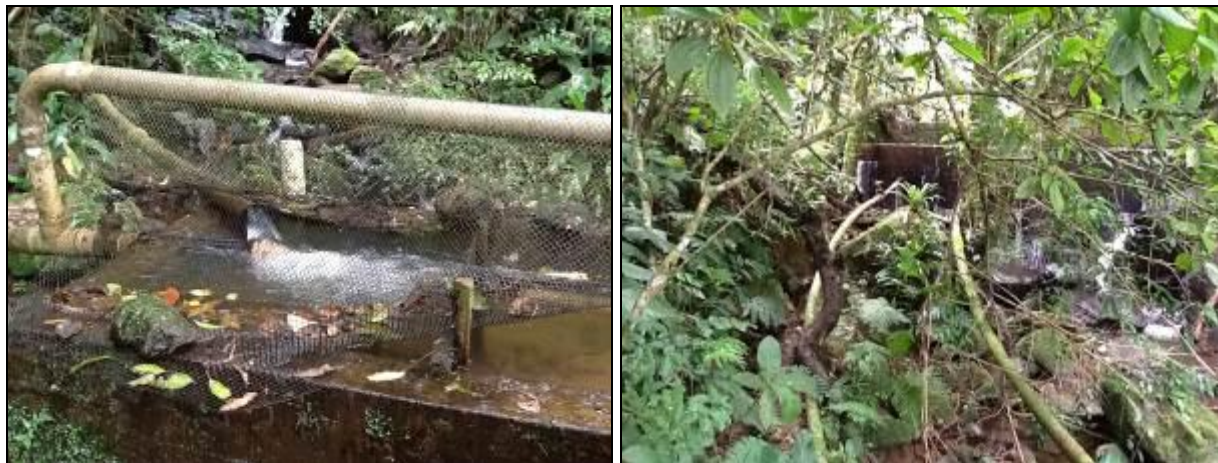
Figura 4: Local de captação
