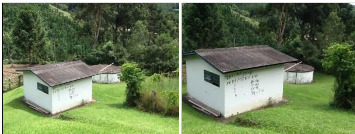
Figura 11: Casa de Química e Reservatório
