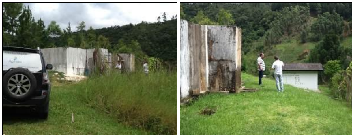
Figura 6: Vista geral da ETA
