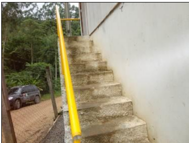
Figura 13: Acesso a ETA em boas condições
