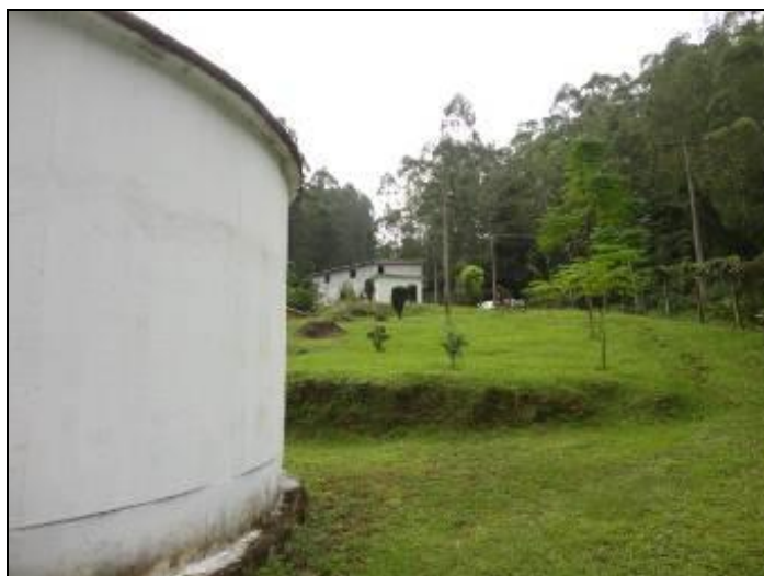
Figura 22: Entorno do reservatório
