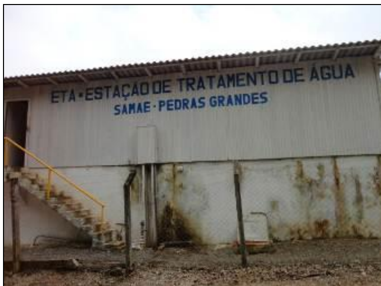
Figura 11: Vista geral da ETA.
