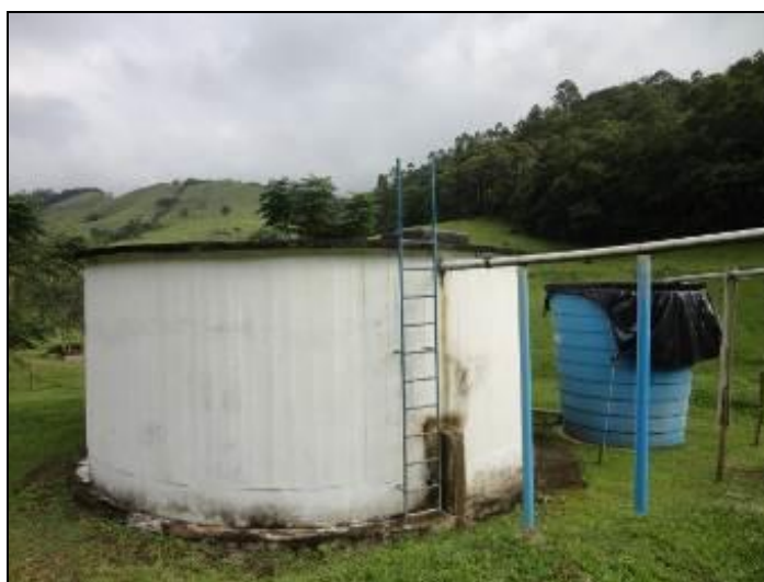
Figura 24: Escada de acesso ao reservatório
