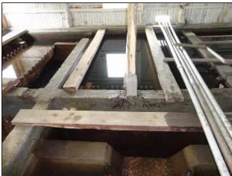
Figura 18: Filtros da ETA
