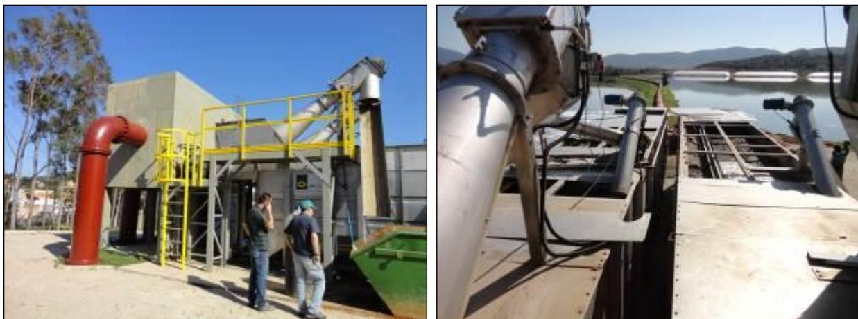
Figura 136- Equipamento de tratamento inicial do esgoto na entrada da ETE: separação de sólidos (Inicial)
