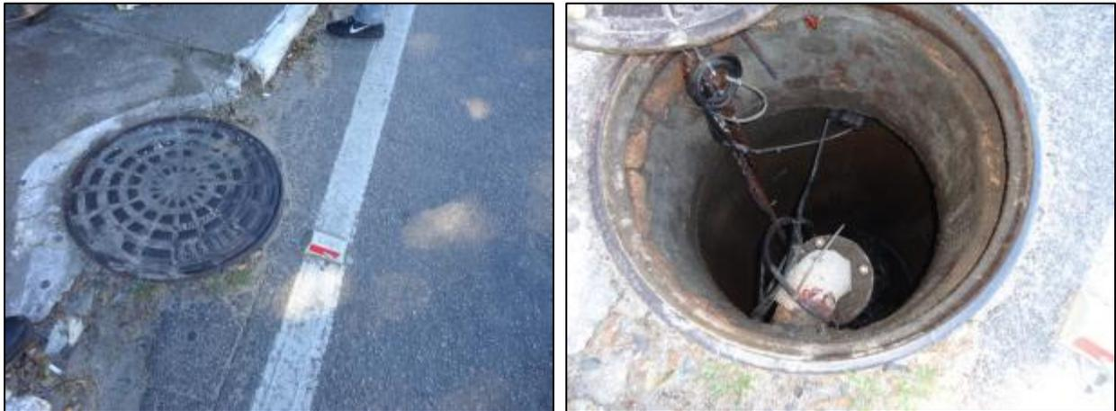
Figura 215- Vista externa e interna do poço úmido
