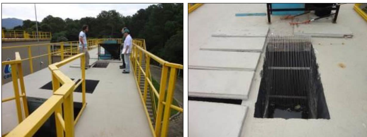
Figura 129– Área de entrada do Efluente Bruta e Gradeamento (Acompanhamento)
