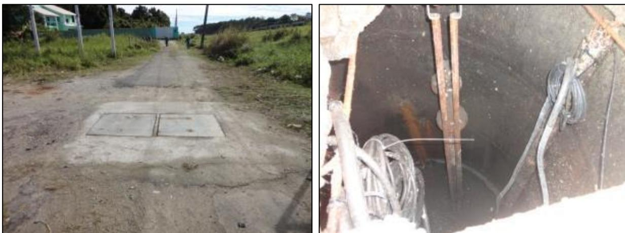
Figura 182- Vista externa e interior do poço úmido
