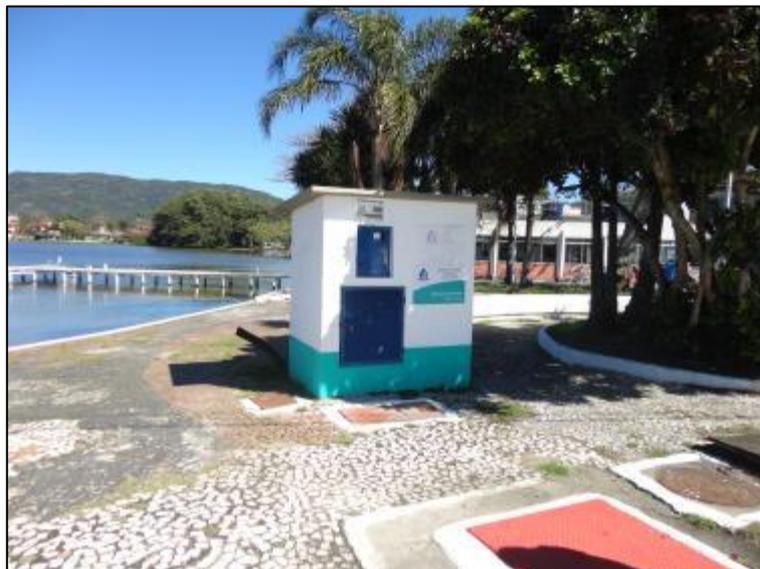
**Figura 216- Vista geral da EEE B01 Ponte. É possível perceber os quadros de comando e energia, a placa de identificação e restrição de acesso, bem como o poço úmido localizado na calçada**
