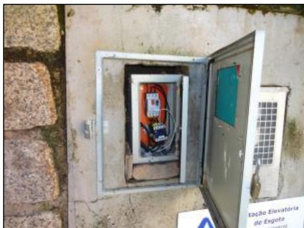
Figura 233- Vista da EEE Retiro da Lagoa com placa de identificação e restrição de acesso, bem como vista dos quadros de energia e comando
