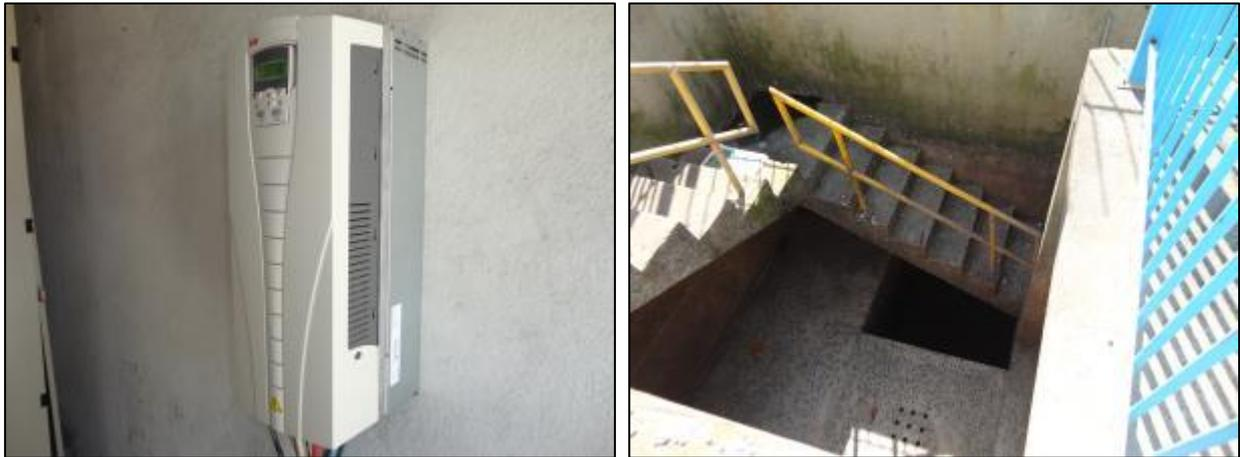
Figura 269- Novo inversor de frequência (à esquerda) e sistema de grades para reter sólidos grosseiros (à direita)
