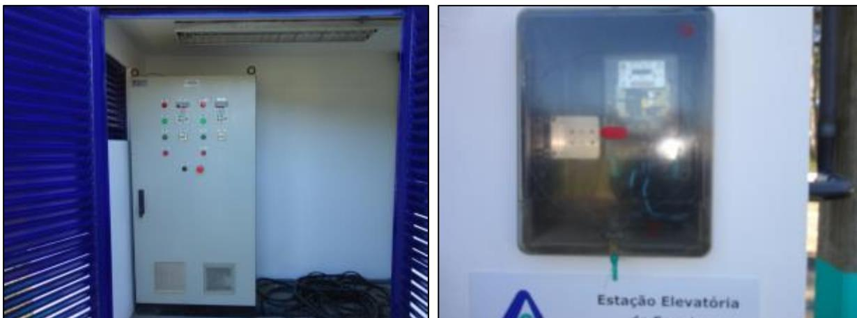
Figura 196- Quadro de comando (à esquerda) e quadro de energia (à direita)
