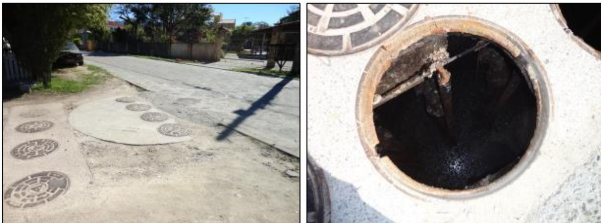
Figura 204- Vista externa e interna do poço úmido
