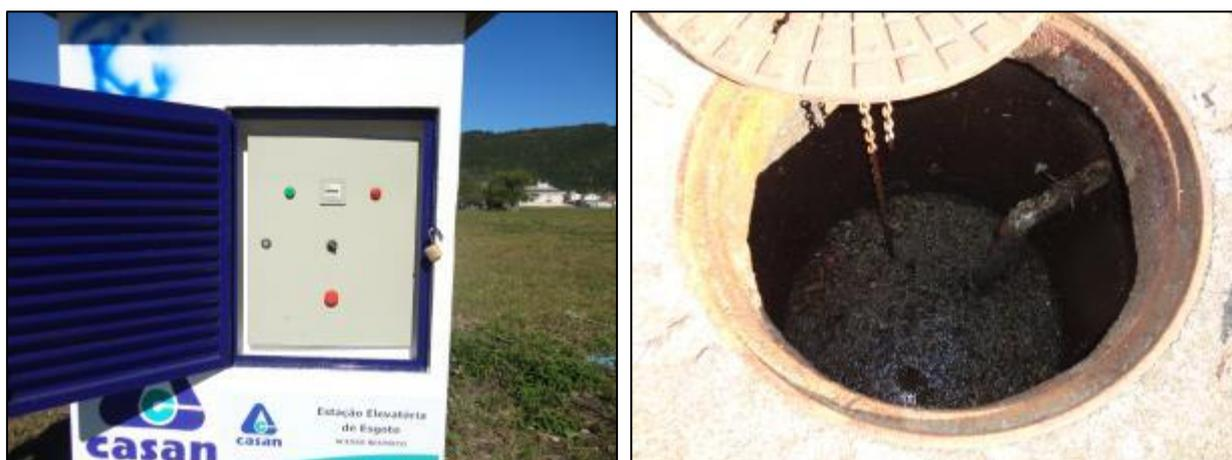
Figura 199- Quadro de comando (à esquerda) e interior do poço úmido (à direita)
