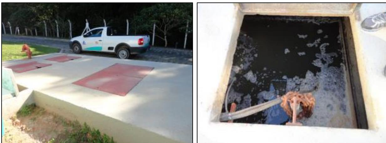
Figura 194- Vista externa e interna do poço úmido
