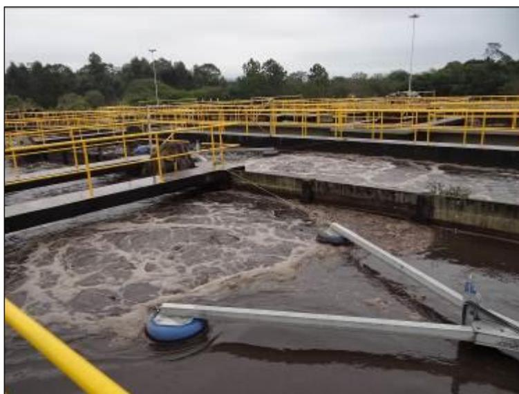
**Figura 54- Lodos Ativados (Valos de Oxidação) (Inicial)**
