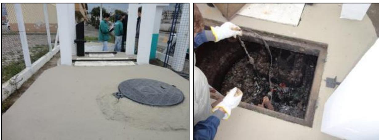
Figura 249- Vista externa e interna do poço úmido. É possível perceber bastante gordura e sujeira no interior
