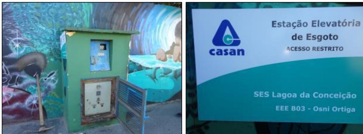
Figura 214- Quadro de comando e quadro de energia (à esquerda) e placa de identificação e restrição de acesso (à direita)
