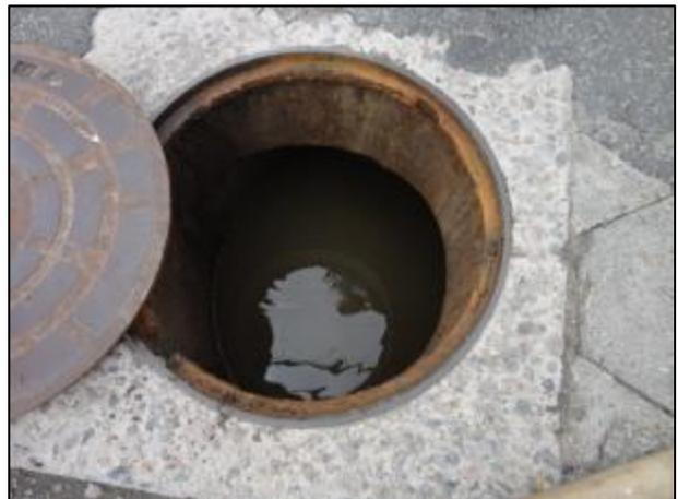
Figura 252- Vista externa e interna do poço úmido
