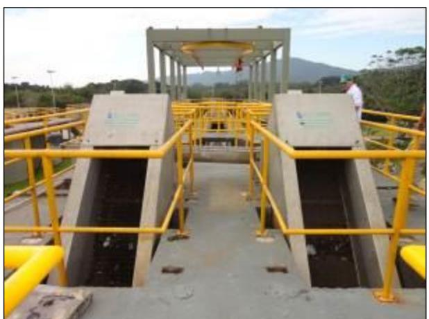
**Figura 67- Efluente bruto e área de recepção com gradeamento (Acompanhamento)**
