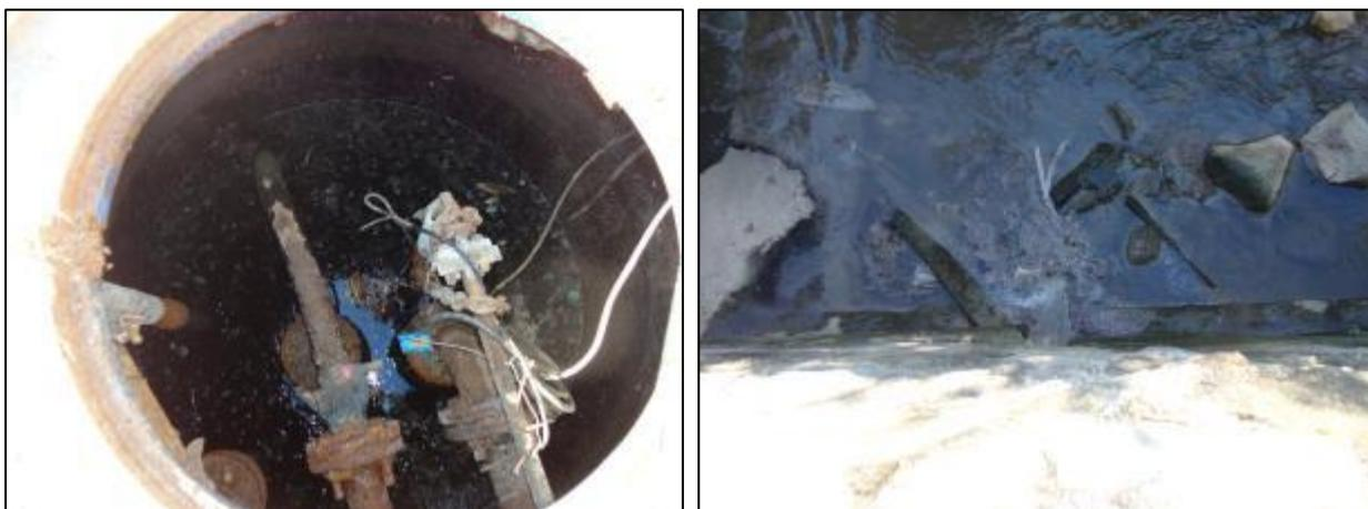
Figura 305- Vista interna do poço úmido (à esquerda) e local onde extravasa o esgoto (à direita)
