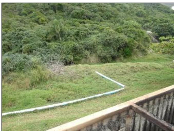
**Figura 85- Tubulação que leva o efluente final ao corpo receptor (Acompanhamento)**
