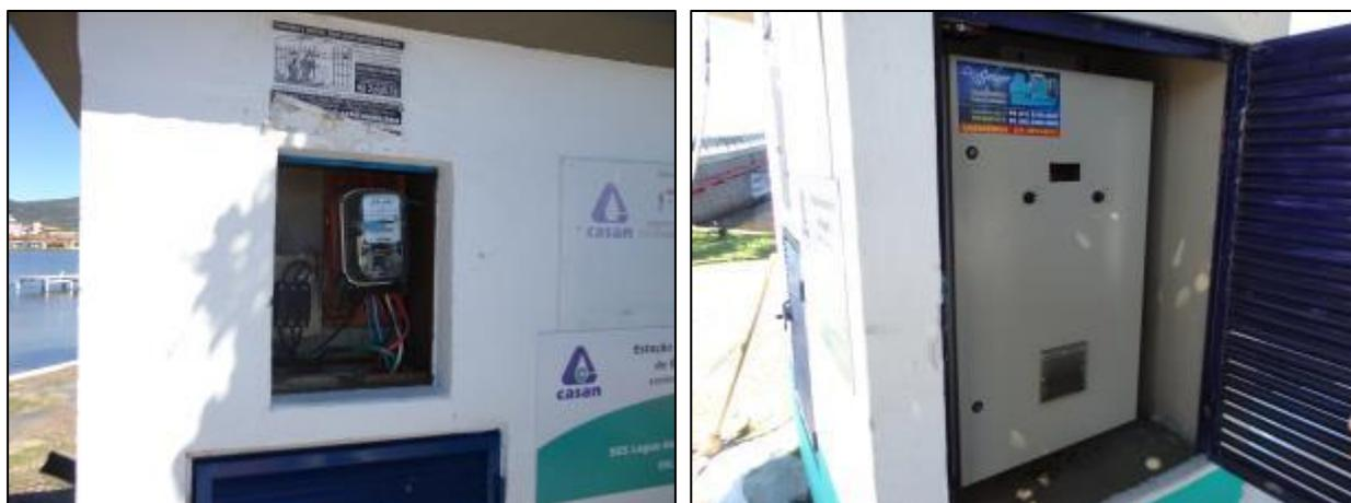
**Figura 217- Quadro de energia sem a porta (à esquerda) e quadro de comando (à direita)**
