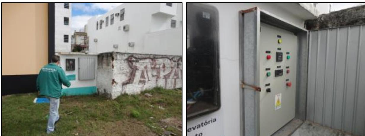
Figura 265- Vista geral da EEE PC1A1 abandonada, com placa de identificação e restrição de acesso (à esquerda) e quadro de comando (à direita)
