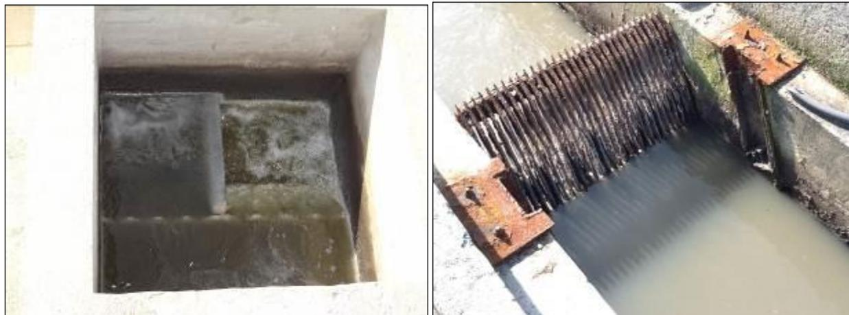
Figura 116- Entrada do efluente e gradeamento para separação dos sólidos (Inicial)
