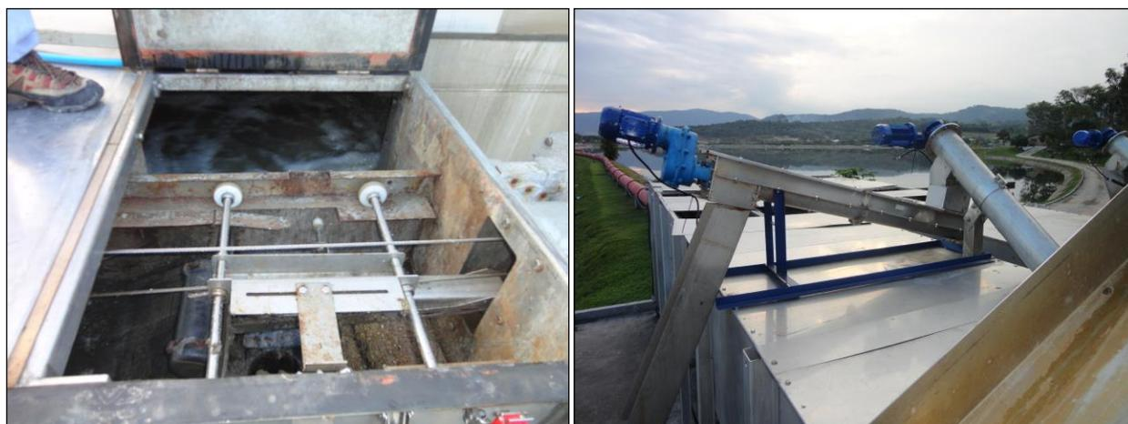
Figura 137- Equipamentos de tratamento inicial do esgoto na entrada da ETE: separação de sólidos (Acompanhamento)
