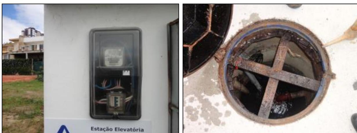
**Figura 264- Quadro de energia sem cadeado (à esquerda) e interior do poço úmido (à direita)**
