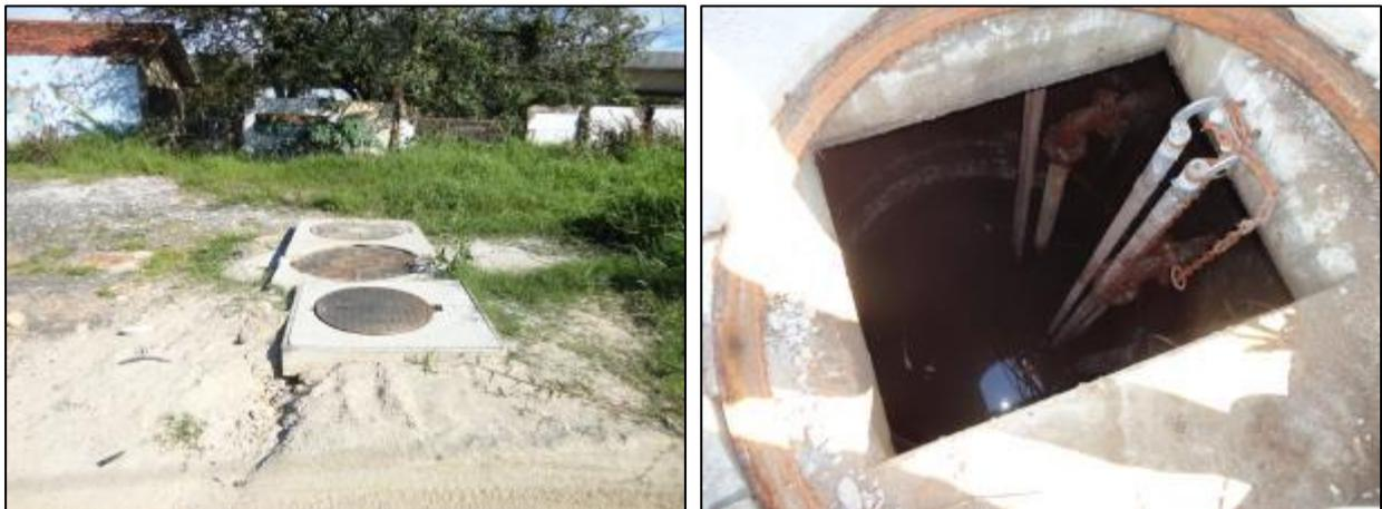
Figura 286- Vista externa e interna do poço úmido
