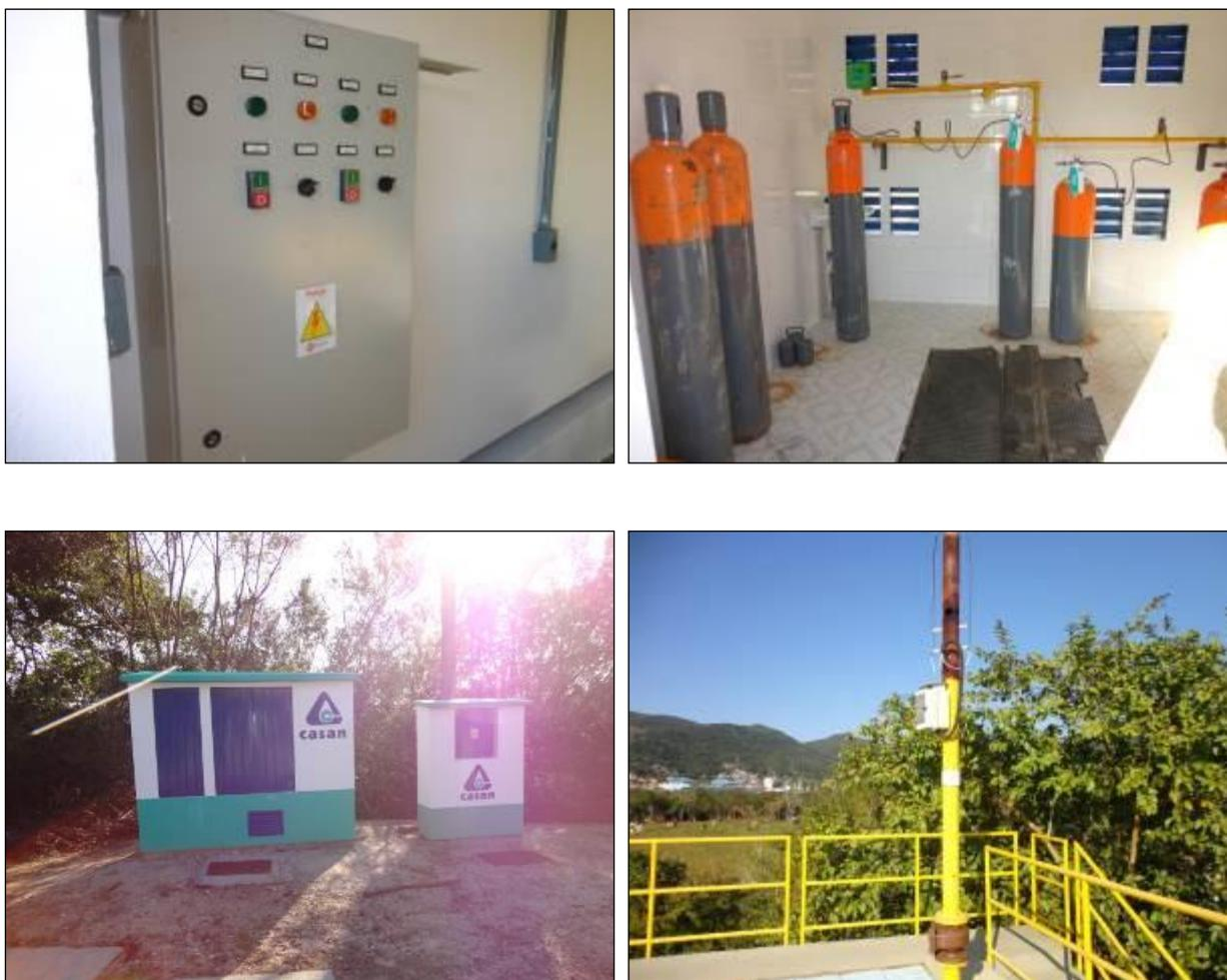
Figura 39- Outras estruturas: Quadro de Comando/Força, depósito de produtos químicos, e queimador de biogás (Acompanhamento)
