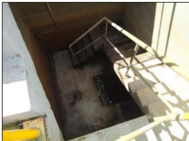
Figura 160- Quadro de energia sem cadeado (à esquerda) e sistema de grades para reter sólidos grosseiros (à direita)
