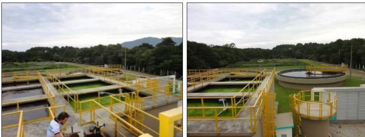
Figura 125– Lagoa de estabilização (à esquerda) e decantador (à direita) (Acompanhamento)
