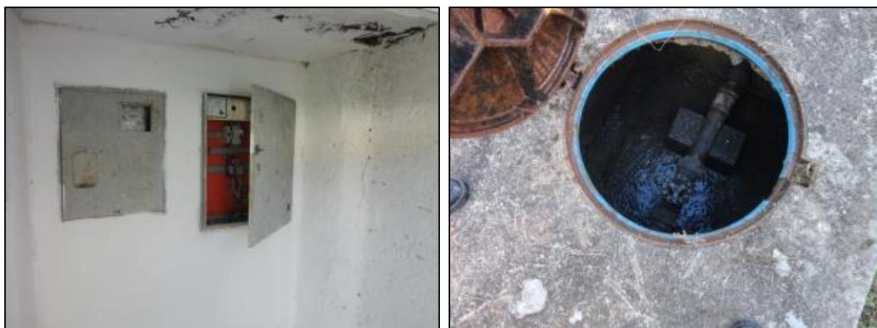
Figura 192- Quadro de comando e energia (à esquerda) e interior do poço úmido (à direita)
