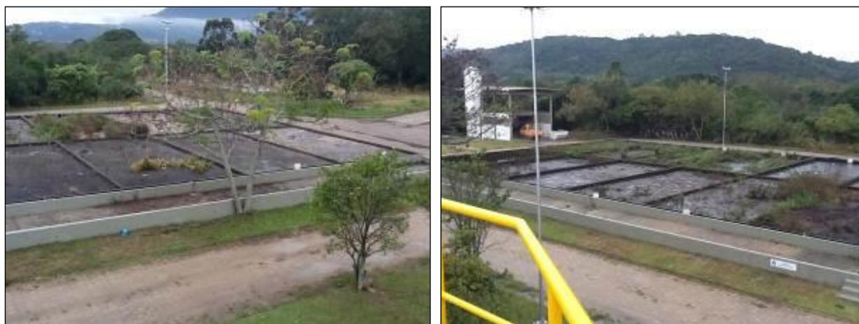
Figura 63- Leitos de secagem do lodo (Inicial)
