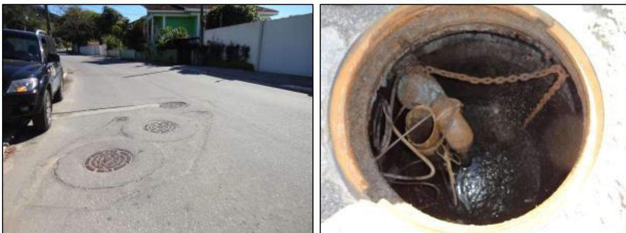
Figura 229- Vista externa e interna do poço úmido
