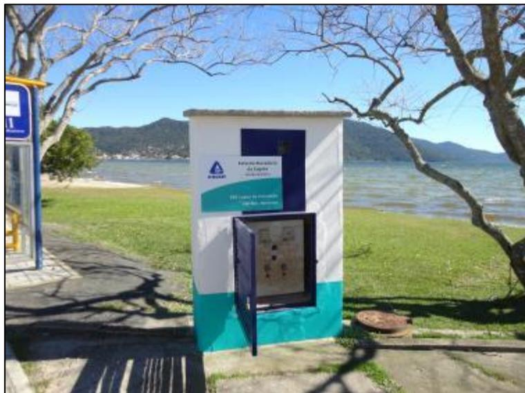
Figura 209- Vista geral da casa de comando e do quadro de energia, bem como a placa de identificação e restrição de acesso
