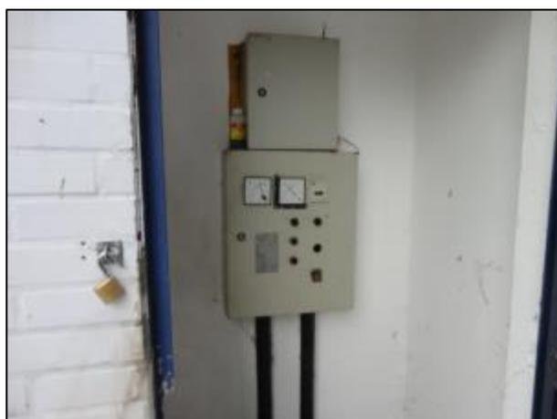
**Figura 245- Vista do local da EEE J2 Bom Abrigo, com placa de identificação e restrição de acesso (à esquerda) e quadro de comando (à direita)**
