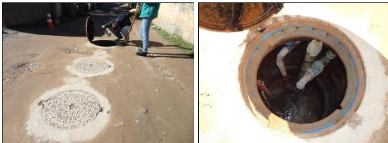
Figura 221- Vista externa e interna do poço úmido
