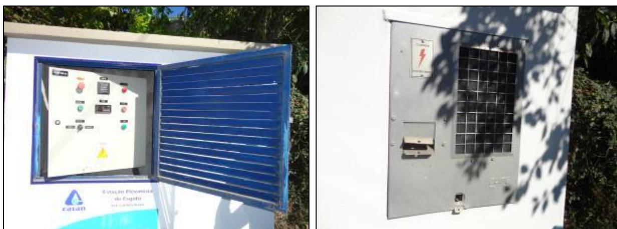
Figura 231- Quadro de comando (à esquerda) e quadro de energia (à direita)
