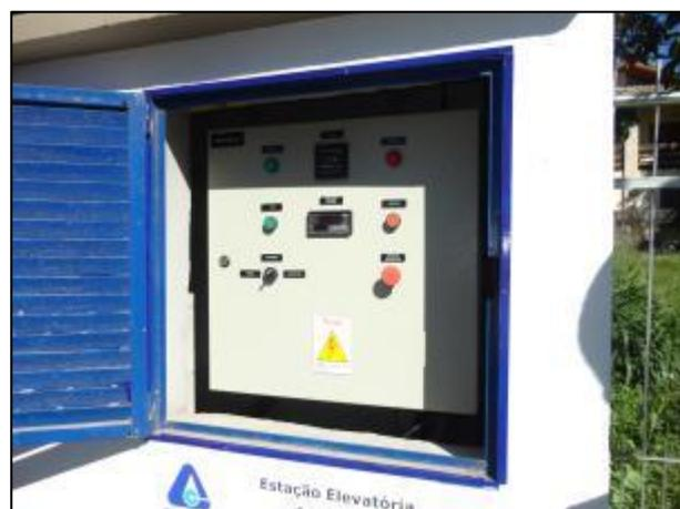
**Figura 228- Vista da EEE BB Canto da Lagoa com placa de identificação e restrição de acesso, bem como a vista interna do quadro de comando**
