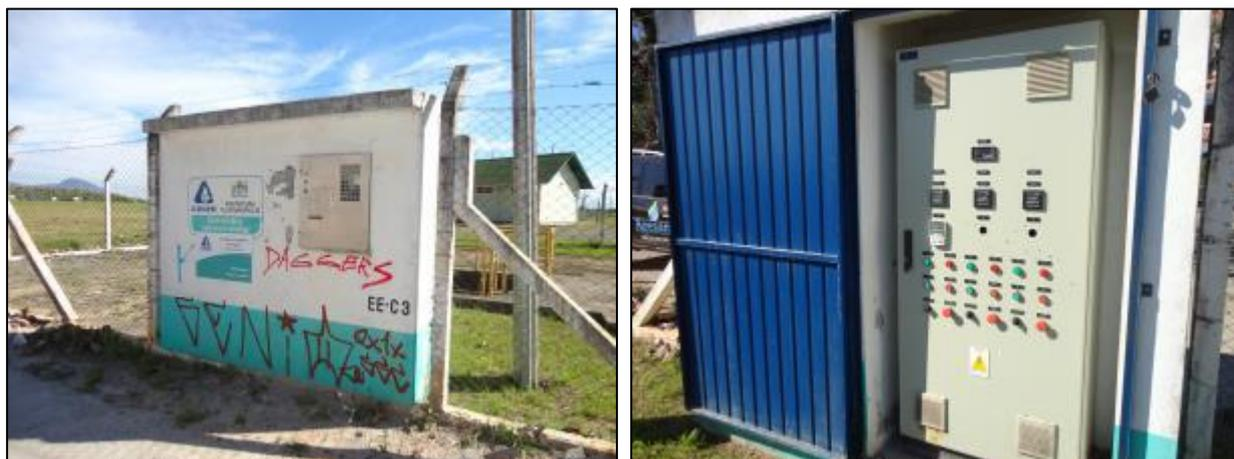
Figura 279- Vista geral da EEE C3 Costeira com placa de identificação e restrição de acesso, é possível perceber o quadro de energia (à esquerda) e o quadro de comando (à direita)
