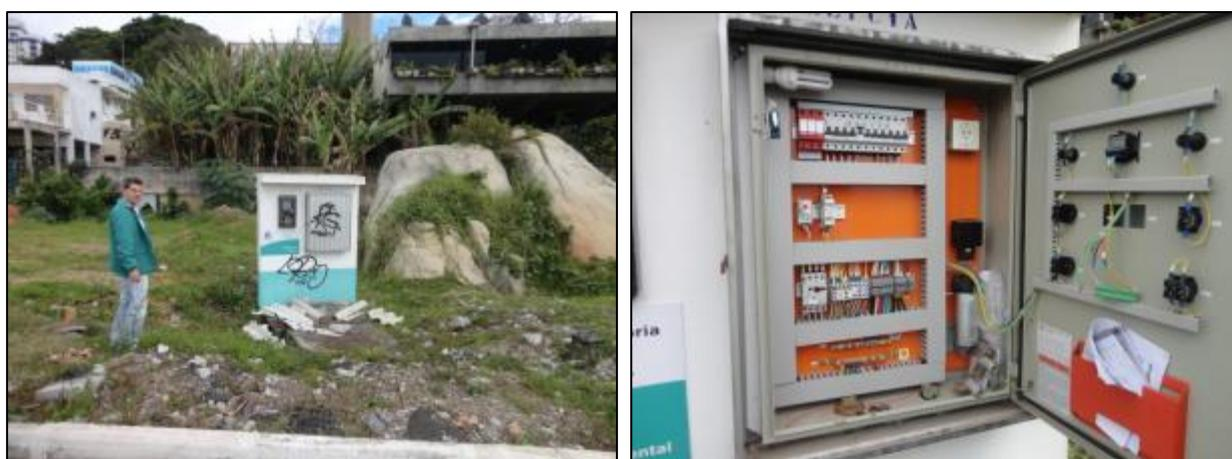
**Figura 263- Vista geral da EEE PC1A abandonada, com placa de identificação e restrição de acesso (à esquerda) e quadro de comando (à direita)**
