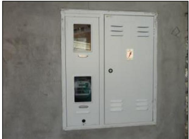
Figura 297- Quadro de comando (à esquerda) e quadro de energia (à direita)
