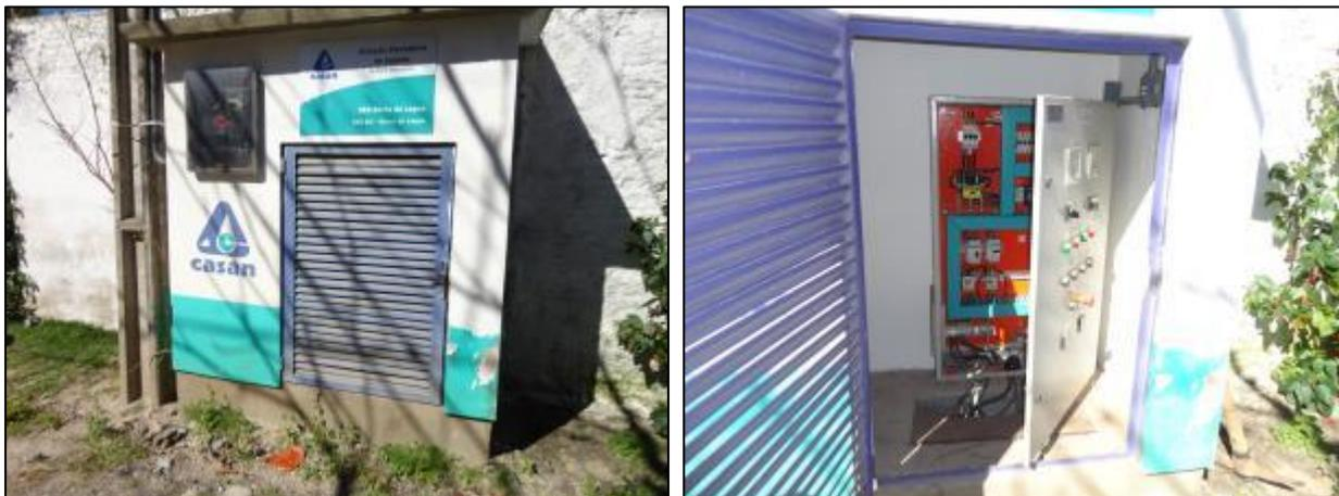
Figura 205- Vista externa e interna da casa de comando, com placas de identificação e restrição
