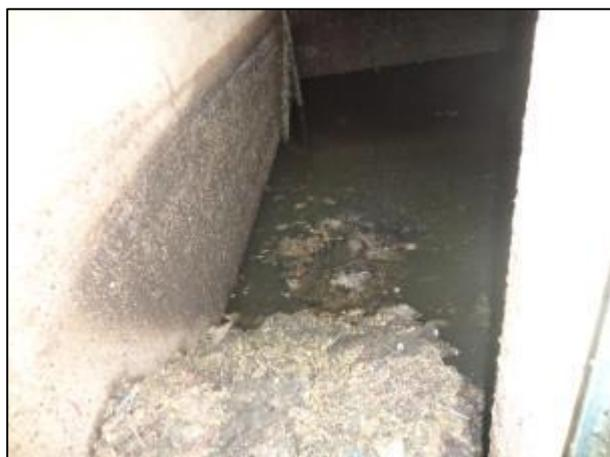
Figura 260- Bombas submersíveis de poço seco (à esquerda) e poço úmido com excesso de gordura e sujeira (à direita)
