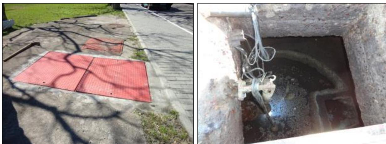
Figura 210- Vista externa e interna do poço úmido
