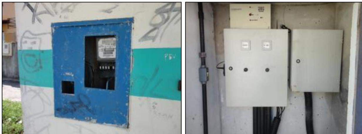
Figura 151- Quadro de energia danificado e sem proteção (à esquerda) e vista interna do quadro de comando (à direita)
