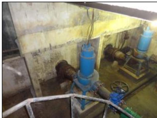
Figura 255- Vista externa do poço úmido (à esquerda) e vista das bombas submersíveis de poço seco (à direita)
