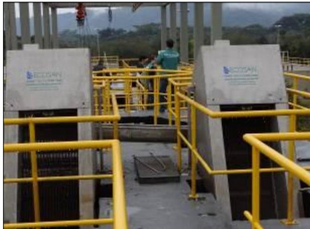
**Figura 66- Efluente bruto e área de recepção com gradeamento (Inicial)**
