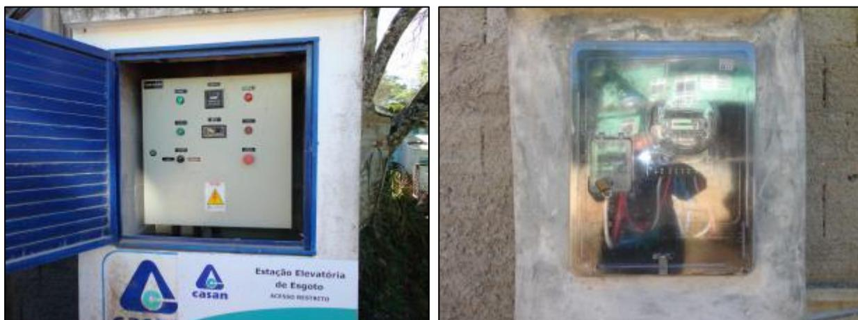
Figura 220- Quadro de comando (à esquerda) e quadro de energia (à direita)
