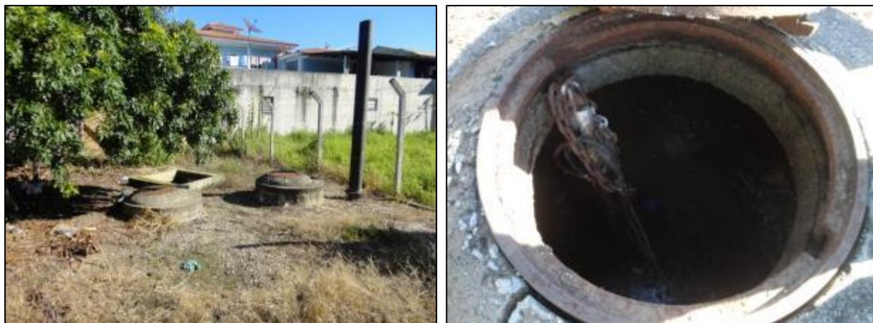
Figura 170- vista externa e interna do poço úmido
