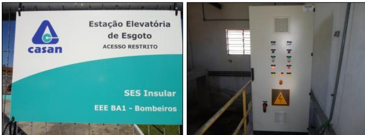
Figura 302- Placa de identificação e restrição de acesso (à esquerda) e quadro de comando (à direita)
