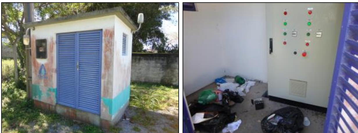
Figura 201- Vista externa e interna da casa de comando. É possível perceber entulho no interior da mesma
