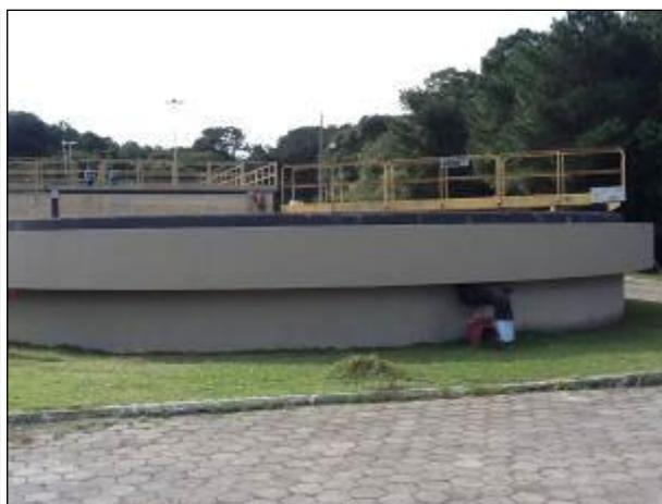
Figura 123- Reatores UASB e decantador (Inicial)
