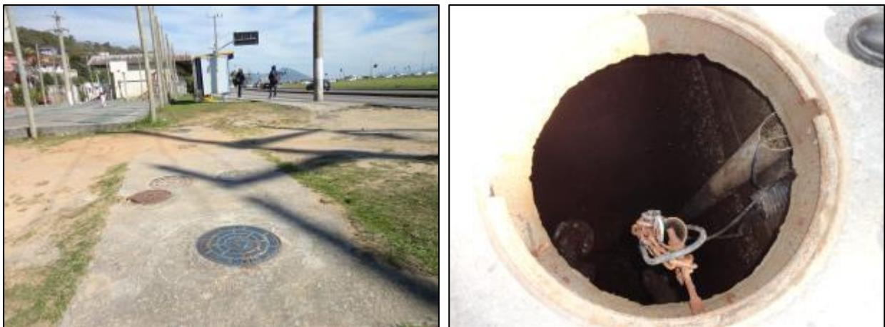
Figura 278- Vista externa e interna do poço úmido
