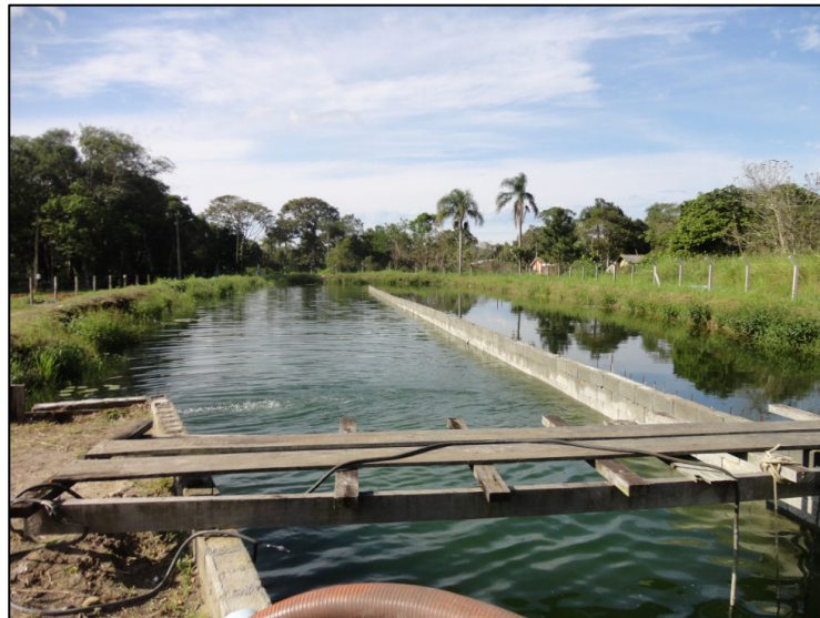
Figura 11 - Visão da nova área para descarte de água de extravasamento a qual é recirculada e novamente tratada.
