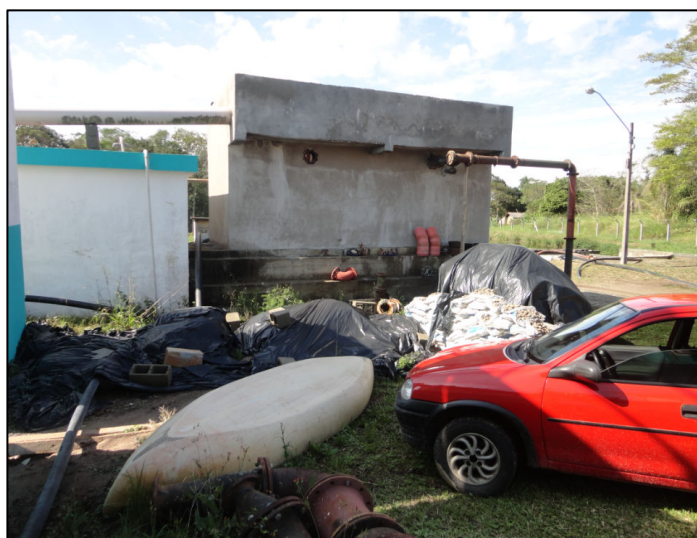
Figura 13 – Área da ETA verifica-se ainda em estado de obras.
