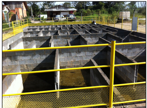
Figura 2 - Visão das novas chicanas de floculação antes (esquerda) e depois (direita) da última visita realizada.
