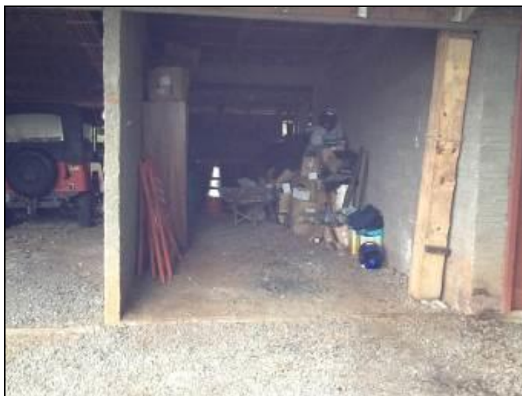
Figura 8: Almoxarifado sem acomodações dos materiais (acompanhamento)
