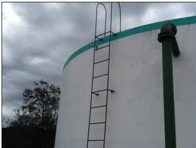
Figura 24: Escadas do R 01
