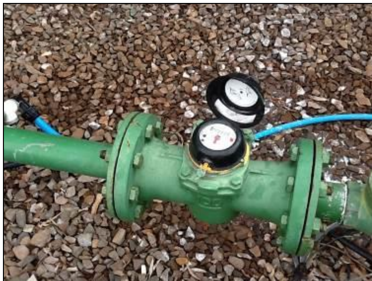
Figura 18: Macro medidor de saída (acompanhamento)
