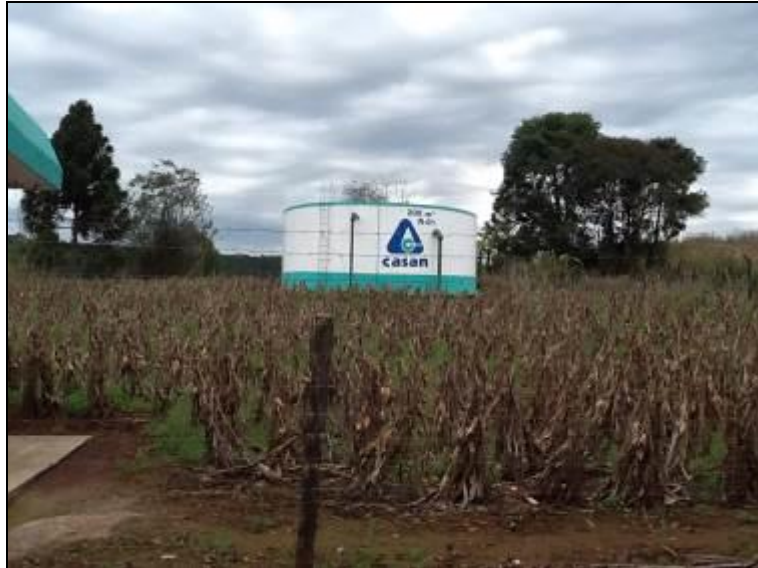
Figura 23: Acesso ao R 01
