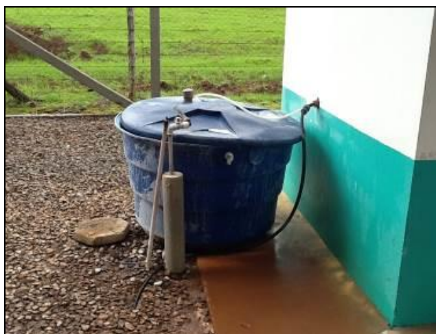
Figura 15: Tratamento Químico (acompanhamento)
