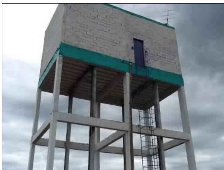
Figura 29: Escada do R-03
