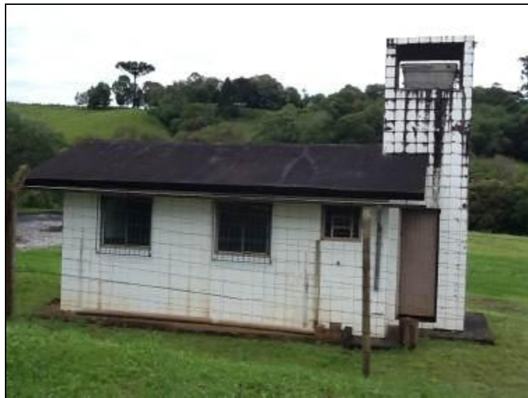
Estação de tratamento de Esgotos.
