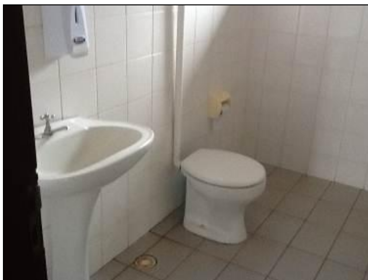
Sanitário do Escritório.
