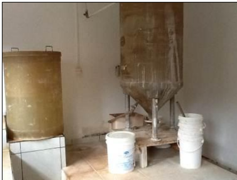
Casa de Química da ETA.
