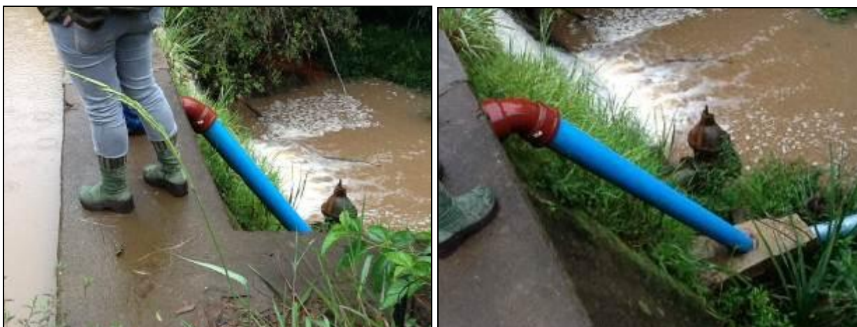
Estruturas da área de captação.
