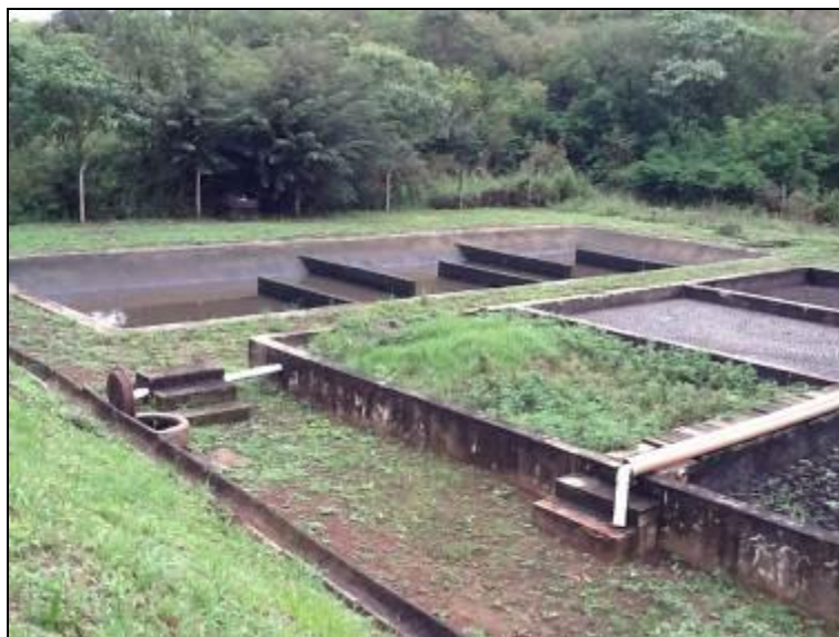
Leitos de secagem do lodo residual à direita da foto.
