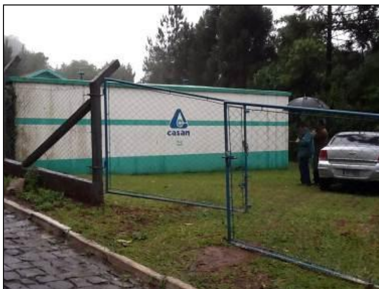
Acesso e entrada da ETA
