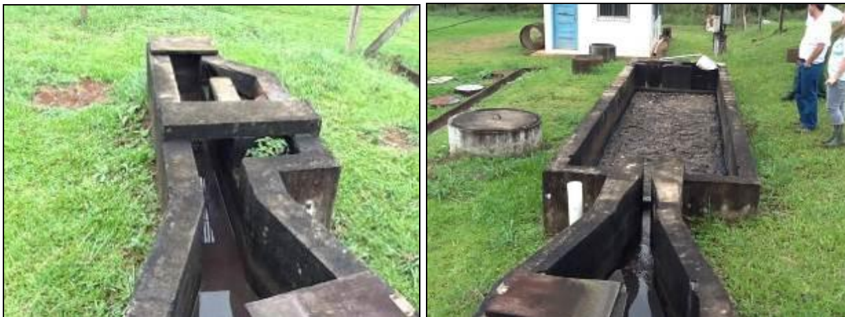
Estruturas de recepção.
