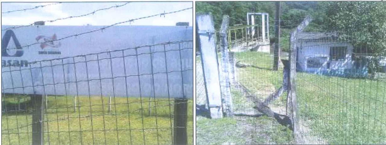
Figura 5: Proteção da área de captação da concessionária
