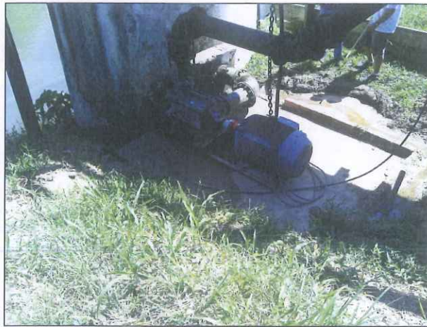
Figura 9: Conjunto moto-bomba da ERAB exposto
