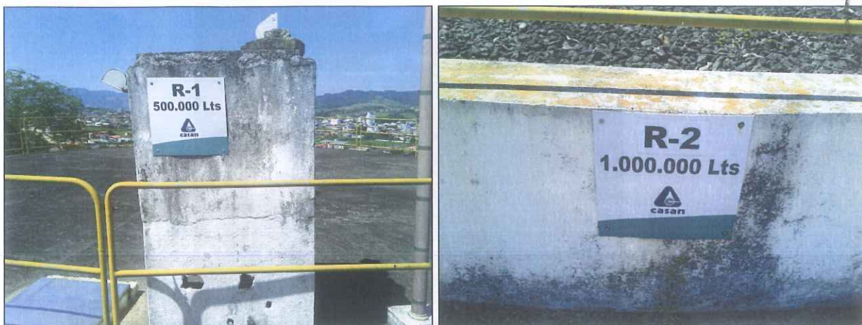
Figura 8: Identificação dos reservatórios R01 e R02 da ETA
