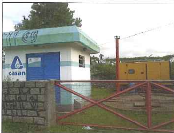
Figura 3: EEE Rio do Braz com gerador
