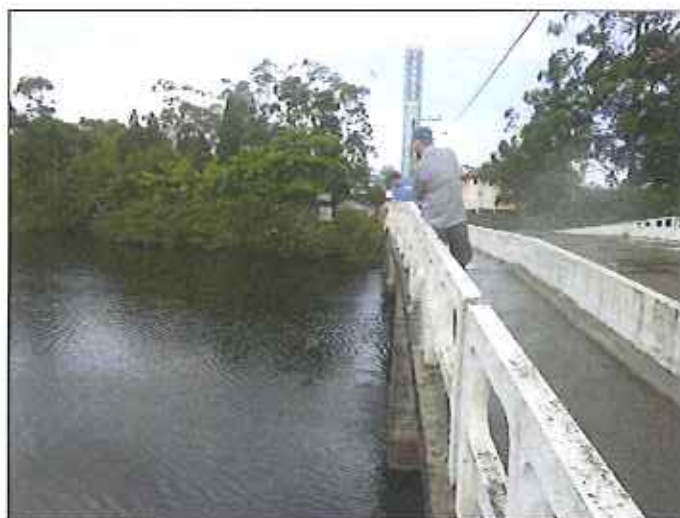
Figura 3: Coleta de amostra realizada no Ponto 2 do Rio do Braz (próximo à Estação Elevatória de Esgoto da Concessionária)
