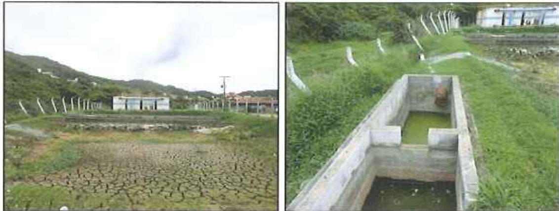
Figura 52: Imagens da ETE Praia Brava desativada (30/12/2015)
