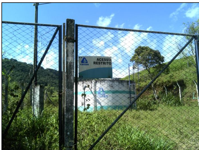
Figura 4: Placa de acesso restrito ao reservatório
