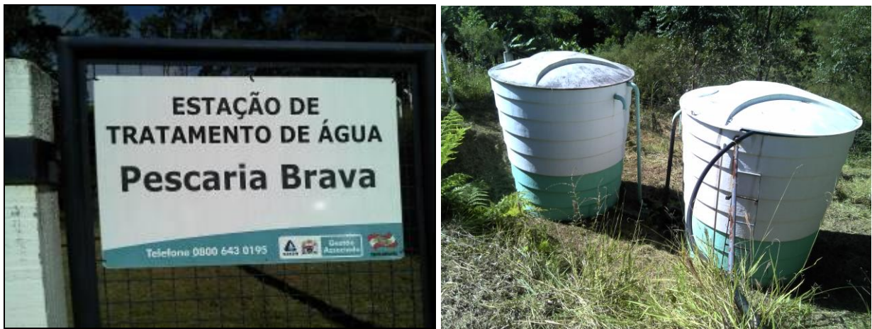
Figura 3: Identificação da área da ETA e dos Reservatórios (Acompanhamento n.021/2015)
