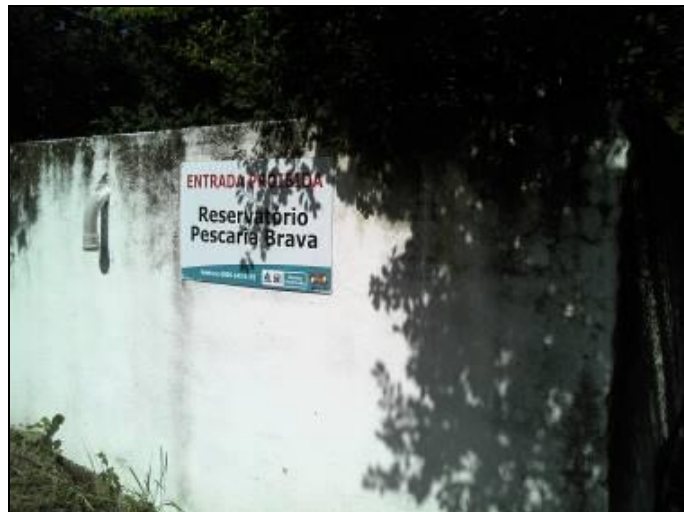
Figura 4: Placa de identificação (Acompanhamento n.021/2015)
