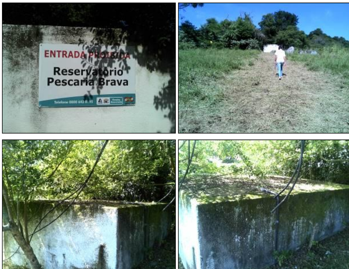
Figura 5: Identificação, acesso e estado do reservatório (Acompanhamento n.021/2015)
