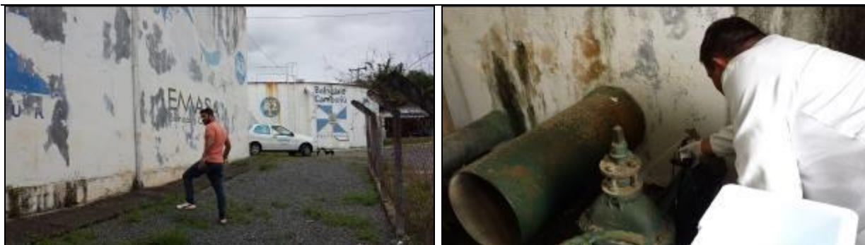
Figura 4: Coleta de amostra de água no Reservatório R02
