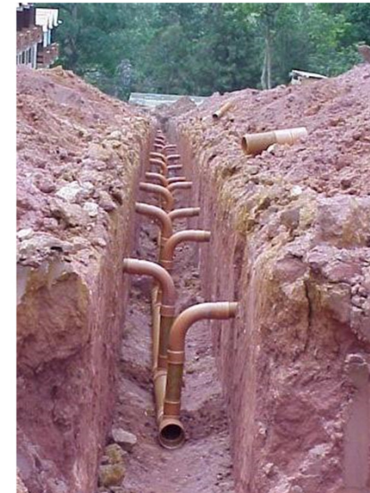
Rede coletora construída pelo incorporador de um loteamento.
