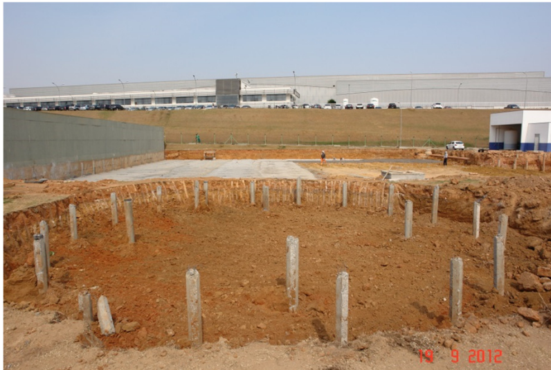
Terreno cedido pelo município para construção de ETE.
