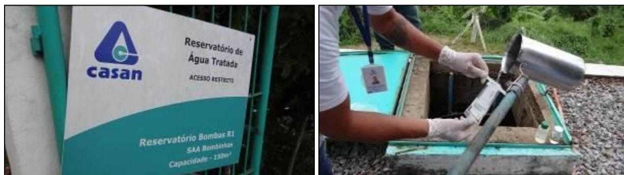
Figura 8: Coleta de amostra de água no Reservatório Bombas
