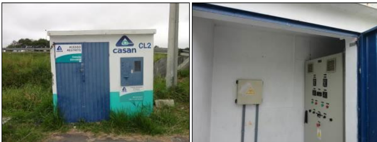
Figura 137: Vista externa e interna da casa de comando
