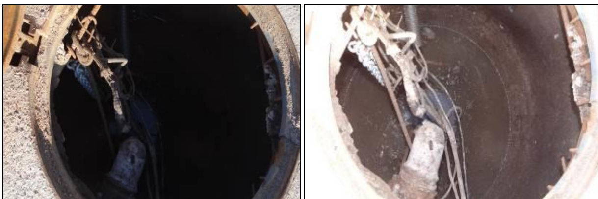
Figura 153: Vista interna do poço úmido
