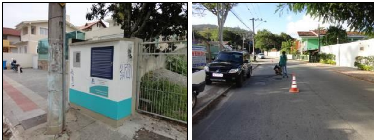
Figura 225: Vista externa da casa de comando e do poço úmido
