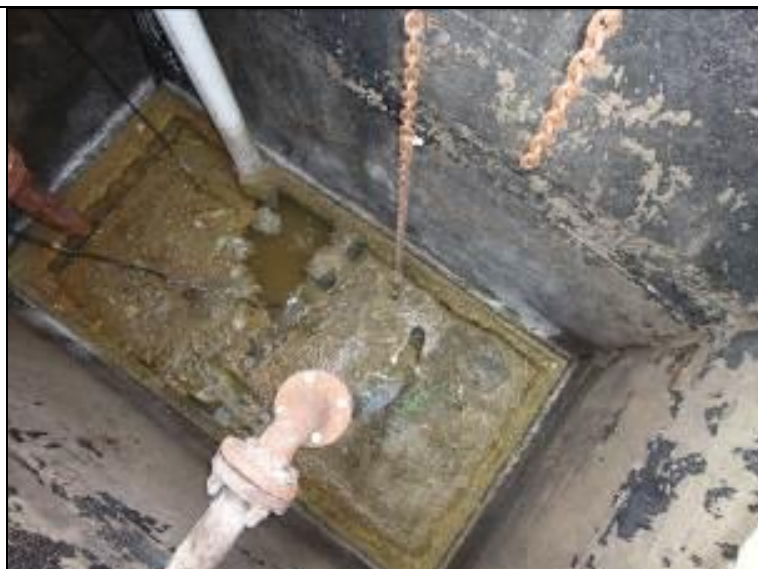
Figura 234: Vista interna do poço úmido
