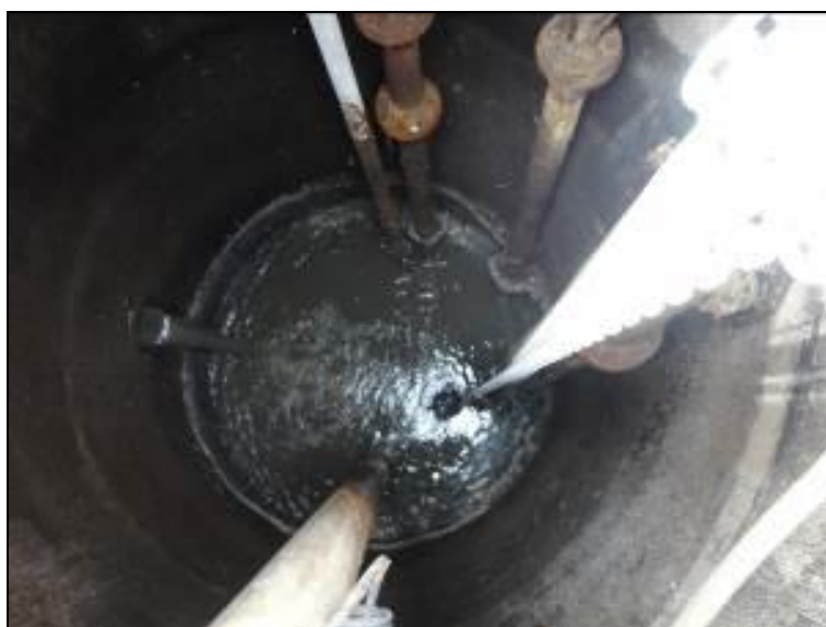
Figura 228: Vista interna do poço úmido
