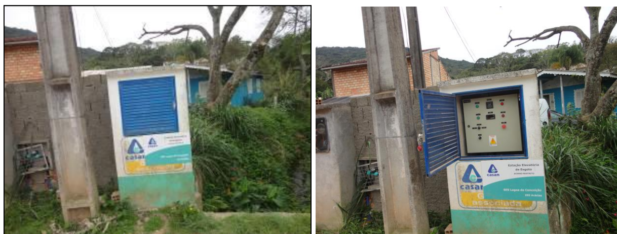
Figura 231: Vista Externa e interna da casa de comando
