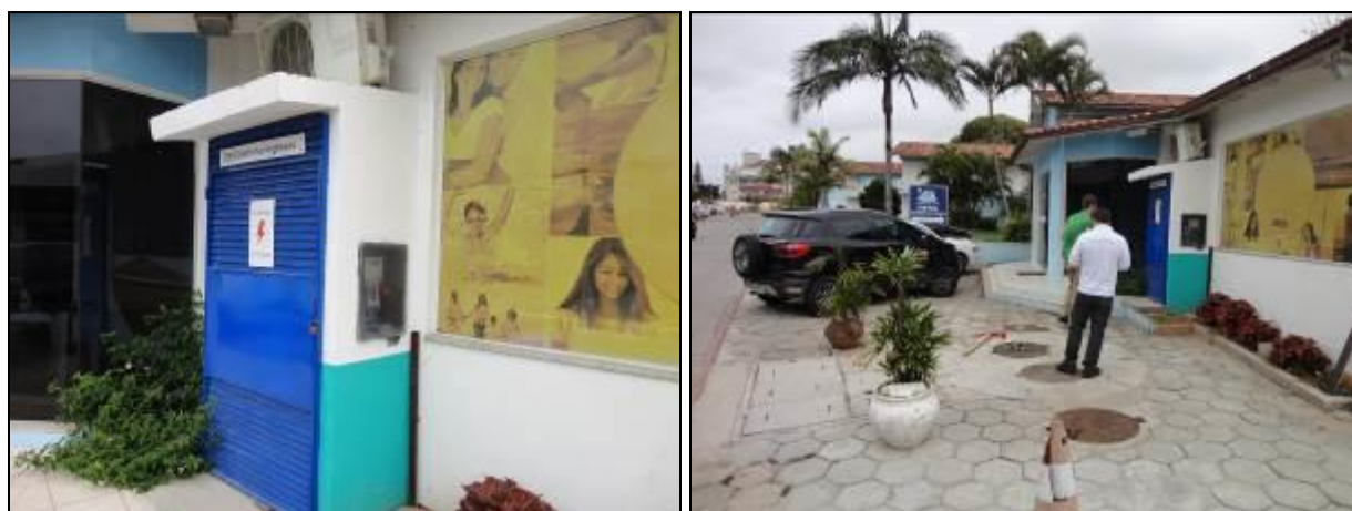
Figura 146: Vista externa da casa de comando e do poço úmido
