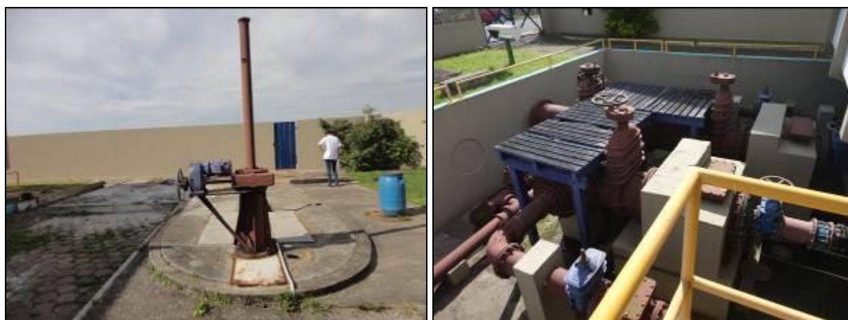
Figura 160: Vista da área interna da EEE
