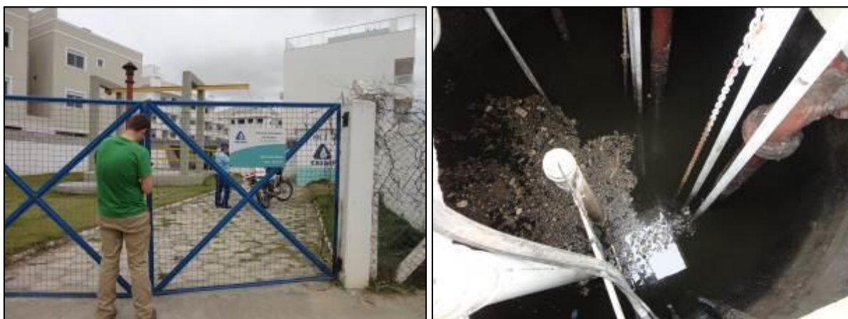
Figura 139: Vista do acesso da EEE e interna do poço úmido
