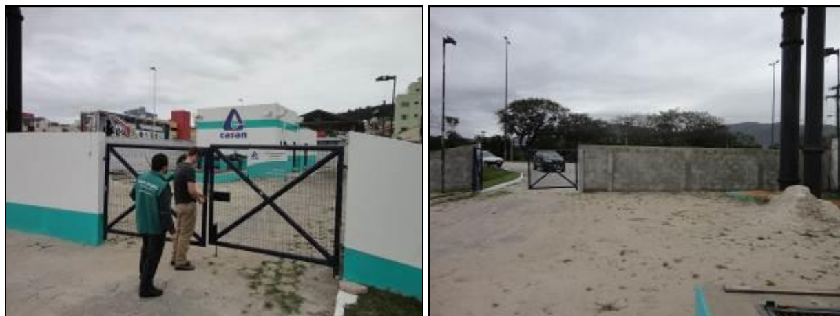
Figura 184: Vista externa e interna da EEE
