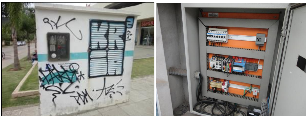
Figura 207: Vista externa e interna da casa de comando
