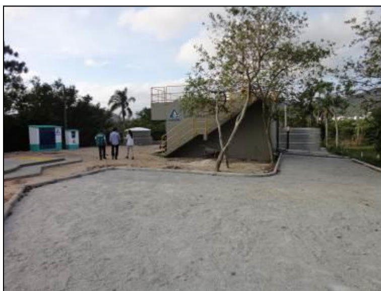
Figura 24: Vista geral da ETE Saco Grande
