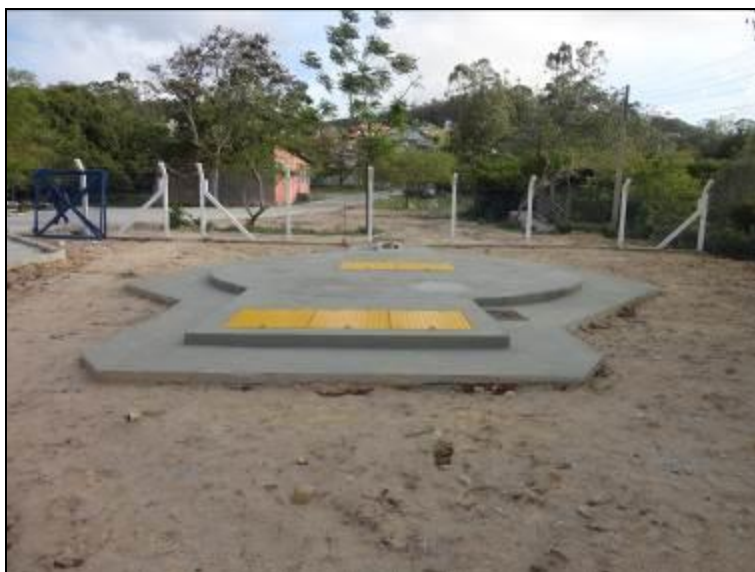
Figura 28: Estação Elevatória de Esgoto (chegada da ETE Saco Grande)
