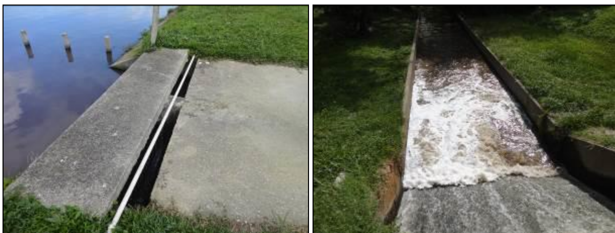
Figura 95: É dosado anti-espumante no efluente final
