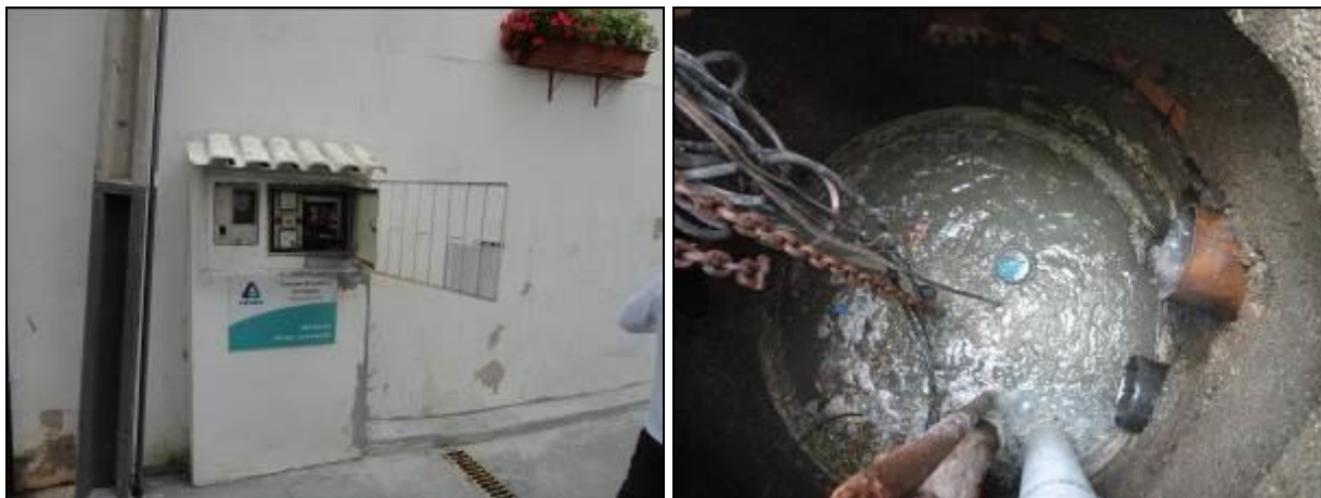
Figura 180: Vista da Casa de comando e do poço úmido
