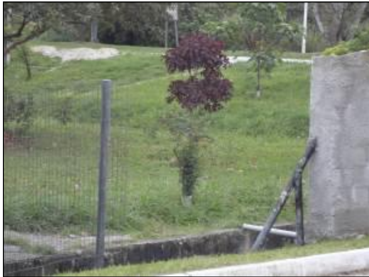
Figura 186: Vista da Área interna desprovida de cerca
