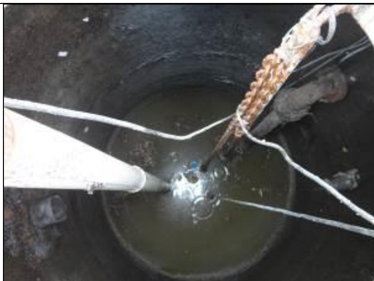
Figura 176: Vista interna do poço úmido
