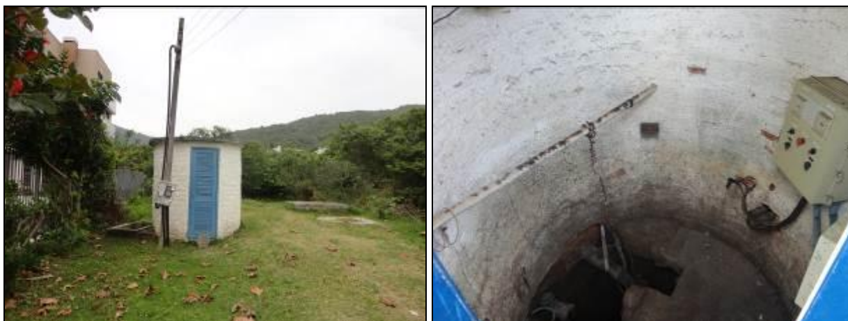
Figura 235: Vista externa e interna da casa de comando
