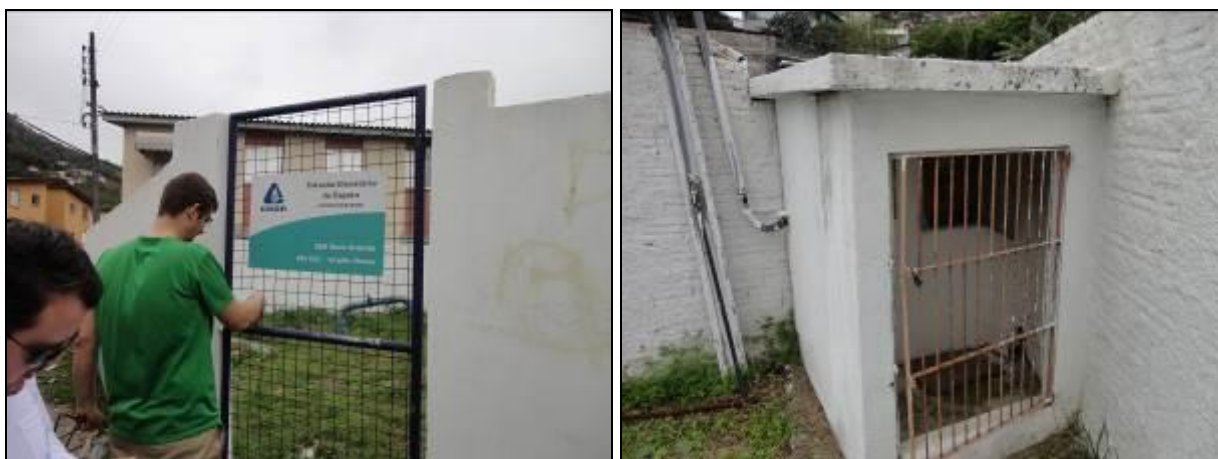
Figura 241: Vista externa da EEE e da casa de comando
