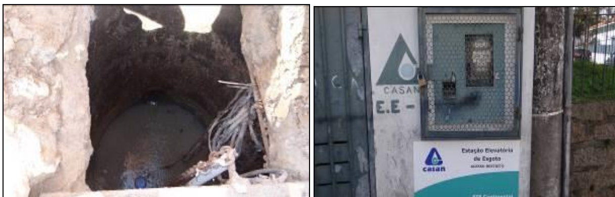
Figura 167: Vista do poço úmido e casa de comando
