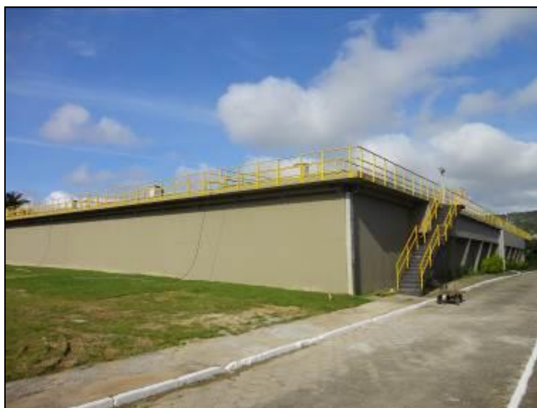
Figura 16: Tanque de aeração reestruturado
