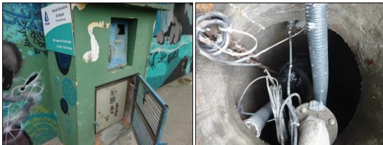
Figura 215: Vista da Casa de comando e do poço úmido
