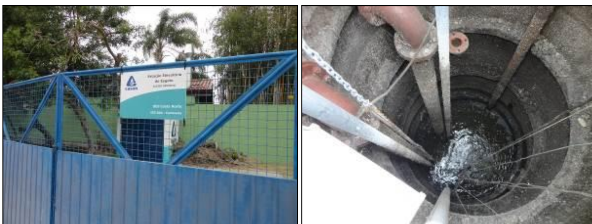
Figura 129: Vista do acesso da estação elevatória e poço úmido
