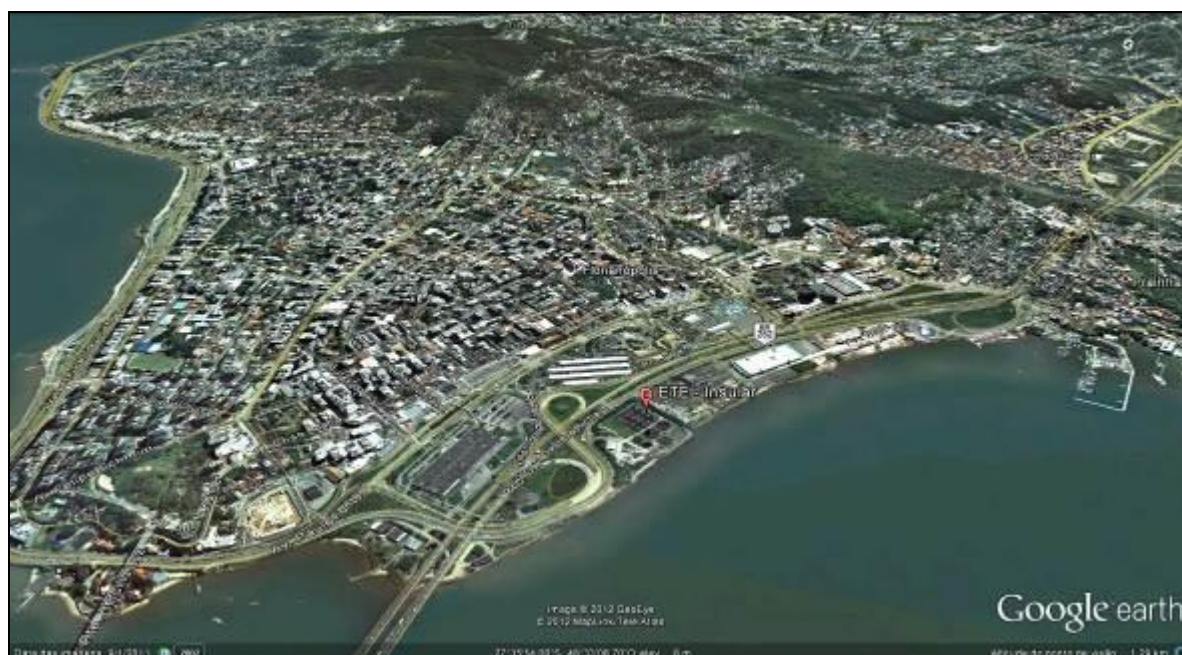
Figura 1: Localização da ETE Insular (Fonte: Google Earth)
