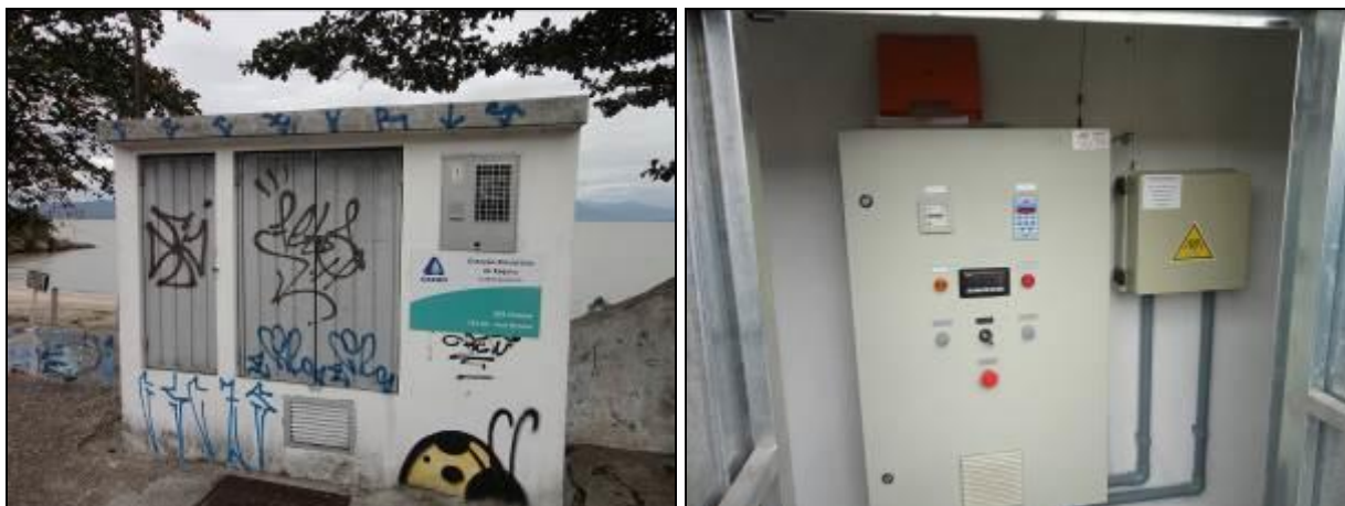
Figura 209: Vista externa e interna da casa de comando
