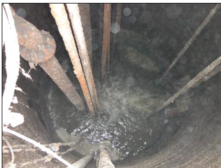
Figura 120: Vista interna do poço úmido
