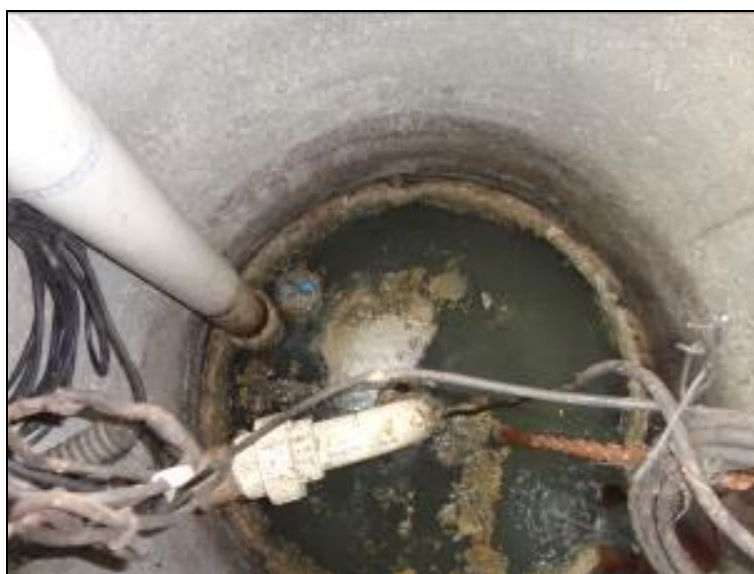
Figura 134: Poço úmido
