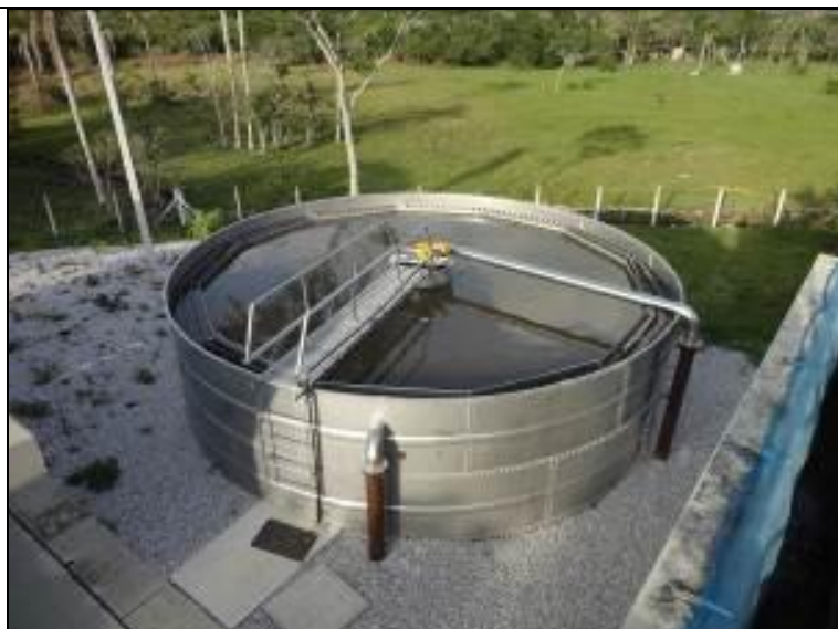
Figura 26: Decantador (novo)
