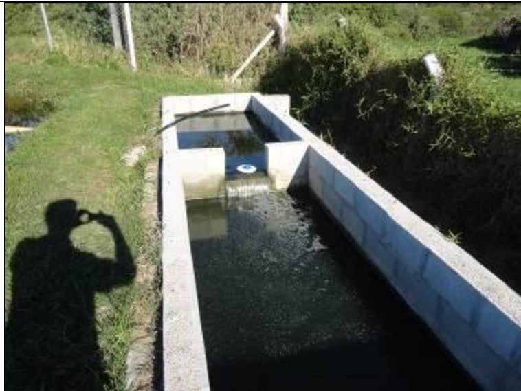
Figura 54: Local de desinfecção com cloro
