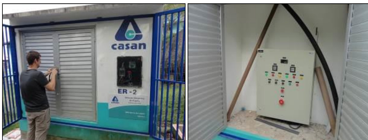
Figura 111: Vista externa e interna da Casa de Comando
