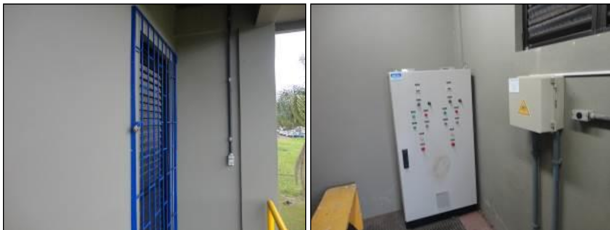
Figura 192: Vista externa e interna da casa de comando
