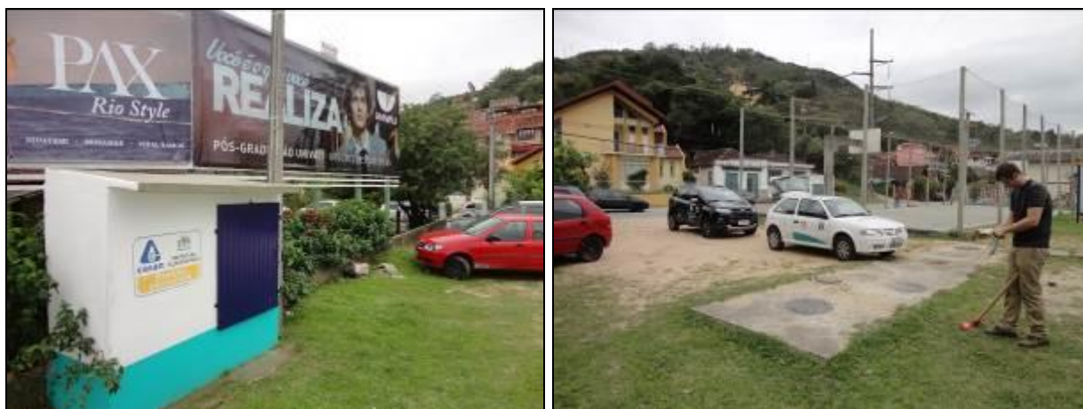
Figura 197: Vista externa da casa de comando e do poço úmido
