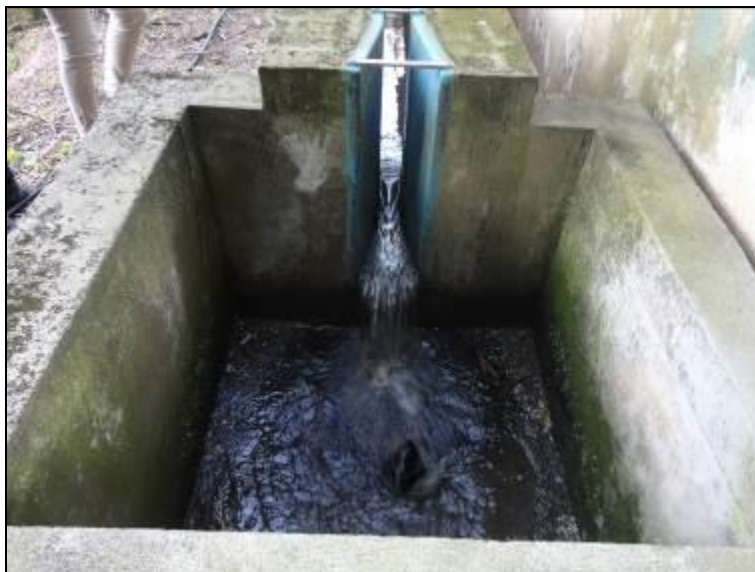
Figura 32: Calha Parshall do efluente tratado
