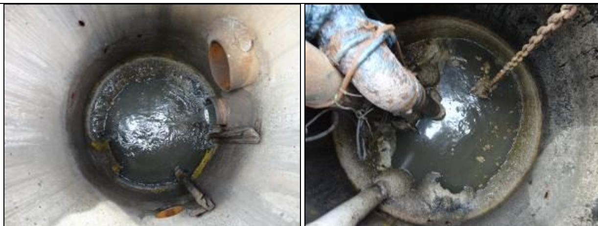
Figura 226: Vista interna do poço de chegada do efluente e do poço úmido
