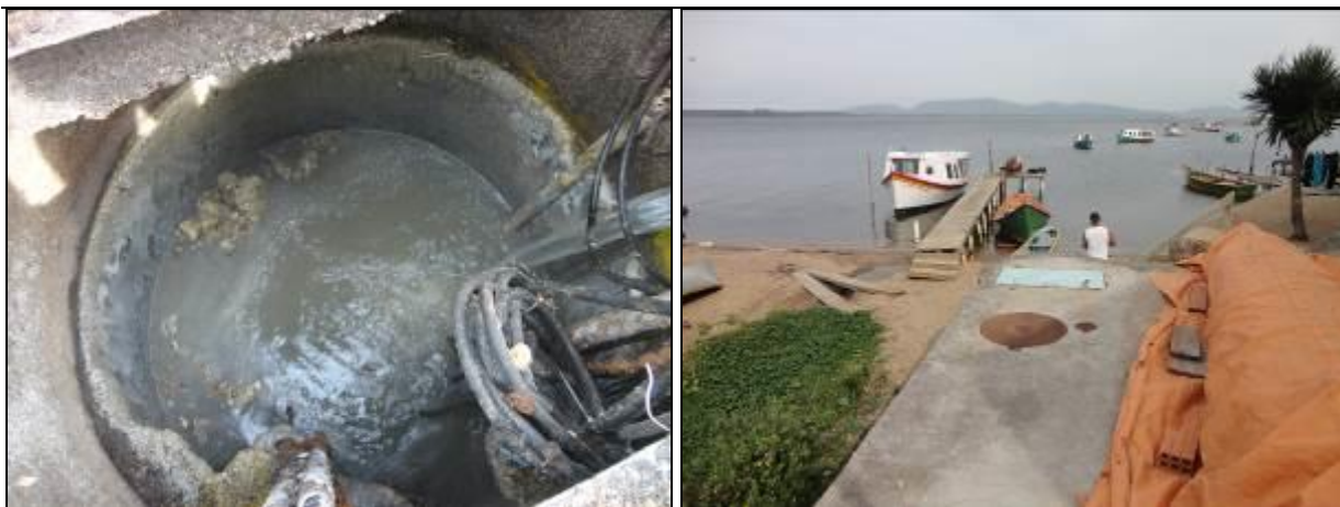
Figura 112: Vista interna e externa do poço úmido
