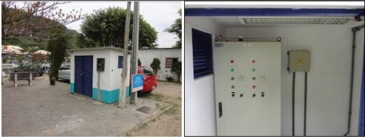
Figura 107: Vista interna e externa da Casa de Comando
