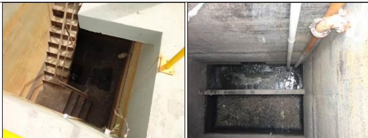
Figura 125: Gradeamento e poço úmido
