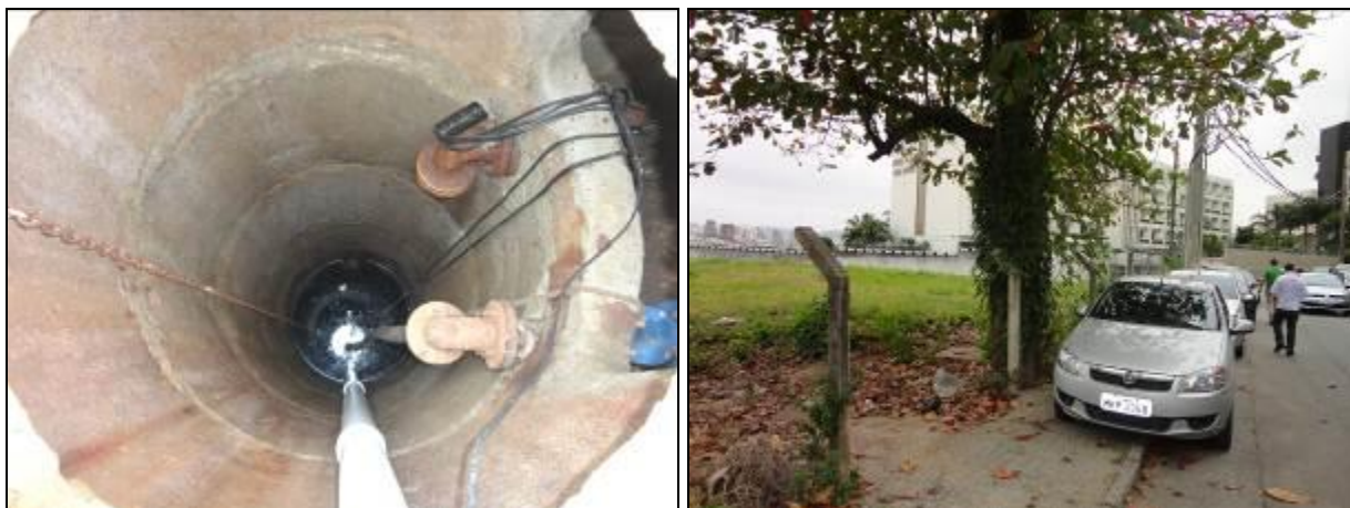
Figura 182: Vista interna do poço úmido e área externa da EEE
