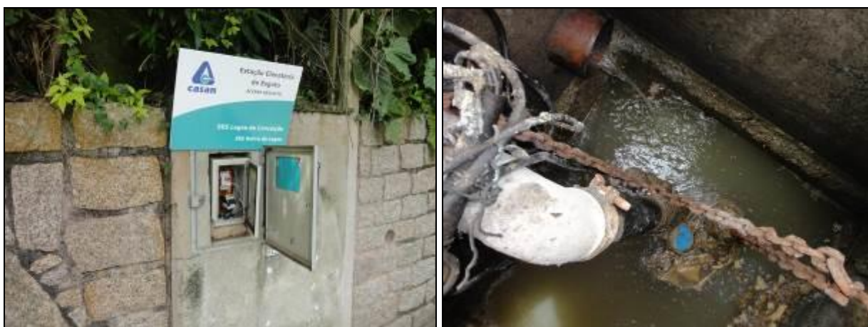
Figura 218: Vista externa e interna da casa de comando e interna do poço úmido
