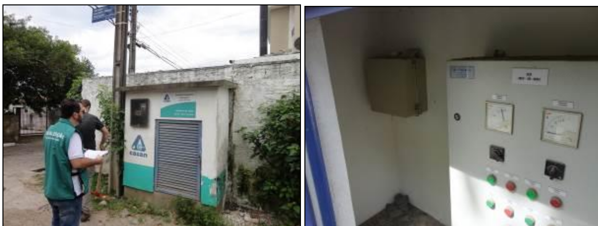
Figura 100: Vista externa e interna da casa de comando
