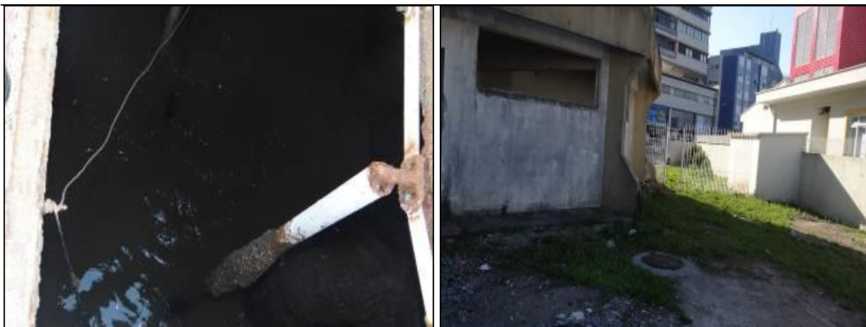
Figura 149: Vista interna do poço úmido e entorno da EEE com estrutura abandonada
