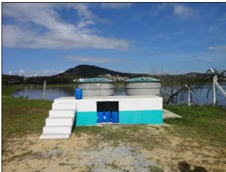
Figura 97: Armazenamento dos produtos químicos
