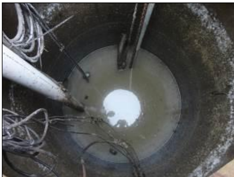
Figura 188: Vista interna do poço úmido
