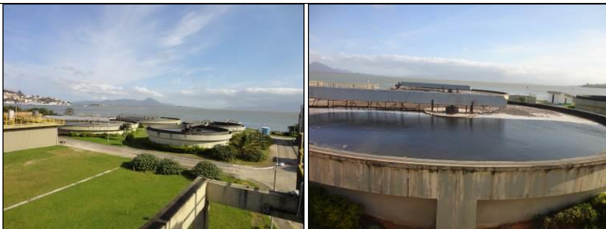
Figura 11: Decantadores e adensadores de lodo
