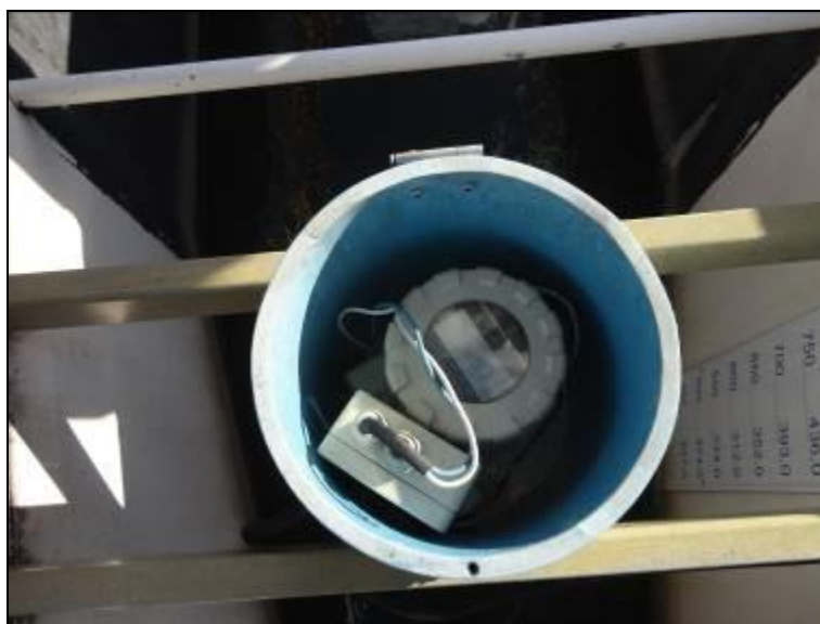
Figura 38: Medidor de vazão
