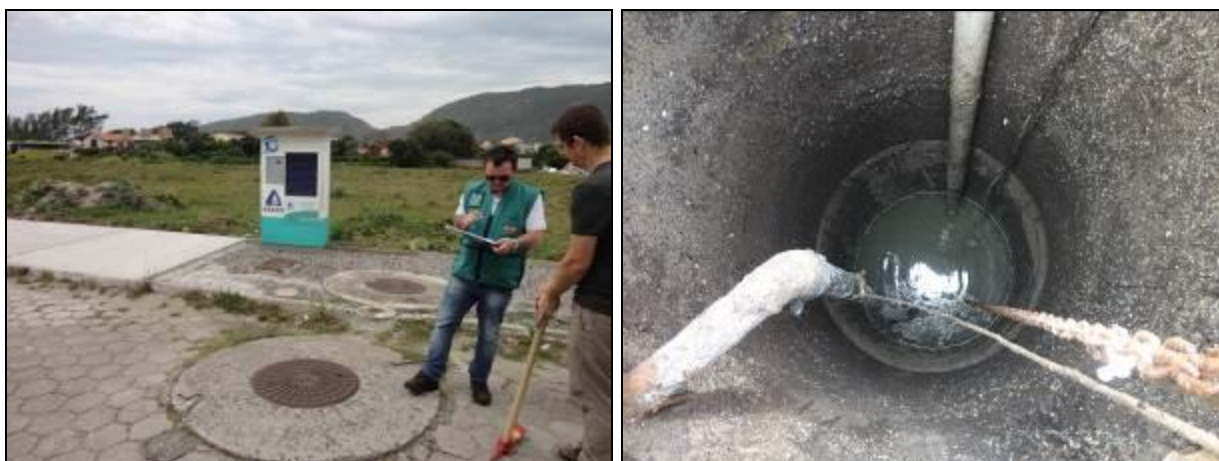
Figura 105: Vista interna e externa do Poço Úmido
