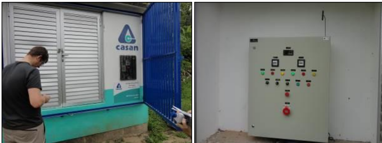
Figura 113: Vista externa e interna da casa de comando
