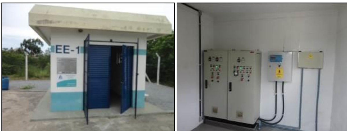
Figura 123: Vista externa e interna da casa de comando
