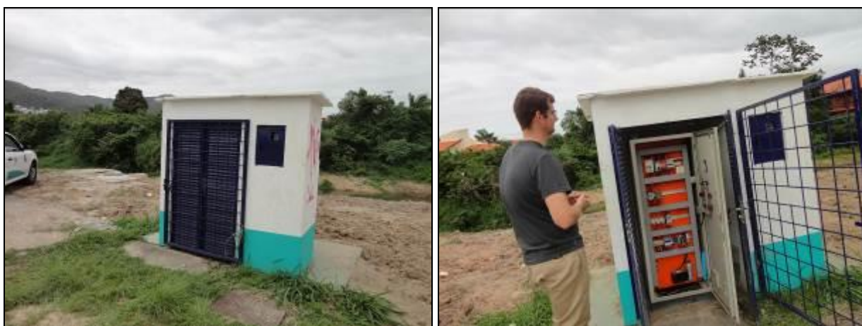
Figura 187: Vista externa e interna da casa de comando
