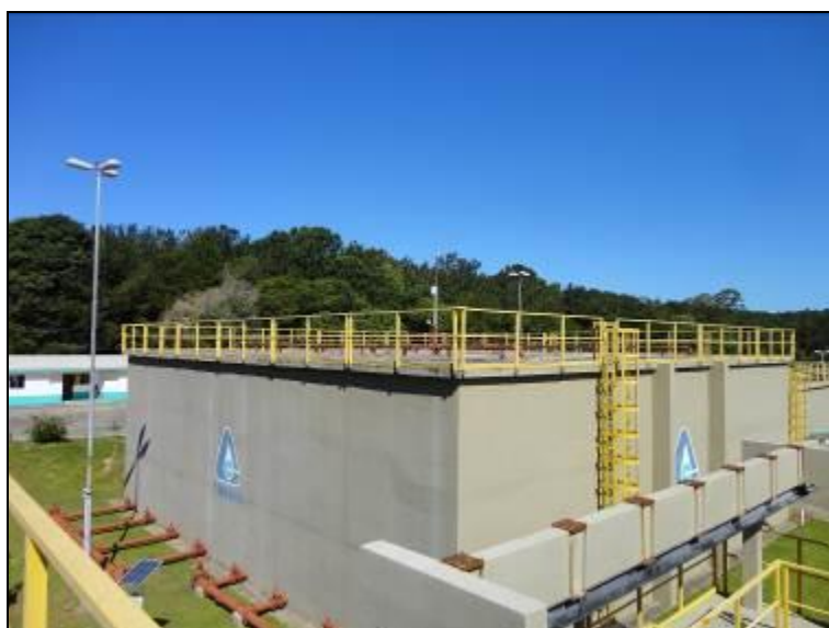
Figura 78: Reator UASB
