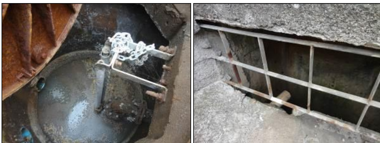
Figura 200: Vista interna do poço úmido e saída do extravasor em direção ao canal existente
