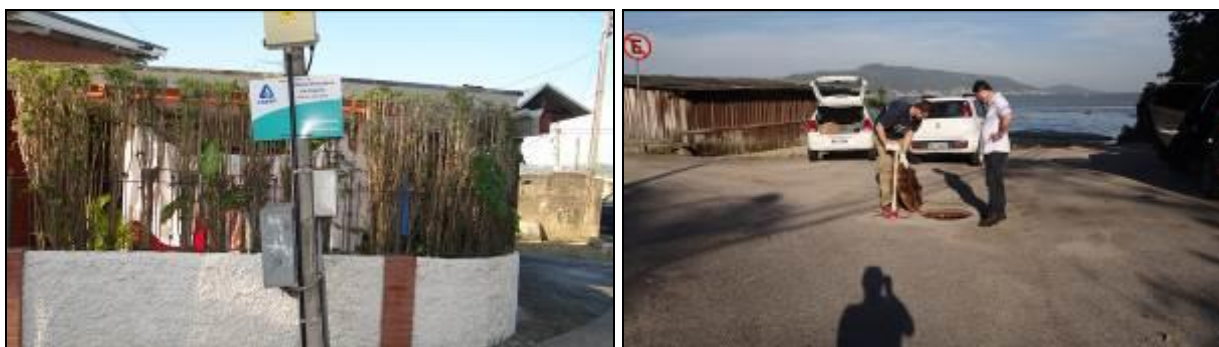
Figura 152: Vista do quadro de comando e quadro de energia localizado na calçada e vista externa do poço úmido
