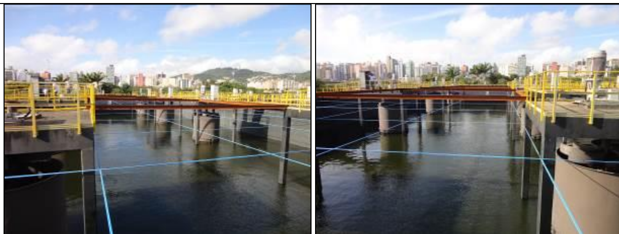
Figura 17: Tanque de aeração com efluente tratado
