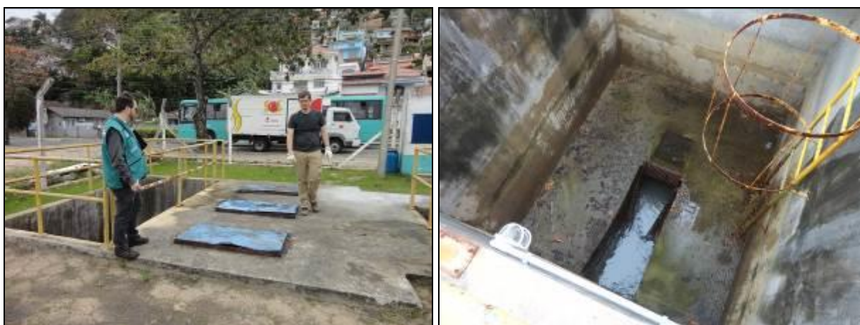
Figura 201: Vista externa e interna do poço de chegada do efluente
