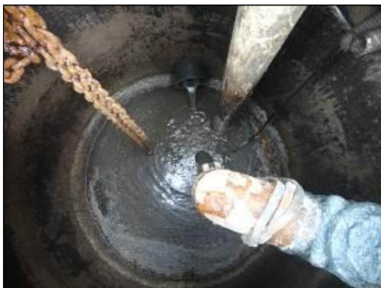
Figura 224: Vista interna do poço úmido
