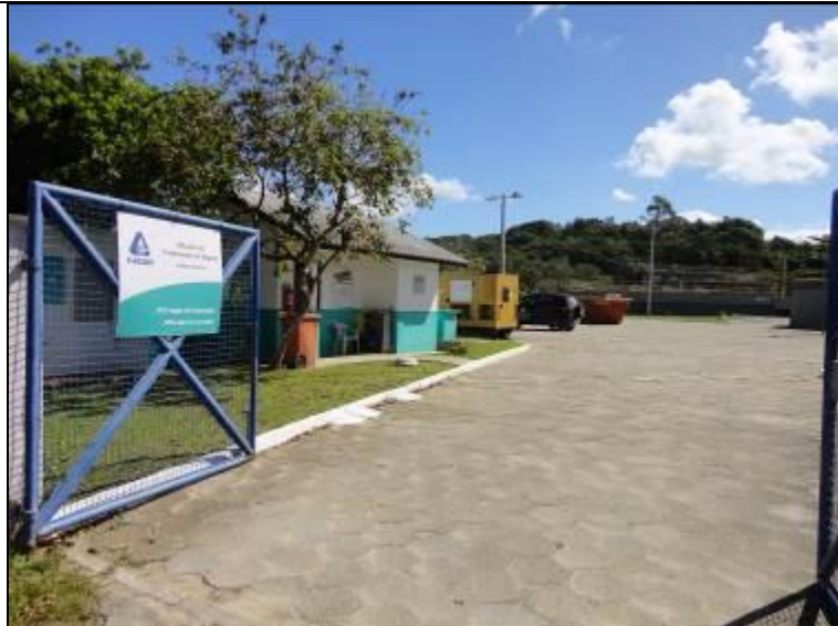
Figura 60: Acesso à ETE
