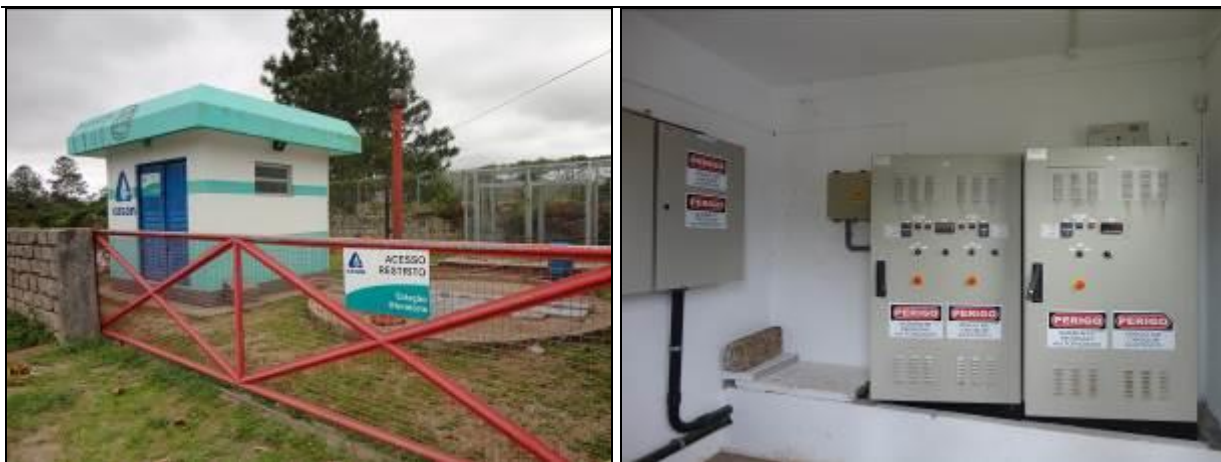
Figura 119: Vista externa e interna da casa de comando
