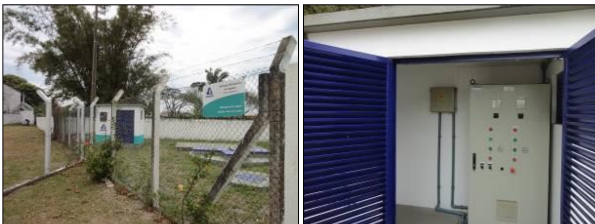
Figura 109: Vista externa e interna da Casa de Comando
