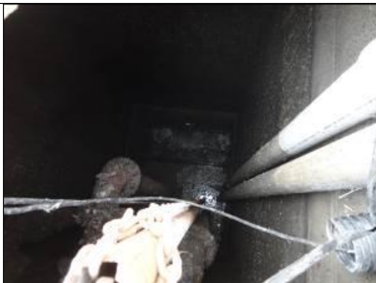
Figura 198: Vista interna do poço úmido
