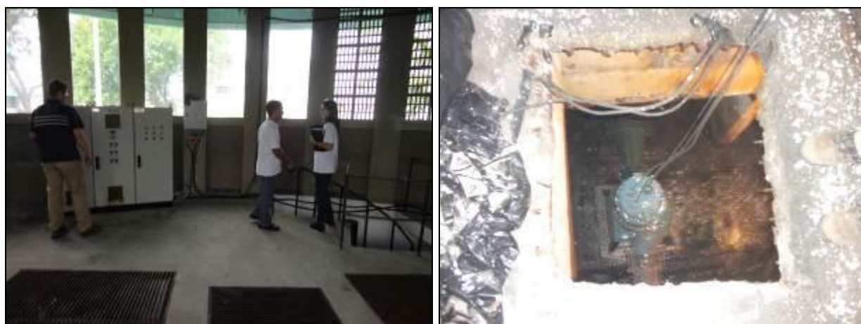
Figura 166: Vista interna da EEE e poço de sucção
