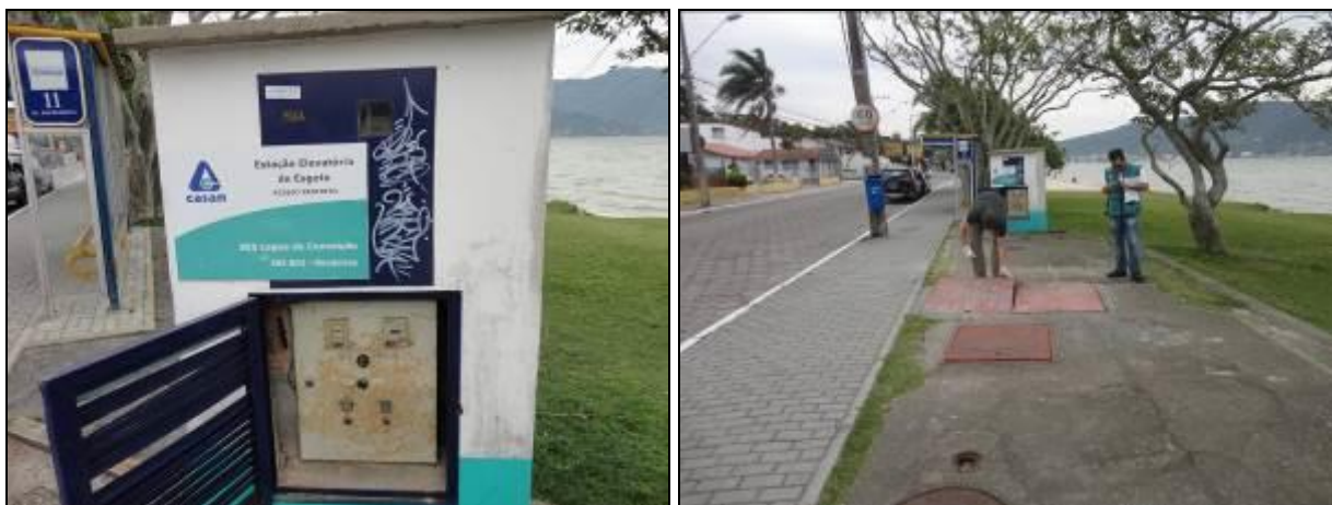
Figura 216: Vista externa da Casa de comando e do poço úmido
