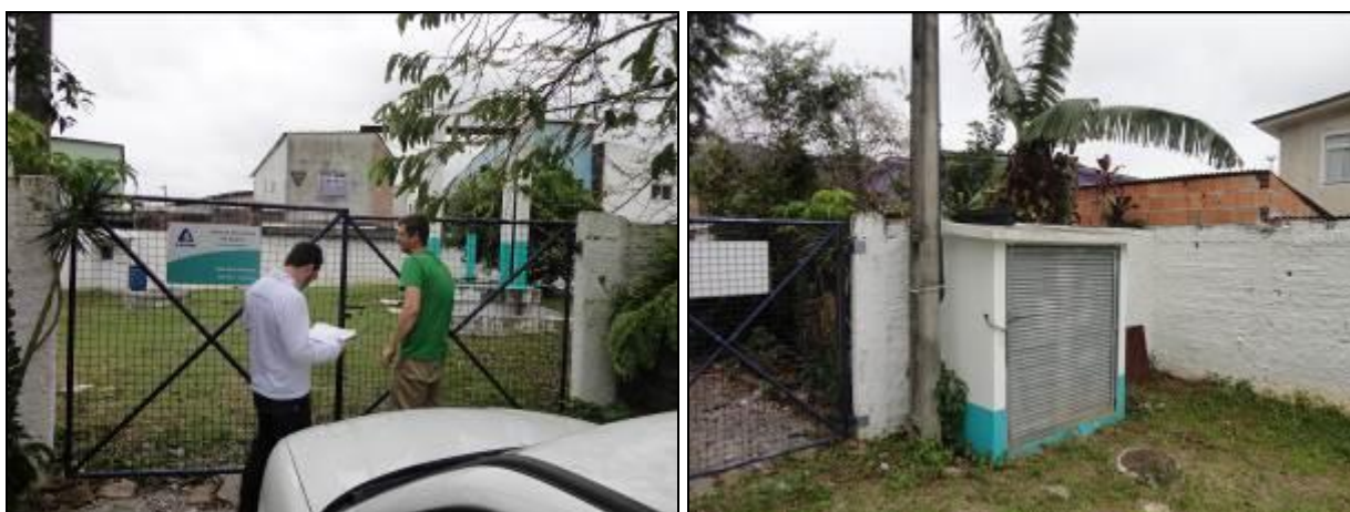
Figura 239: Vista interna da EEE e externa da casa de comando
