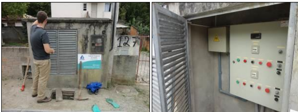
Figura 211: Vista externa e interna da casa de comando
