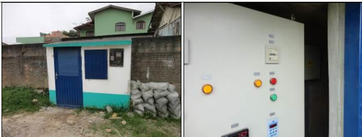
Figura 205: Vista externa e interna da casa de comando
