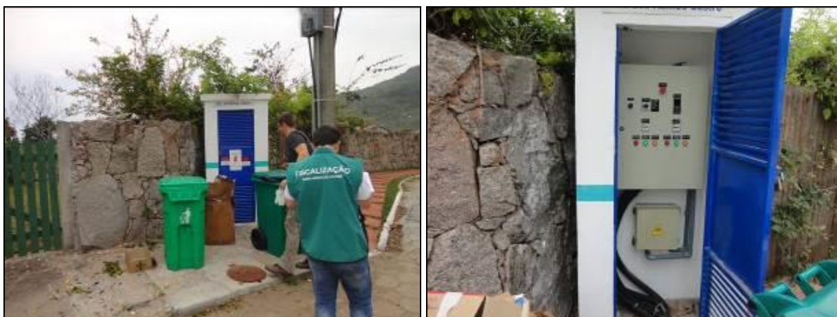
Figura 237: Vista externa e interna da casa de comando
