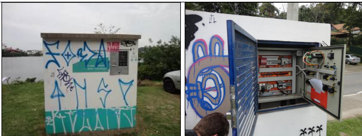
Figura 227: Vista externa e interna da casa de comando
