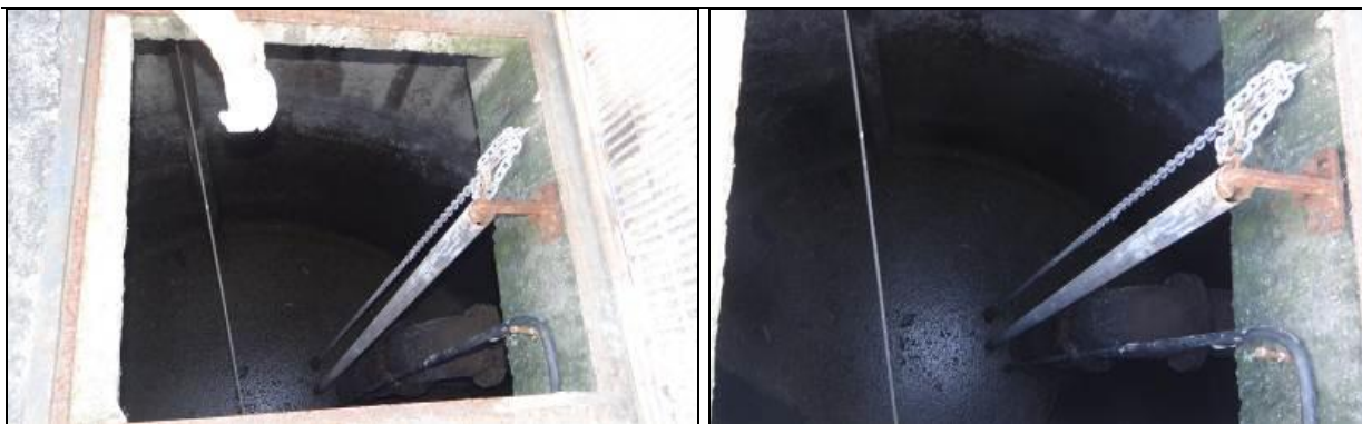
Figura 164: Vista interna do poço úmido
