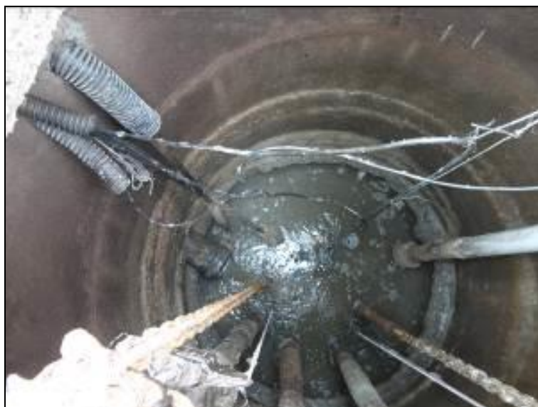
Figura 240: Vista interna do poço úmido
