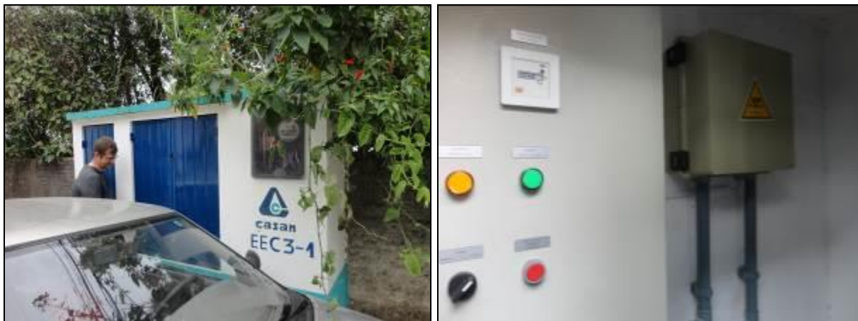
Figura 199: Vista externa e interna da casa de comando
