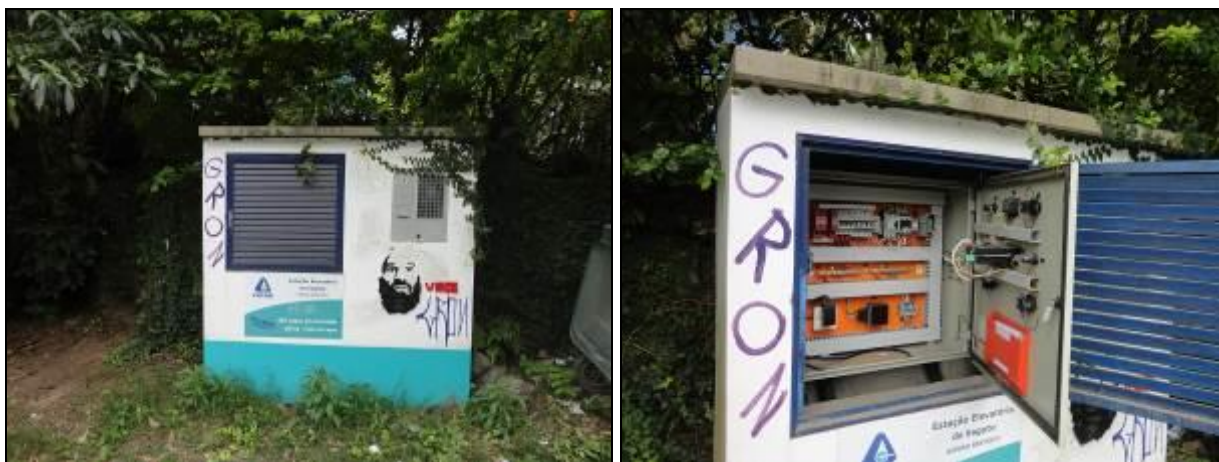
Figura 223: Vista externa e interna da Casa de Comando
