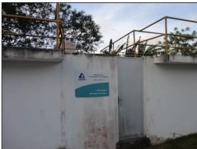
Figura 30: Entrada da ETE
