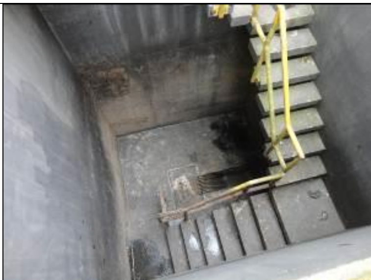
Figura 190: Vista interna do poço de chegada do efluente
