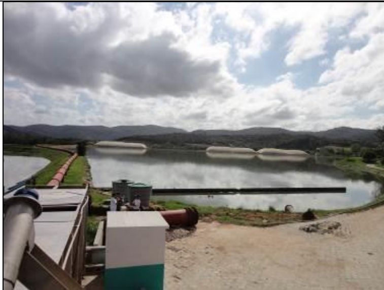
Figura 86: Vista geral da ETE Potecas
