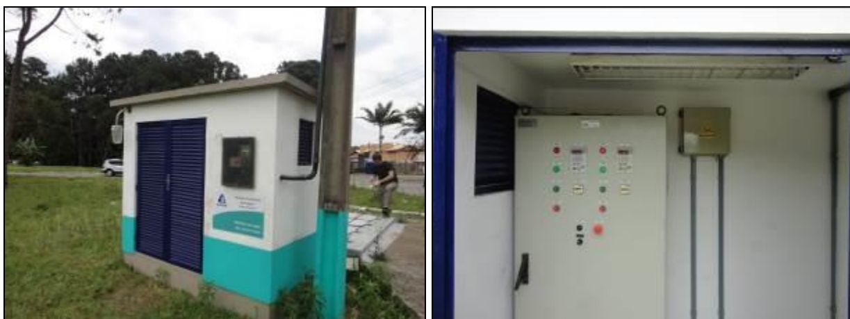
Figura 103: Vista externa e interna da Casa de comando
