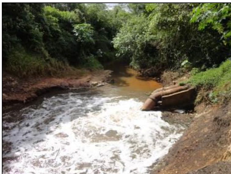
Figura 96: Local de despejo do efluente final com o Rio
