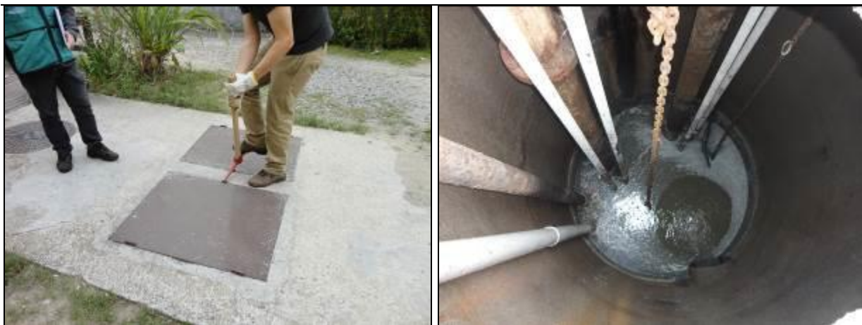
Figura 204: Vista externa e interna do poço úmido
