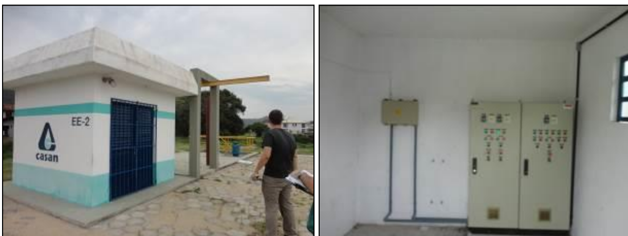
Figura 126: Vista externa e interna da casa de comando
