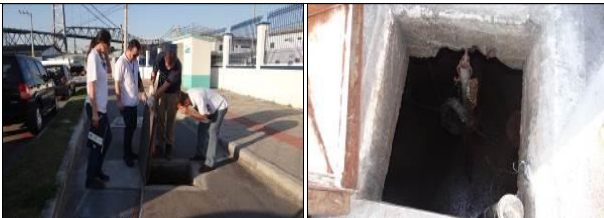
Figura 150: Vista geral da EEE e interna do poço úmido
