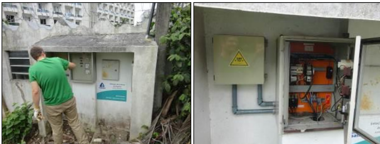
Figura 181: Vista externa e interna da casa de comando
