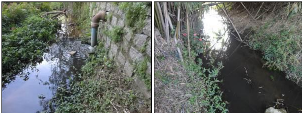
Figura 33: Córrego ao lado da ETE onde ocorre o lançamento do efluente final
