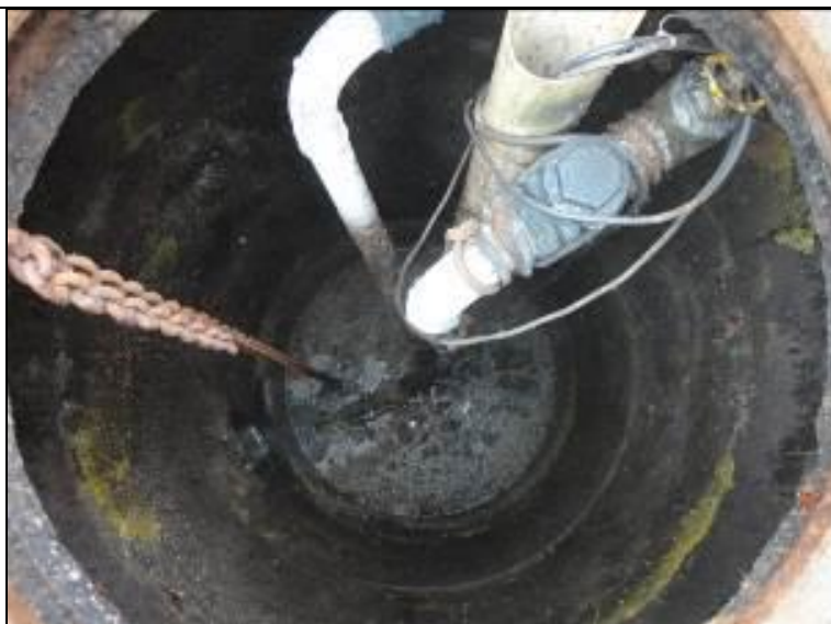
Figura 232: Vista interna do poço úmido
