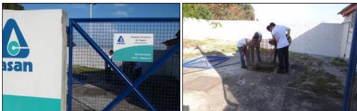
Figura 163: Entrada da EEE e vista externa do poço úmido
