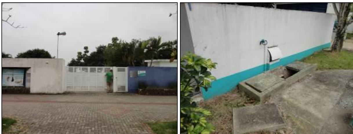
Figura 178: Vista externa e interna da EEE
