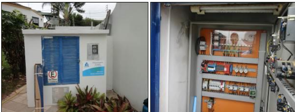
Figura 175: Vista externa e interna da casa de comando
