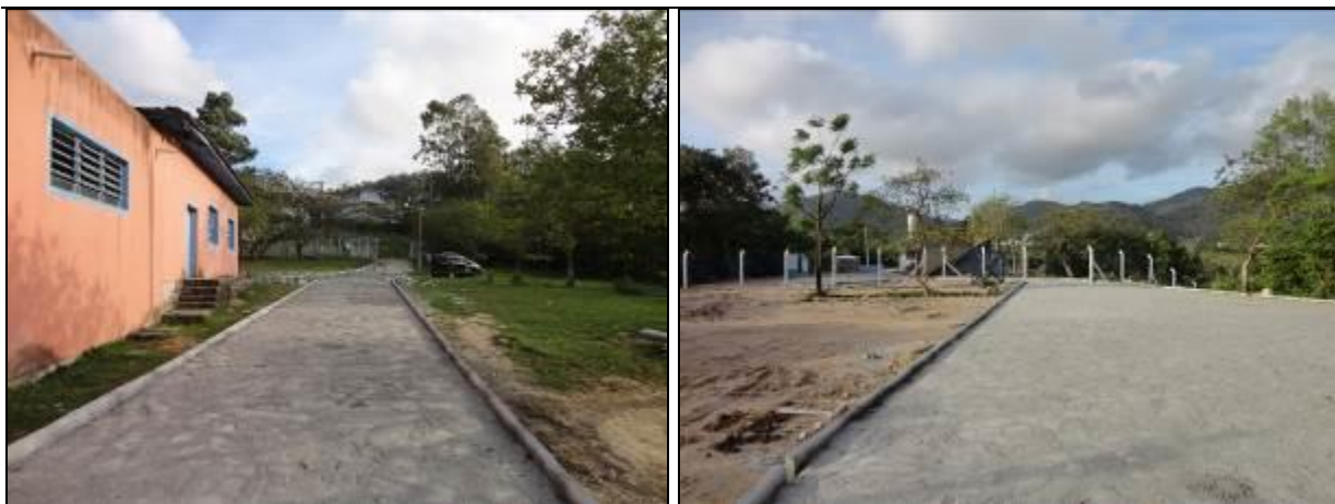
Figura 22: Acesso sendo reformado
