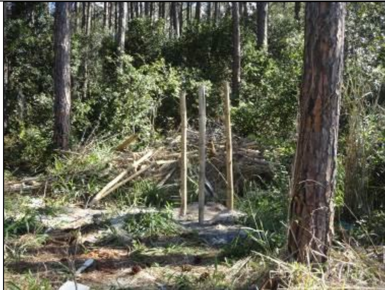
Figura 84: Poço de monitoramento
