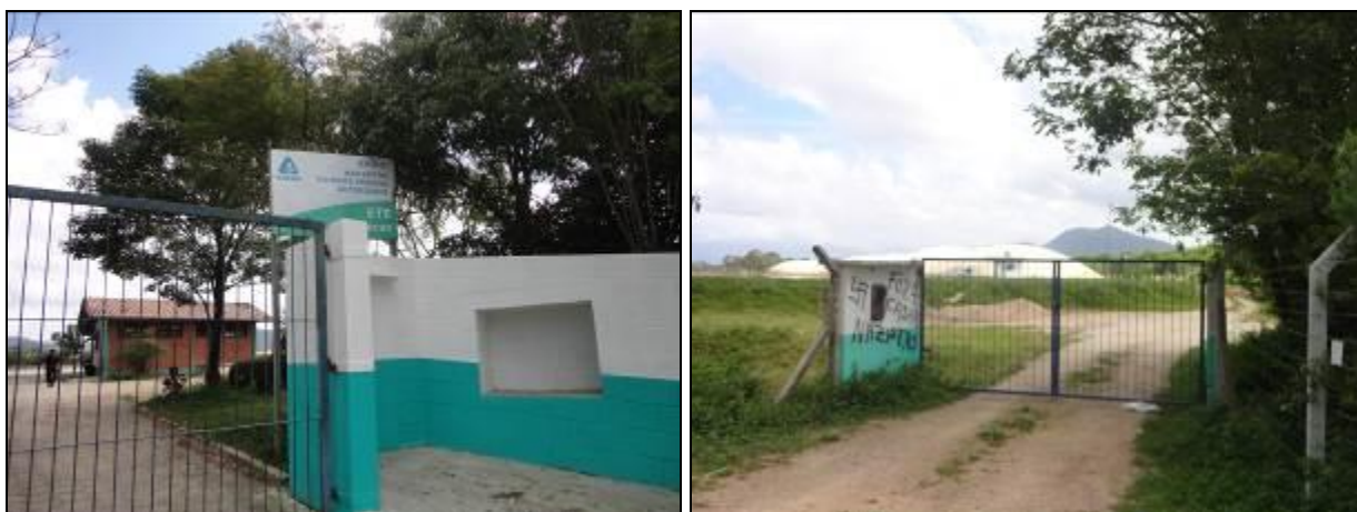
Figura 88: Acesso à ETE
