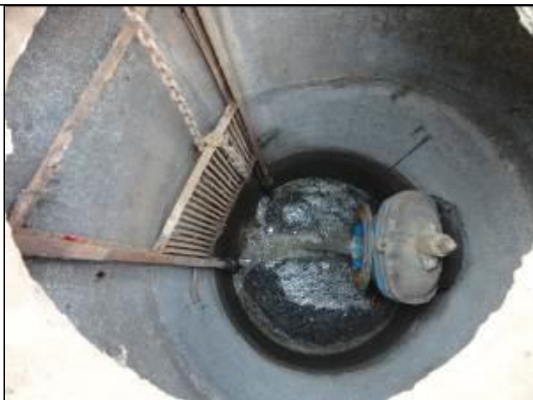
Figura 210: Vista interna do poço úmido
