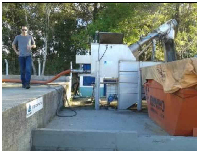
Figura 47: Pré-tratamento do efluente dos caminhões limpa-fossas
