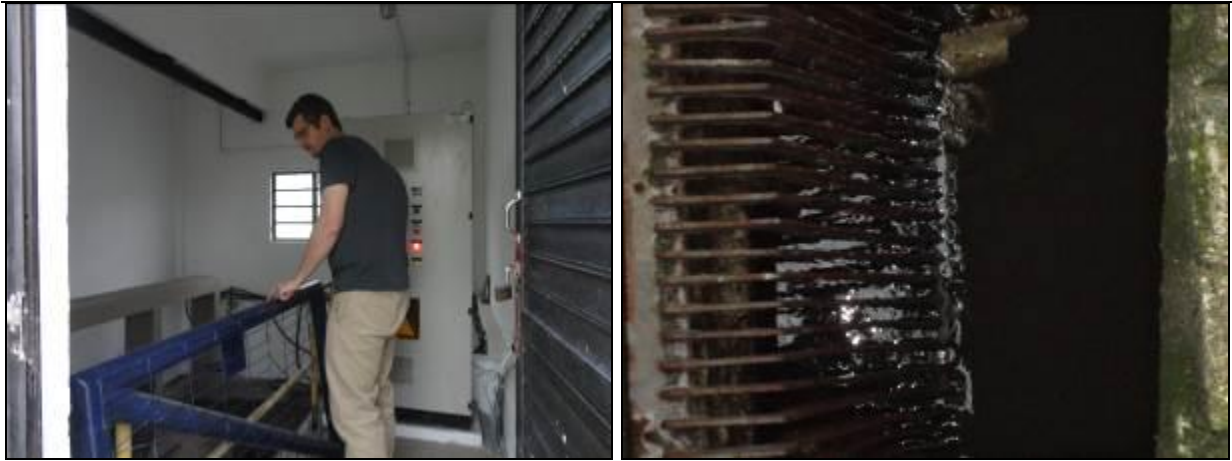
Figura 185: Vista da Casa de comando e gradeamento da EEE
