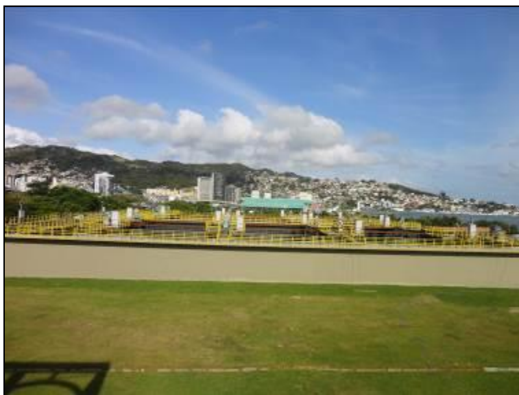
Figura 9: Vista dos tanques de aeração
