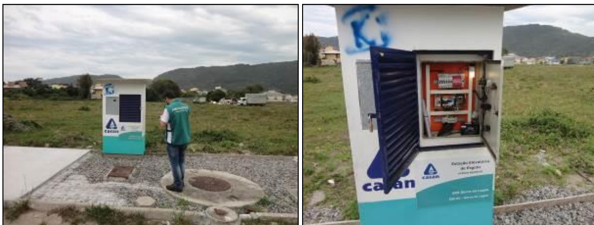
Figura 104: Vista interna e externa da Casa de Comando
