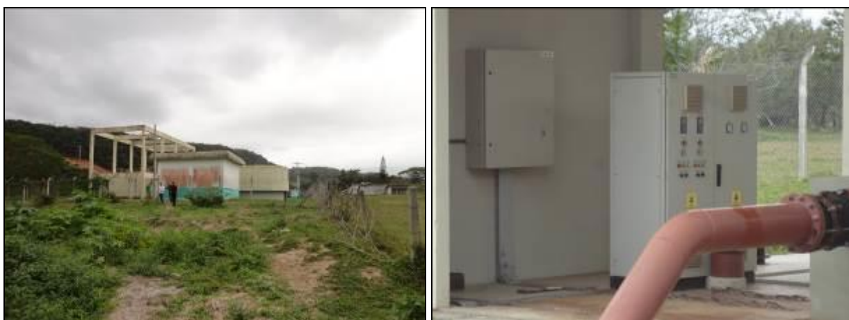
Figura 142: Vista dos fundos da ETE e casa de comando
