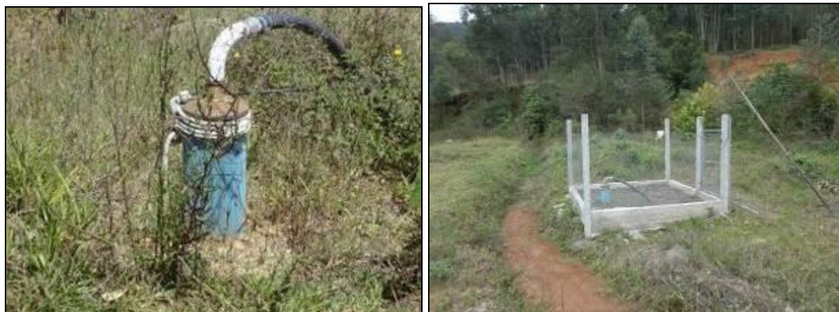
Figura 5: Poço subterrâneo (Acompanhamento)
