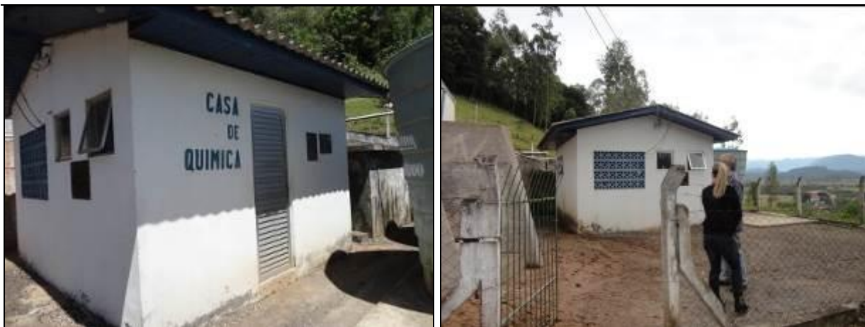
Figura 8: Vista da casa de química da ETA (Inicial e Acompanhamento)
