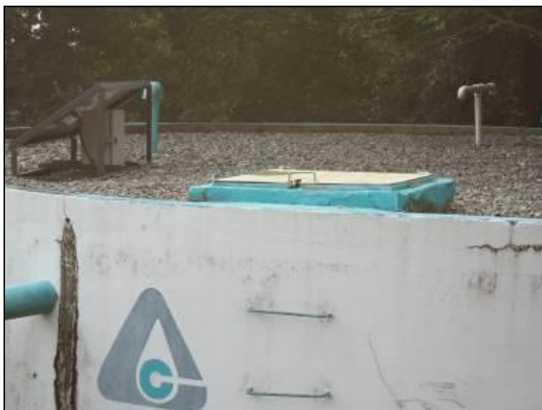
Figura 30: Cobertura do reservatório
