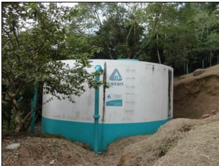
Figura 206: reservatório pulmão de Canto Grande
