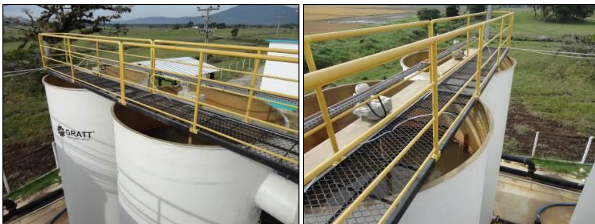
Figura 22: Guarda corpo da ETA de porto Belo
