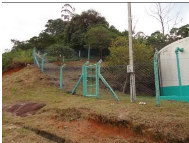
Figura 222: Entorno do Reservatório
