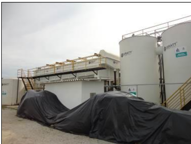
Figura 181: Escada de acesso a ETA de Porto Belo
