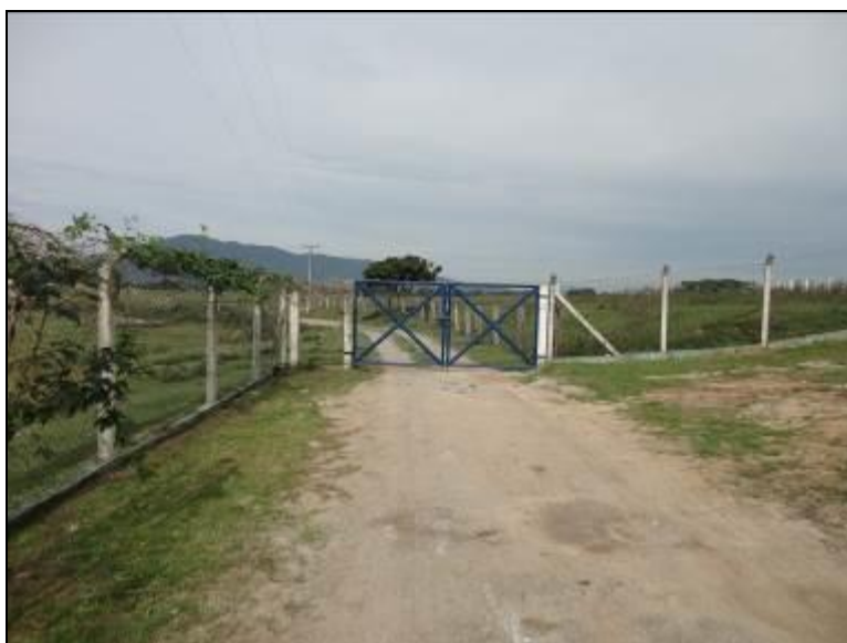
Figura 19: Acesso a ETA de Porto Belo
