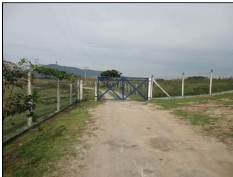
Figura 8: Acesso a ETA de Porto Belo
