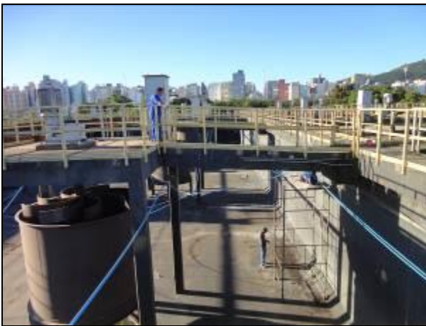
Figura 4: Reforço estrutural com cabos de aço (azul) (30/05/2014)
