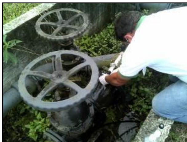
Figura 2: Coleta de água na captação (03/04/2014)
