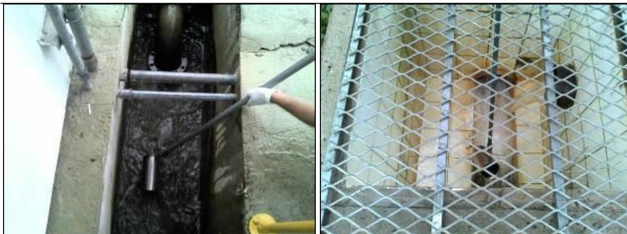
**Figura 23: Coleta do efluente bruto (à esquerda) e do efluente final (à direita) da ETE Caça e Tiro (01/04/2014)**
