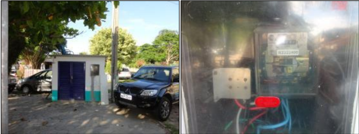
Figura 3: Estação Elevatória de Esgoto BA Barra da Lagoa (24/01/2014)
