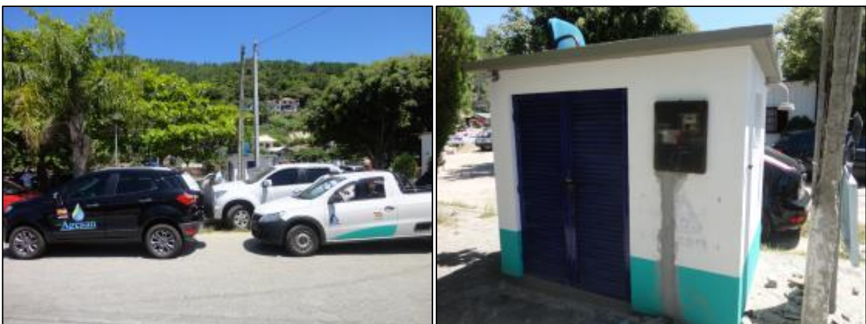
Figura 4: Vista geral da Estação Elevatória de Esgoto BA Barra da Lagoa (Vila dos pescadores) (28/01/2014)
