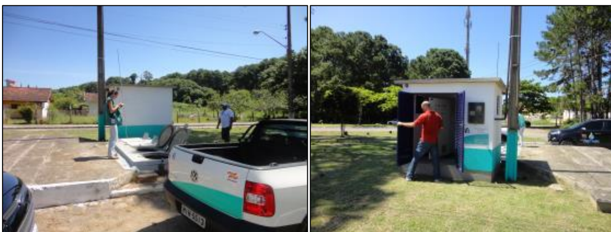
Figura 6: Vista geral da Estação Elevatória de Esgoto ERA Barra da Lagoa (Bombeiros) (28/01/2014)
