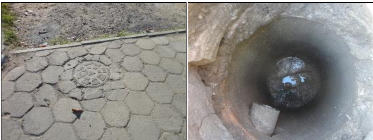
Figura 2: Vista externa e interna da caixa coletora (24/01/2014)
