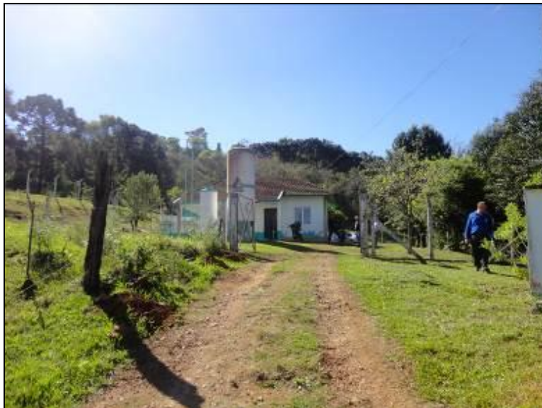
Figura 13: Vista geral da ETA
