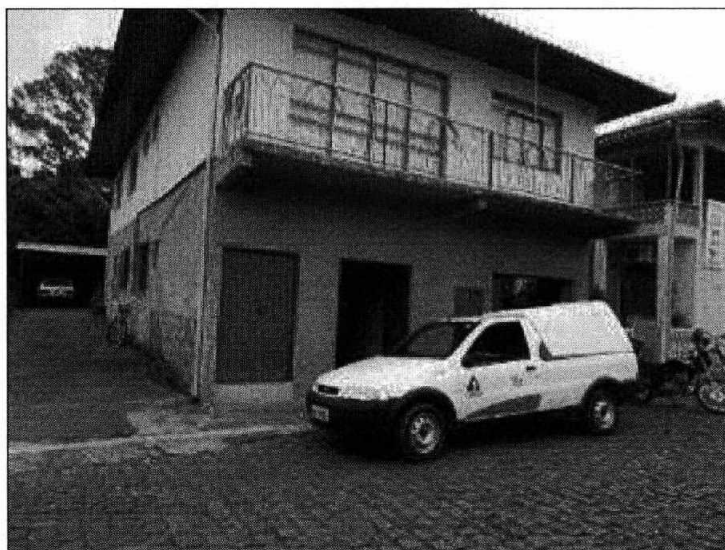
Figura 1: Fachada Escritório (inicial)
