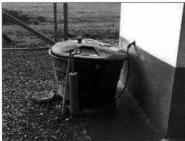
Figura 15: Tratamento Químico (acompanhamento)
