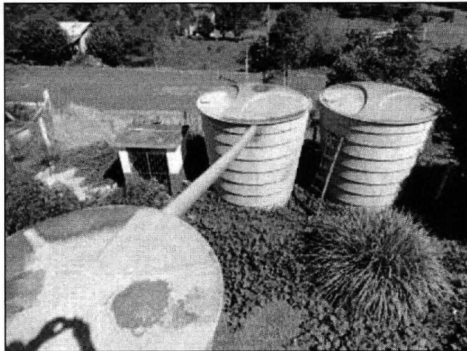
Figura 18: Entorno do reservatório
