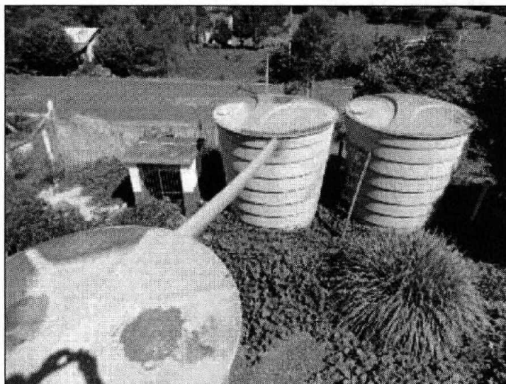
Figura 21: Cobertura dos Reservatórios
