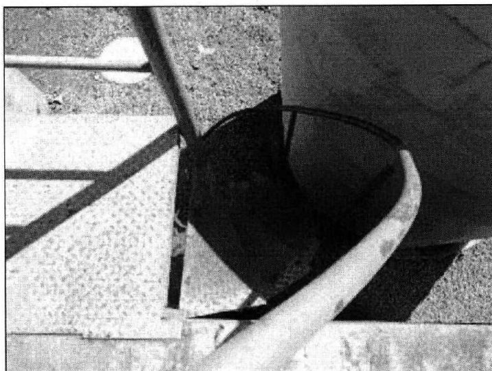
Figura 11: Escada de Acesso ETA
