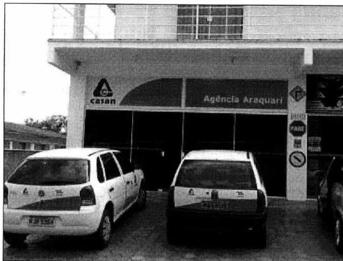
Fachada do Escritório.
