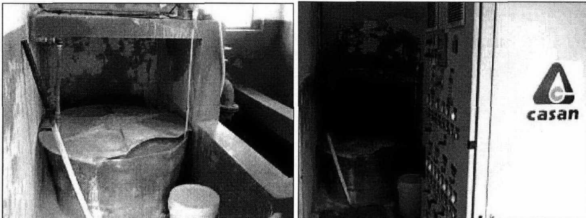
Casa de Química da ETA.
