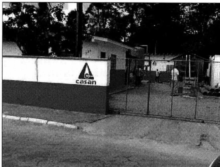
Área da ETA cercada, e identificada.
