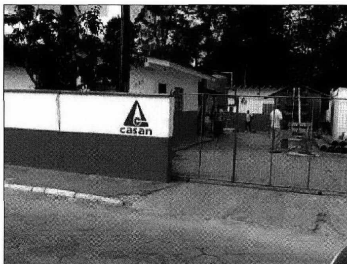
Fachada da ETA
