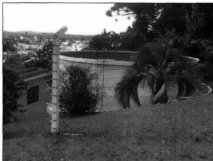
Cerca de Proteção da ETA
