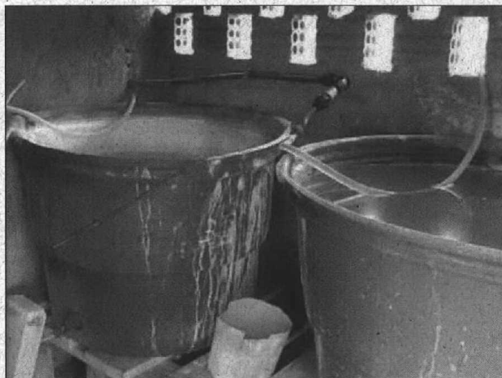
Casa de Química da ETA.
