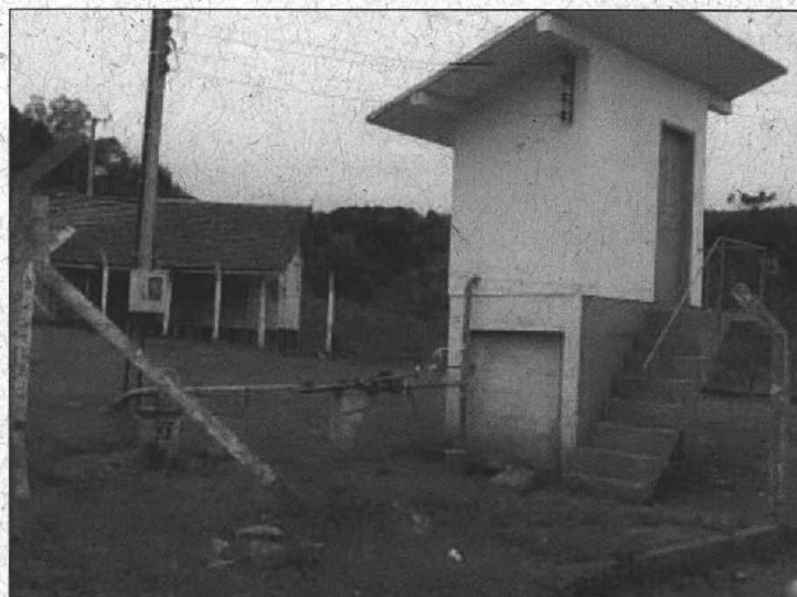
Área do manancial onde é feita a captação.
