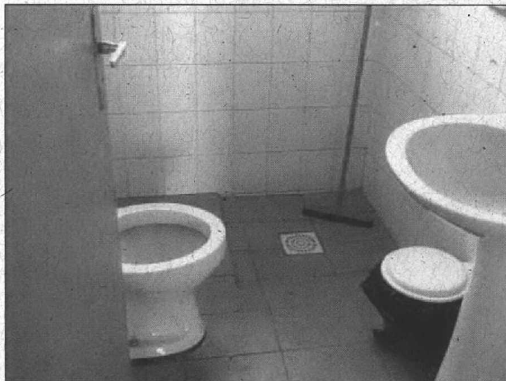
Sanitário do Escritório.
