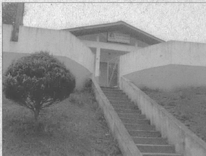
Fachada do Escritório.
