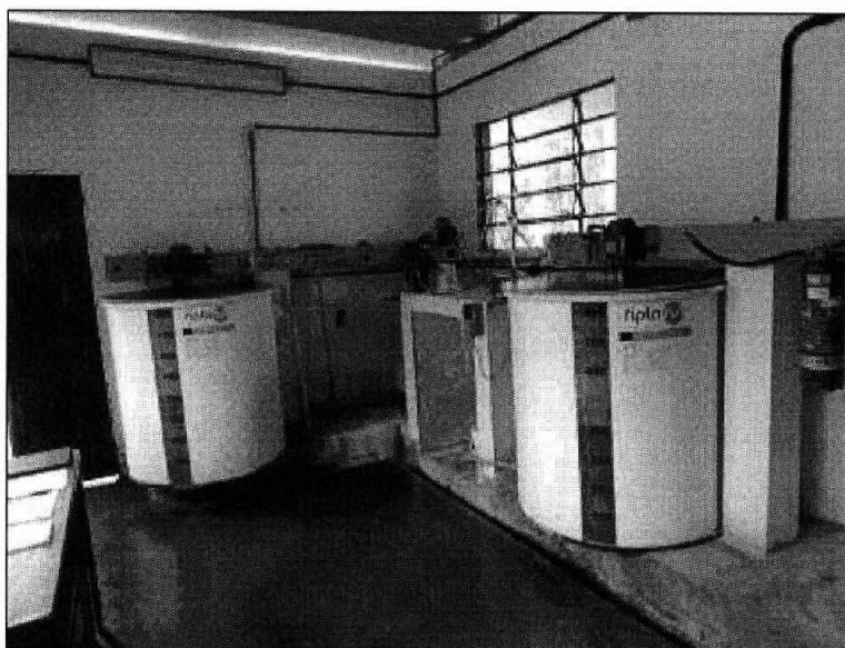
Casa de Química da ETA.
