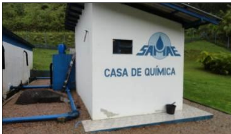
Casa de Química da ETA.
