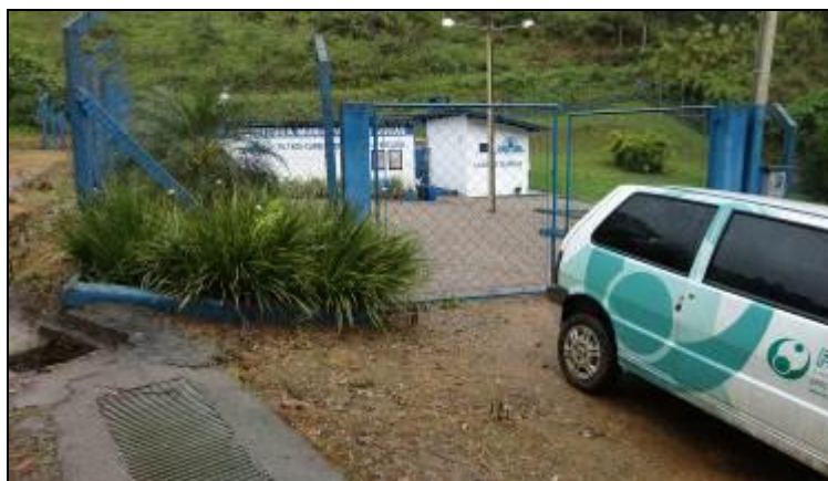
Cerca de Proteção da ETA
