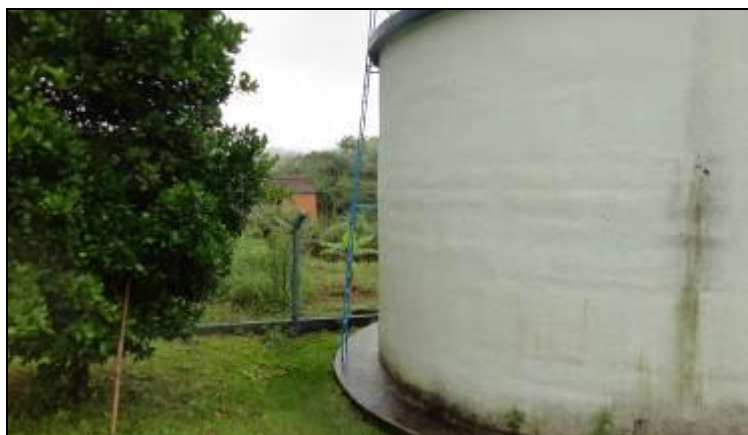
Escada de Acesso
