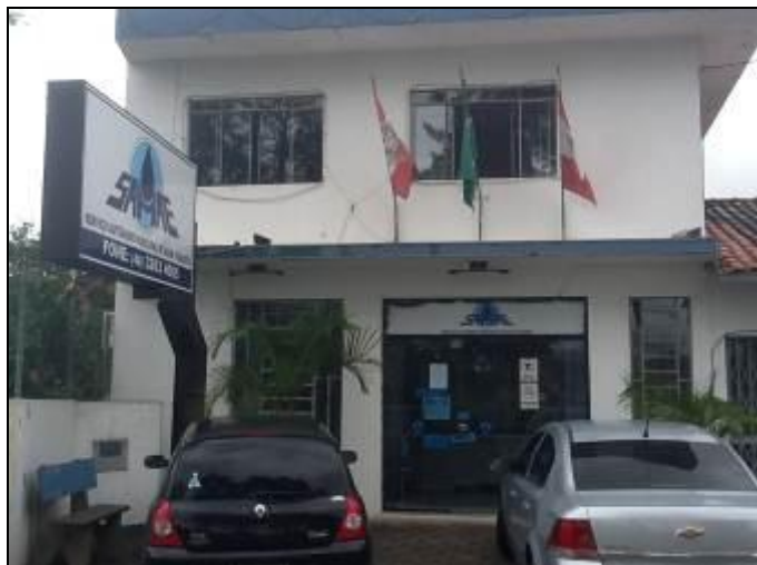
Fachada do Escritório.
