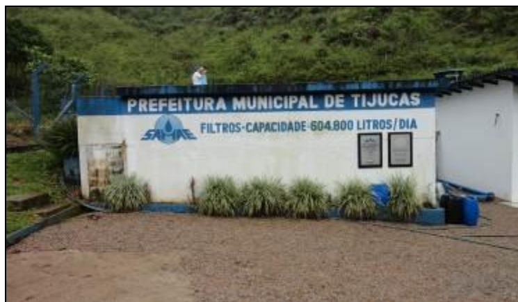
Fachada da ETA
