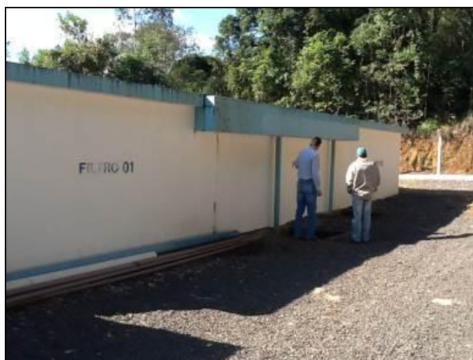
Vista da área de tratamento físico da ETA.
