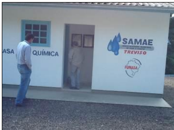
Casa de Química da ETA de Treviso.
