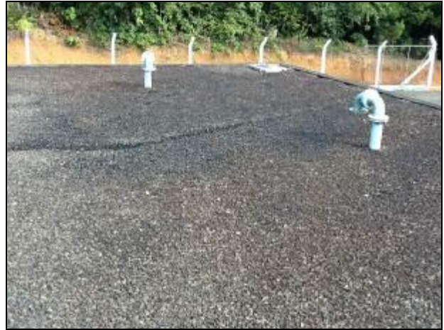
Coberturas dos filtros e do Reservatório
