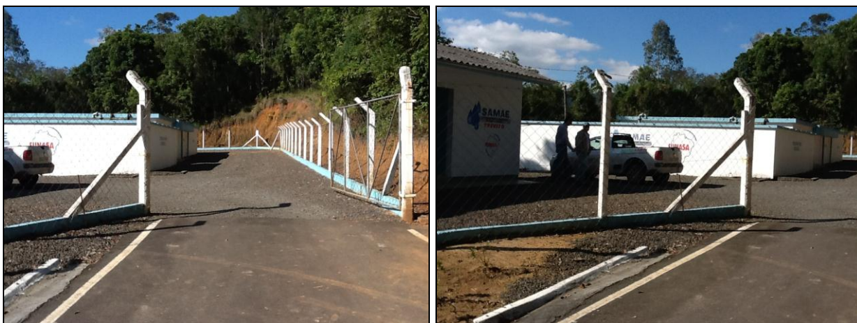
Acessos da ETA Treviso.
