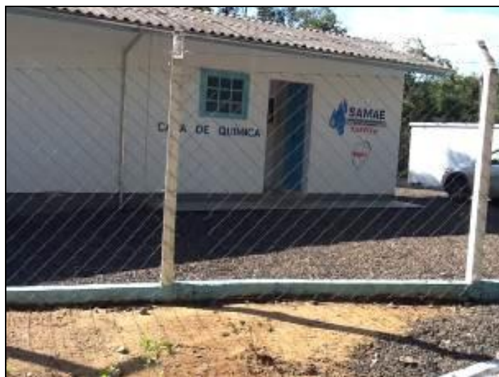
Fachada da ETA - Coordenadas UTM: 0651681 / 6845335
