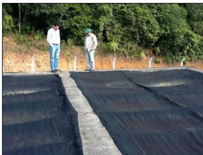
Estruturas de filtragem devidamente cobertas.
