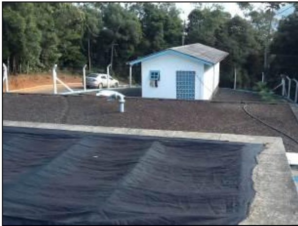
Coberturas dos filtros e do Reservatório
