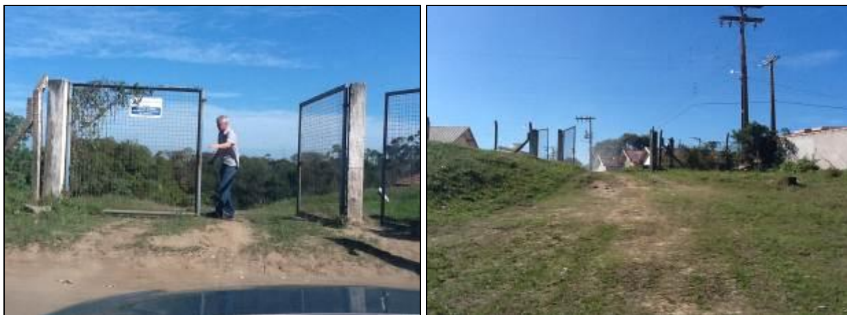
Acesso principal da ETA.
