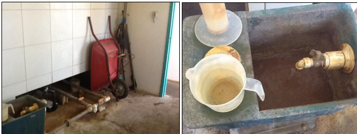
Casa de Química da ETA do Canal do Gi Laguna
