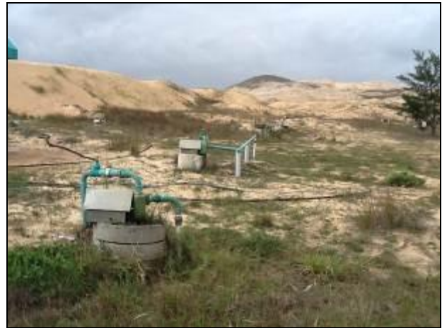
Sistema isolado Farol de Santa Marta: ponteiras
