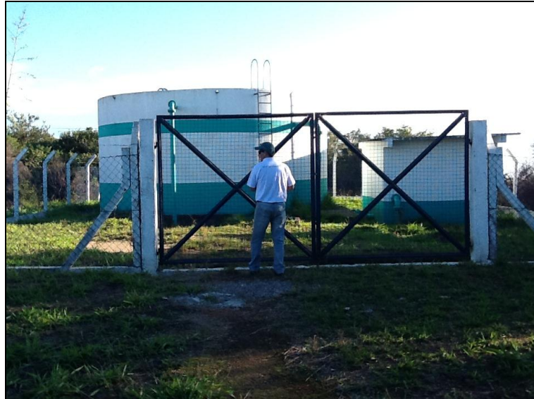
Reservatório Cabeçadas (R-05) – Coordenadas UTM: 0714341/6851826
