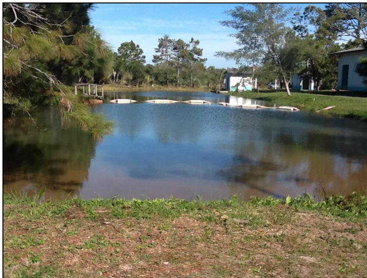
Visão geral das lagoas de decantação da Área do manancial.
