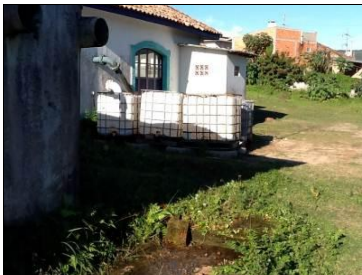
Alguns produtos químicos dispostos na ETA.
