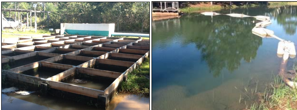
Sistema de tratamento físico da ETA do Canal do Gi
