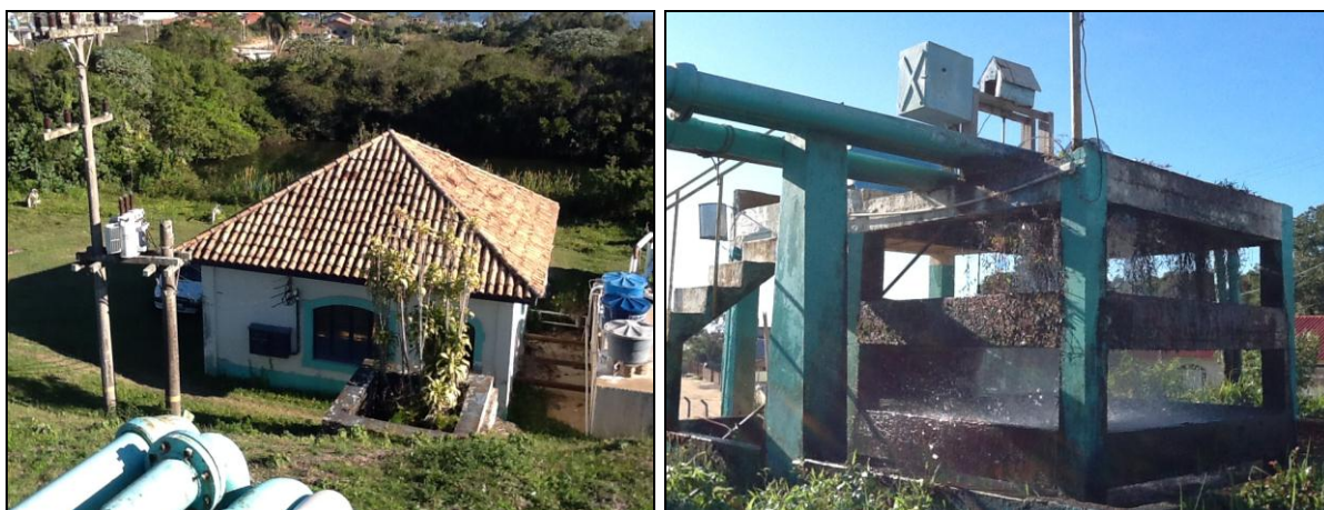
Vista geral da ETA do Machado – Laguna - Coordenadas UTM: 0716699 / 6849052
