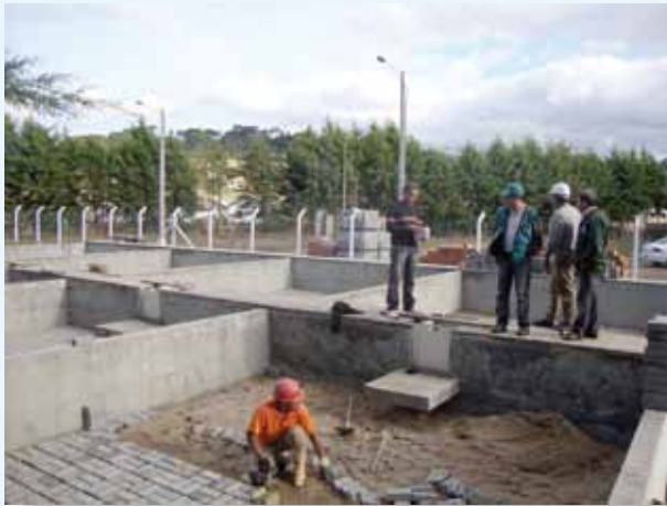
Construção da ETE em Bom Jardim da Serra
