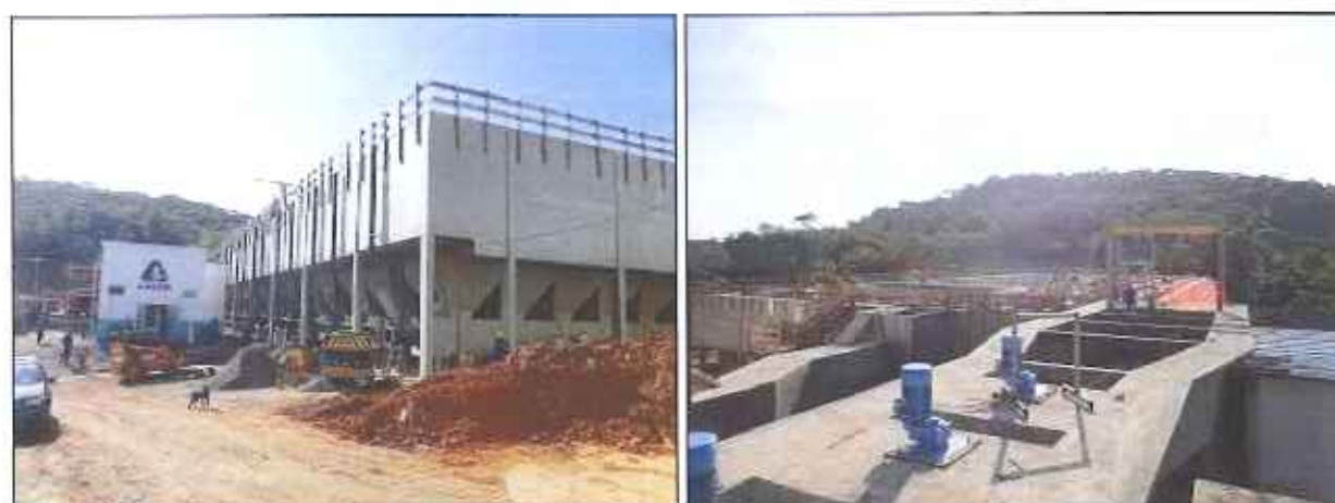
Figura 4: Situação das obras de ampliação da ETA no momento da vistoria do Plano de Emergência, em dezembro de 2015
