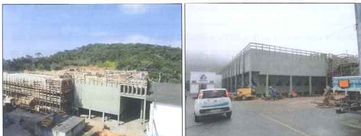
Figura 3: Situação das obras de ampliação da ETA nos meses de Outubro (à esquerda) e Dezembro (à direita) de 2015
