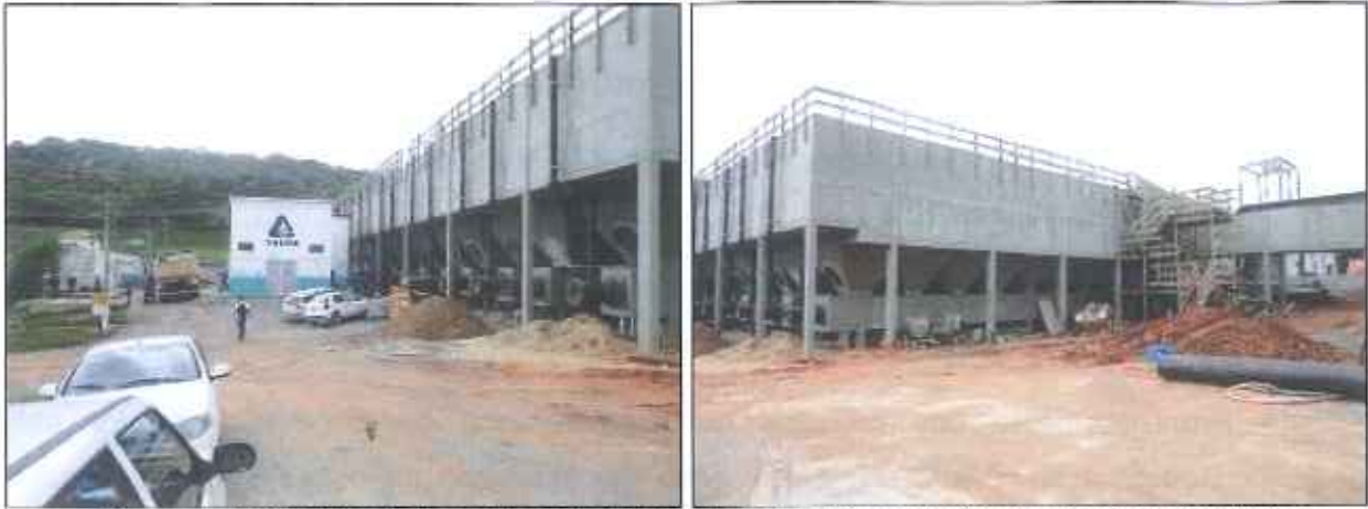
Figura 5: Estrutura do flocodecantador na fase de pré-operação, em janeiro de 2016
