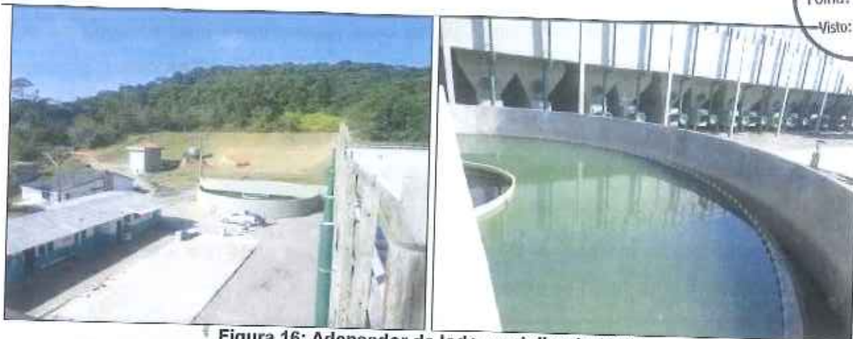
Figura 16: Adensador de lodo, em julho de 2016
