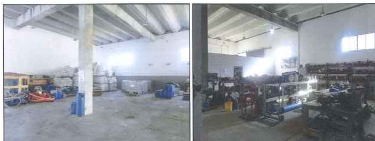
Figura 15: Armazenamento dos produtos químicos (à esquerda) e oficina de manutenção de bombas (à direita), em julho de 2016
