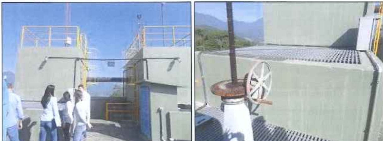
Figura 8: Chegada de água bruta com melhorias nas grades de proteção, guarda-corpos e iluminação, em julho de 2016
