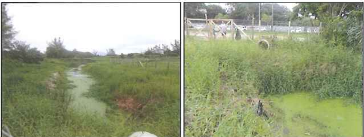
Figura 3: Canal de drenagem paralelo à praia do Campeche (à direita) e local onde a canalização deveria levar o fluxo de água para o Riozinho, mas encontra-se obstruída (à esquerda)
