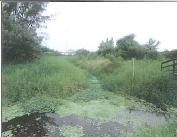
Figura 4: Local onde o canal de drenagem paralelo à praia foi desviado para a praia do Campeche, na tentativa de minimizar os problemas de alagamento
