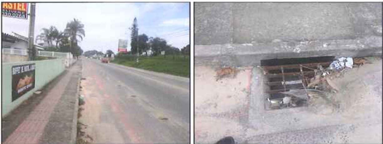
Figura 2: Início da Av. Pequeno Príncipe e situação da drenagem pluvial existente
