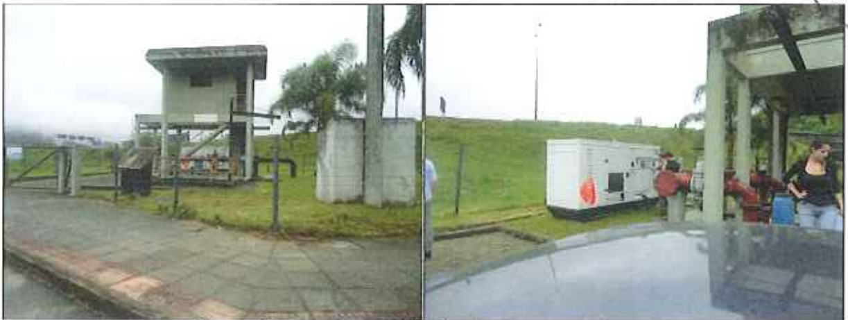
Figura 16: Geradores EEE Túnel – Saco dos Limões
