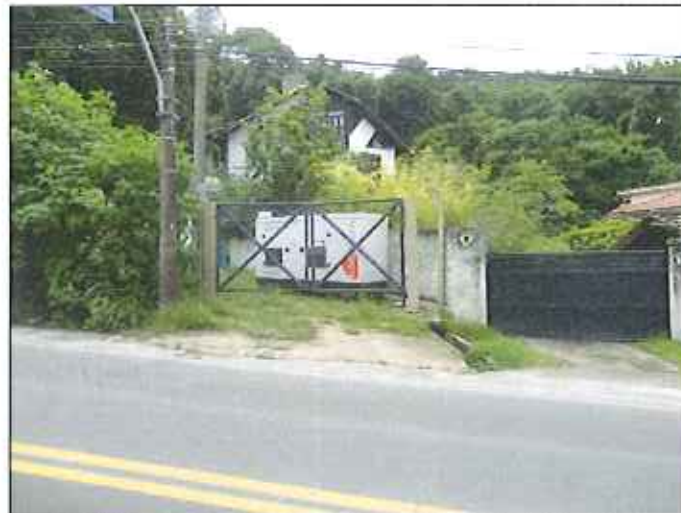
Figura 55: Gerador no Booster Barra da Lagoa
