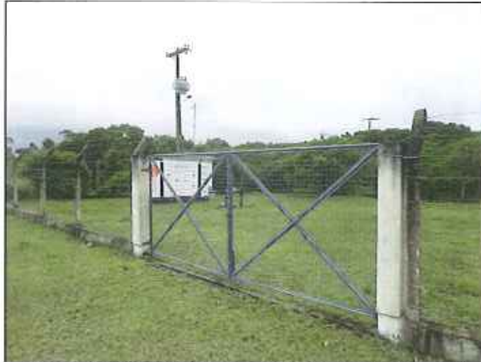
Figura 41: Gerador no Poço Paulinho da Matriz II
