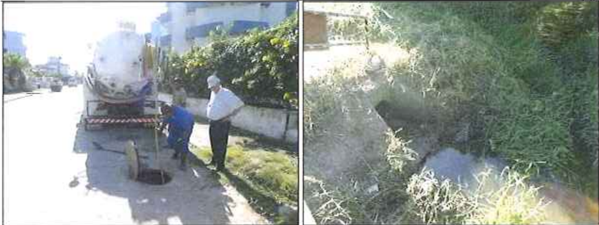
Figura 5: Caminhão lançando água com corante no extravasor existente dentro do poço de visita para comprovar a ligação com a rede de drenagem pluvial
