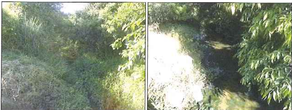
Figura 4: Montante e jusante do curso d'água existente que deságua a rede pluvial da prefeitura
