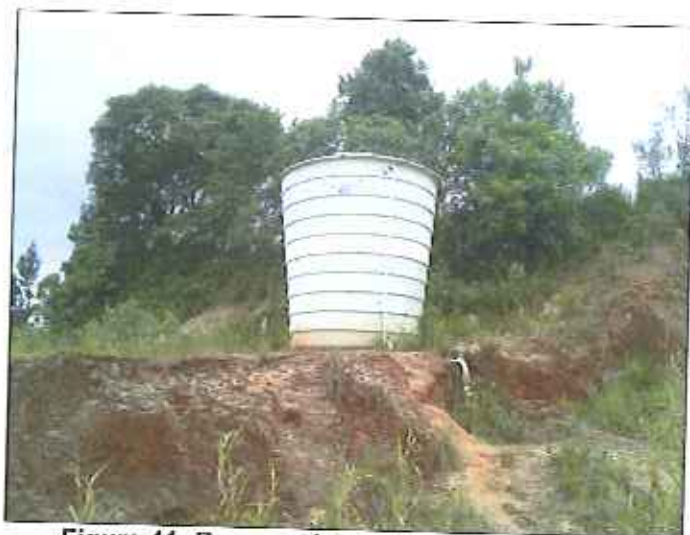
Figura 41: Reservatório Mutirão da Boa Vista
