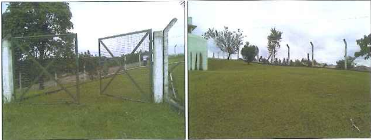
Figura 22: Portão de acesso e cercas da ETA
