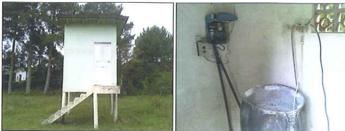
Figura 26: Casa de química Poço Lageado Comunidade
