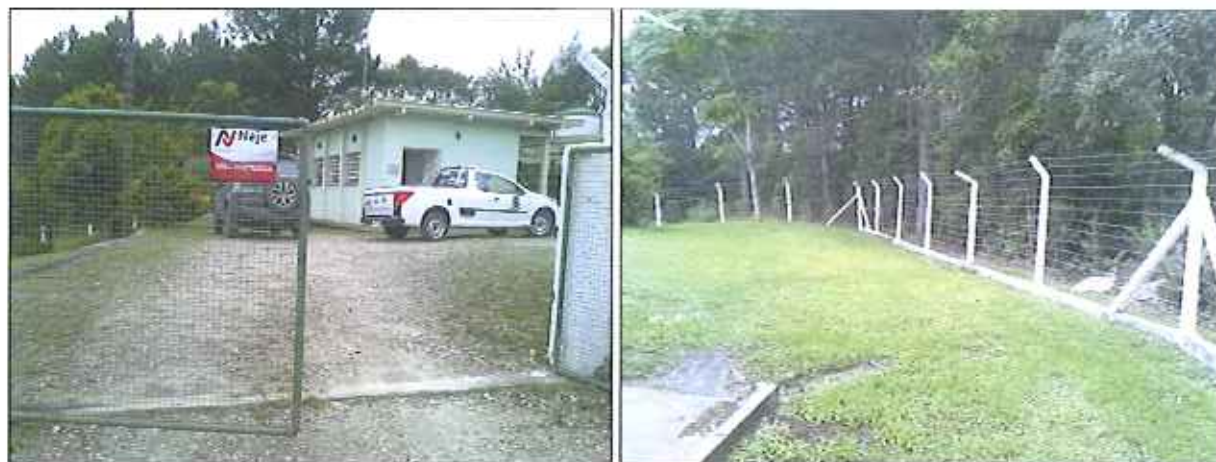
Figura 16: Entorno da ETA
