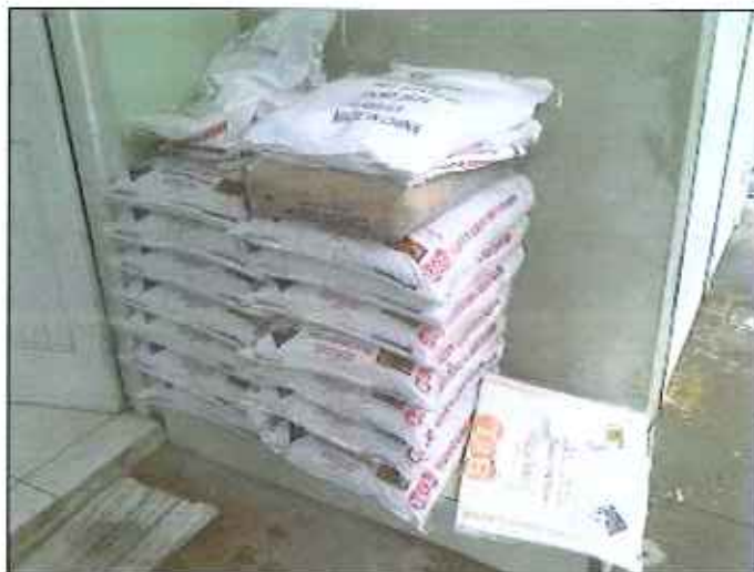
Figura 19: Almojarifado da ETA
