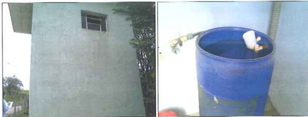
Figura 25: Casa de química Poço São Miguel
