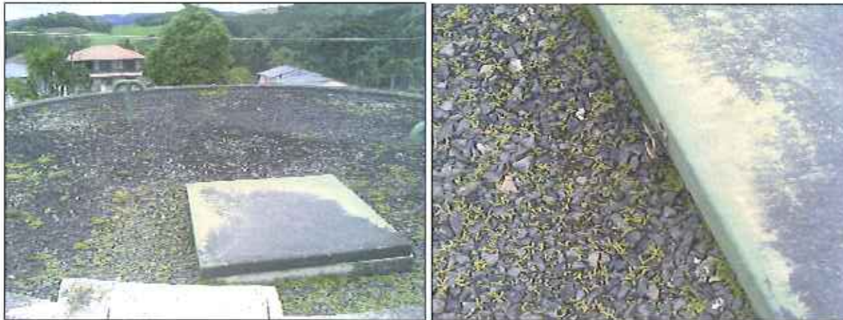
Figura 38: Cobertura do reservatório
