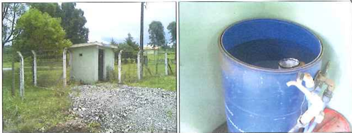
Figura 20: Casa de química Poço Avenquinha II
