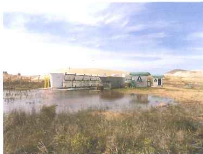
Imagem 4 e Foto 3 - Captação e Casa de Química do Farol de Santa Marta
