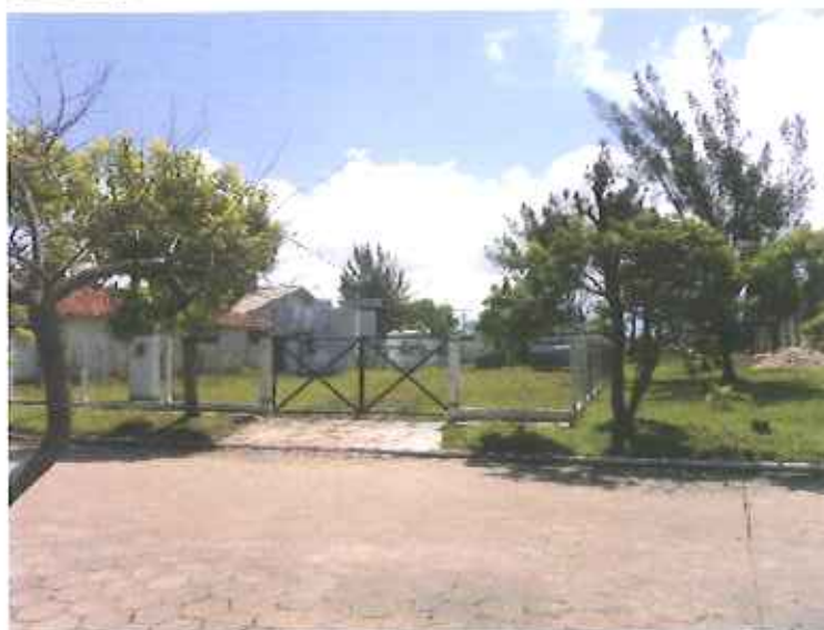
Imagem 6 e Foto 4 - ETA da Praia do Sol
