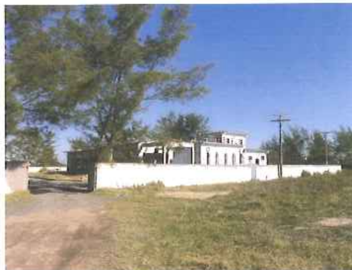
Imagem 2 e Foto 1 – Estação de Tratamento de Água do Gi
