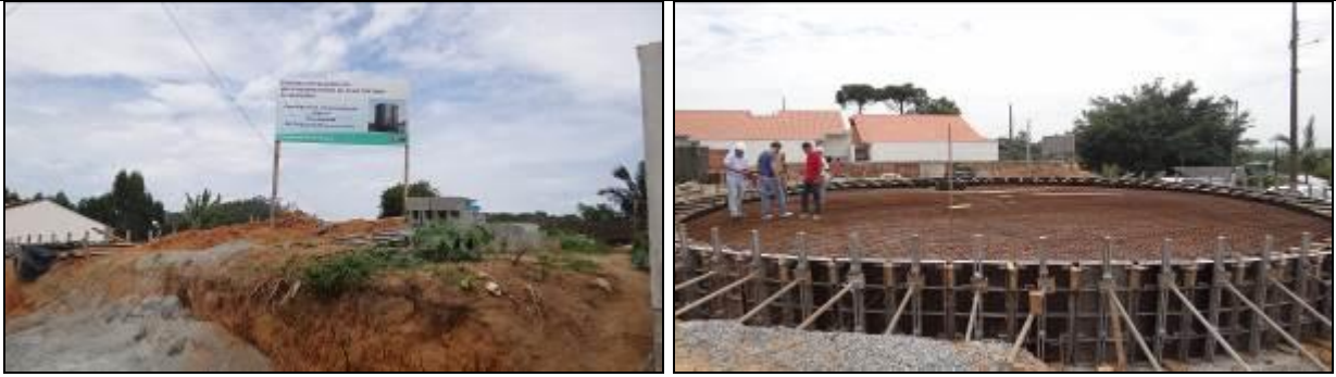
Figura 4: Reservatório 2.000 m 3 (Fiscalização de dezembro de 2014)
