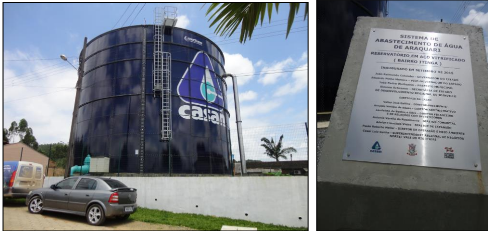
Figura 5: Reservatório 2.000 m 3 (Fiscalização de dezembro de 2015)
