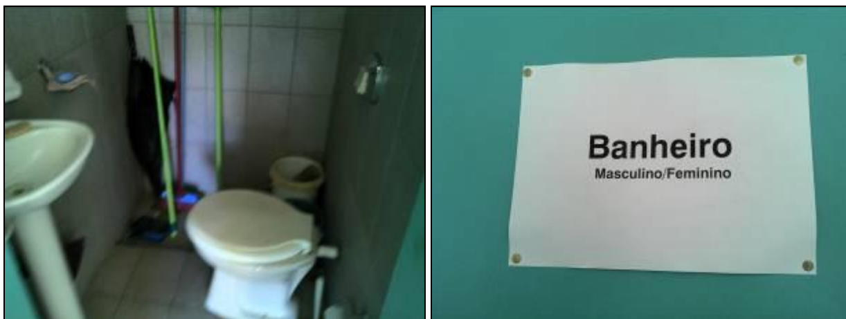
Figura 5: Sanitário da Agência
