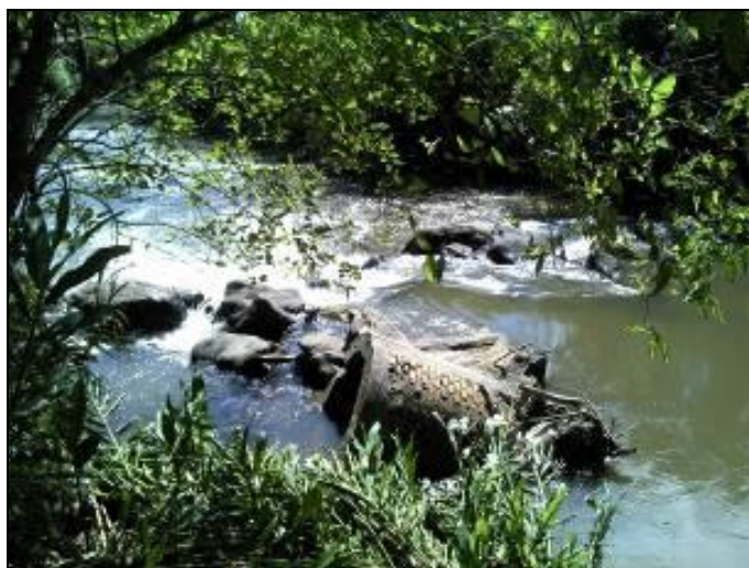
Figura 11: Problema ocorrido devido as fortes chuvas
