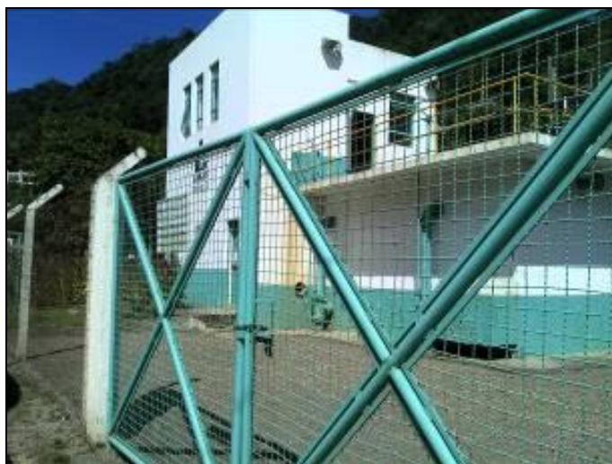
Figura 16: ETA devidamente cercada
