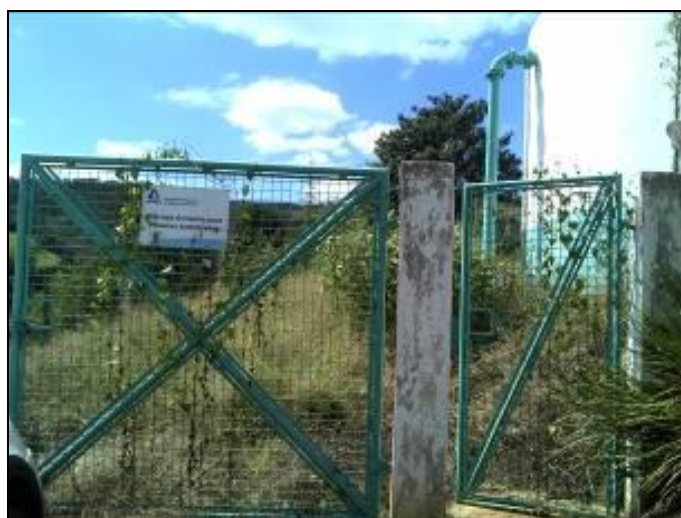
Figura 28: Placa de restrição de acesso
