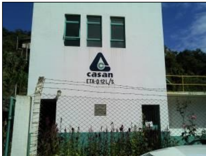
Figura 13: Vista da ETA
