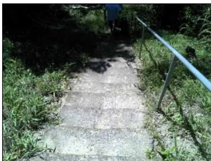
Figura 10: Acesso a captação
