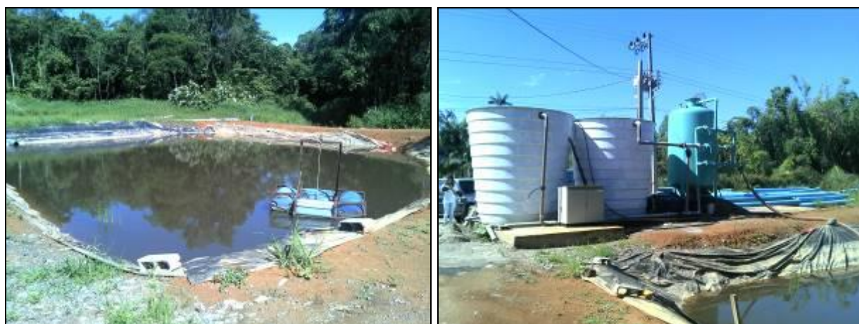
Figura 1: ETA Rua das Carpas
