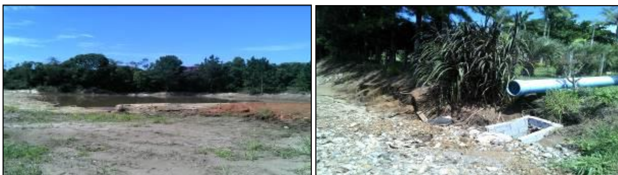
Figura 10: Local onde será instalada a ETA Compacta de Araquari
