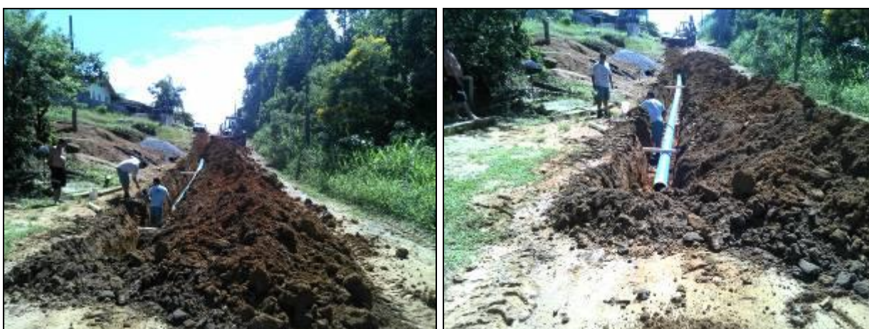
Figura 9: Obras das adutoras de entrada e saída de água do Reservatório
