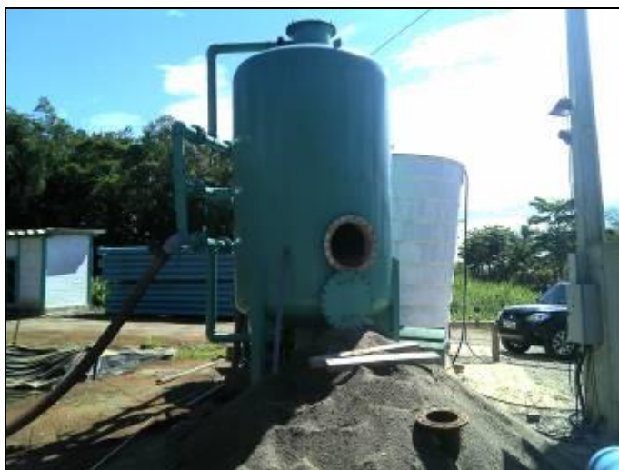
Figura 2: Material filtrante sendo retirado do filtro
