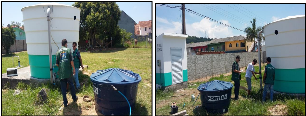
Figura 31: Casa de Química Vargem Grande II (11/02/2015)
