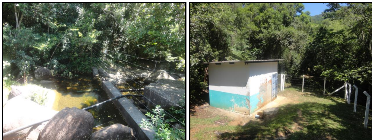
Figura 8: Represa de captação de água bruta do Rio Pau do Barco (à esquerda) e Casa de química (à direita) (10/02/2015)
