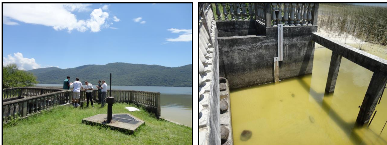
Figura 33: Captação de água (12/02/2015)
