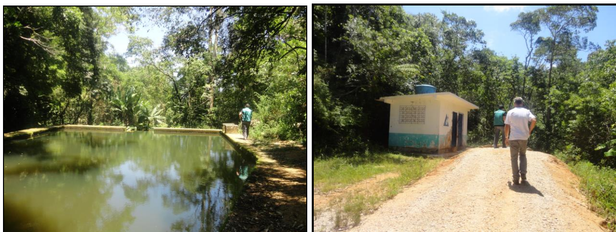
Figura 7: Represa de captação de água bruta do Rio Tavares (à esquerda) e Casa de química (à direita) (10/02/2015)
