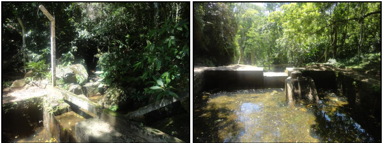
Figura 4: Represa de captação de água bruta do Córrego Ana D'Ávila (10/02/2015)
