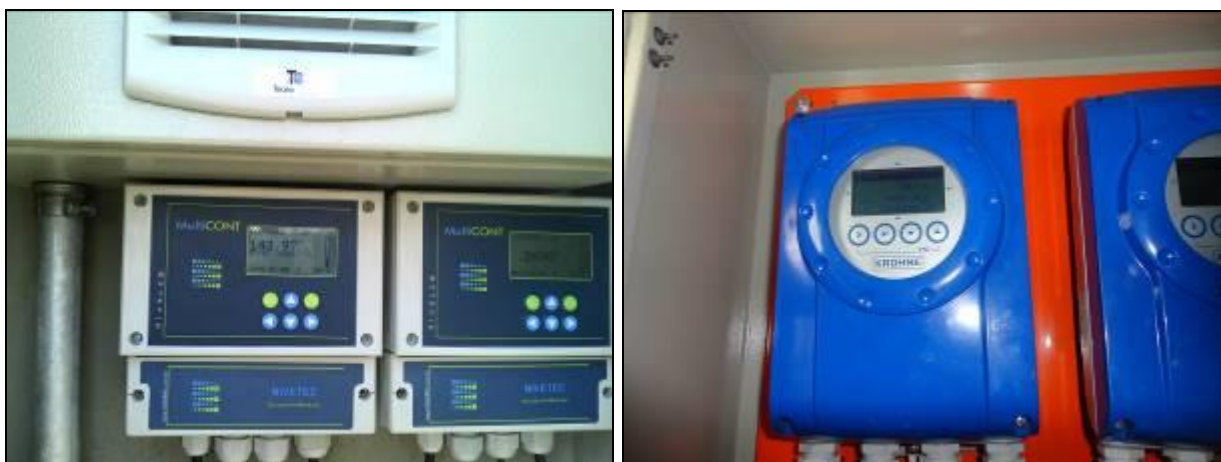
Figura 2: Macro medidor da Barragem e da ETA de Porto Belo
