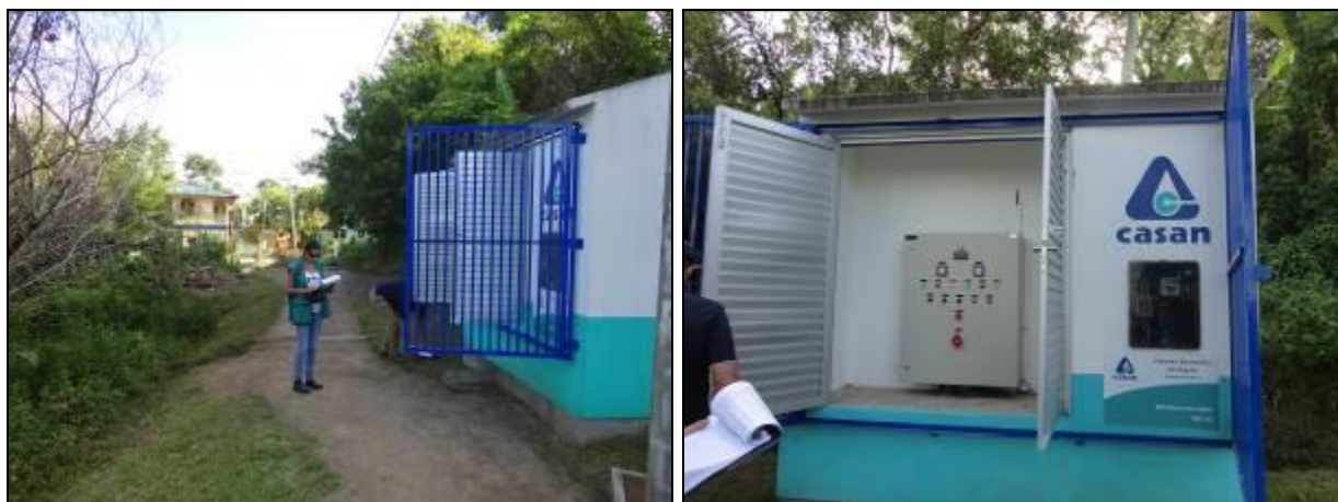
Figura 115: Vista externa e interna da casa de comando (Acompanhamento fev2014)
