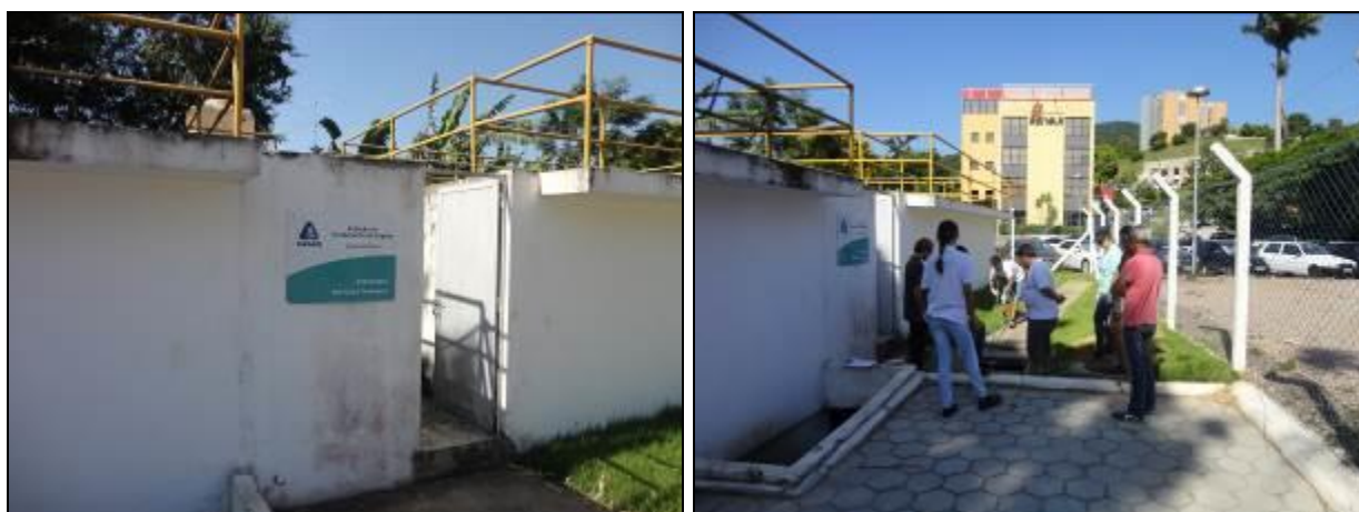
Figura 34: Área da ETE com placa indicativa (à esquerda) e coleta de esgoto bruto (à direita) (Acompanhamento fev2014)
