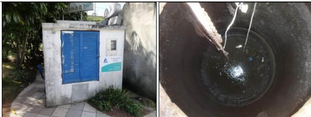
Figura 205: Casa de comando (à esquerda) e poço úmido (à direita) (Acompanhamento fev2014)
