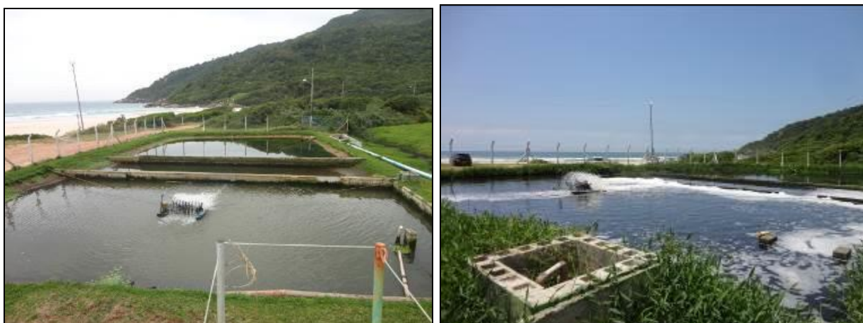
Figura 59: Lagoas de estabilização (Acompanhamento set2013 à esquerda e fev2014 à direita)
