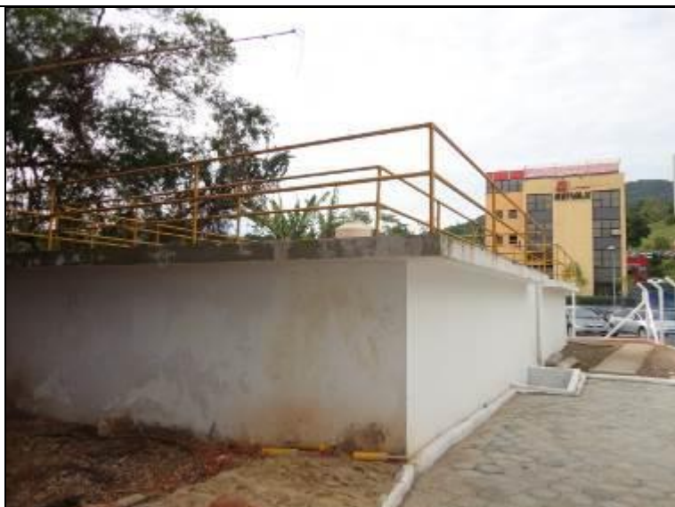
Figura 33: Vista geral da ETE (Acompanhamento set2013)
