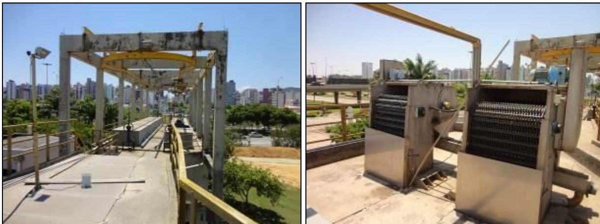
Figura 8: Estruturas da área de recepção de esgoto bruto (Acompanhamento fev21014)
