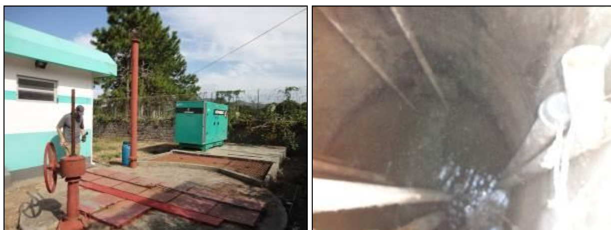
Figura 125: Vista externa e interna do poço úmido (Acompanhamento fev2014)
