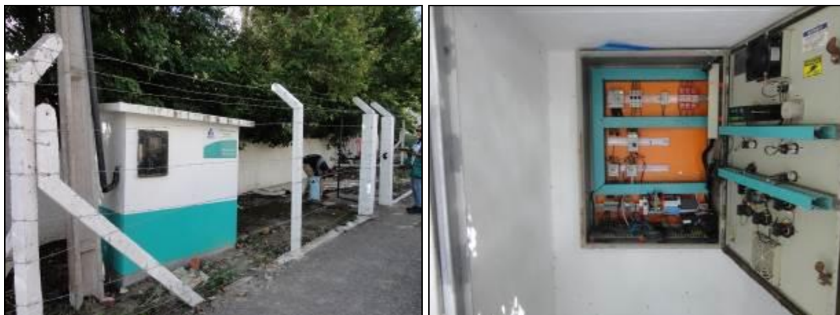
Figura 296: Vista externa e interna da casa de comando (Acompanhamento fev2014)
