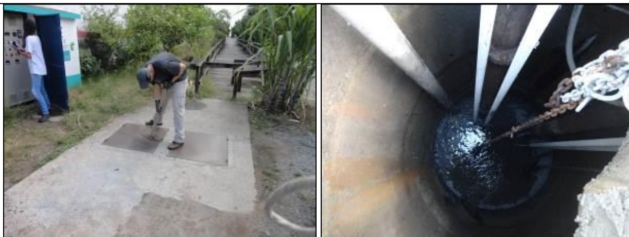
Figura 249: Vista externa e interna do poço úmido (Acompanhamento fev2014)
