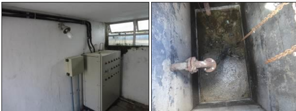
Figura 286: Casa de comando (à esquerda) e poço úmido (à direita) (Acompanhamento fev2014)
