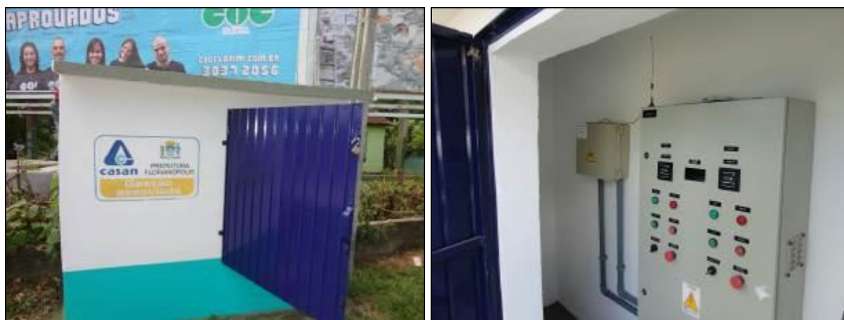
Figura 240: Vista externa e interna da casa de comando (Acompanhamento fev2014)
