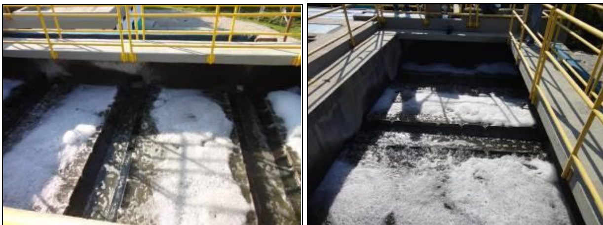
Figura 25: Filtros com bastante espuma de detergente (Acompanhamento set2013 à esquerda e fev2014 à direita)
