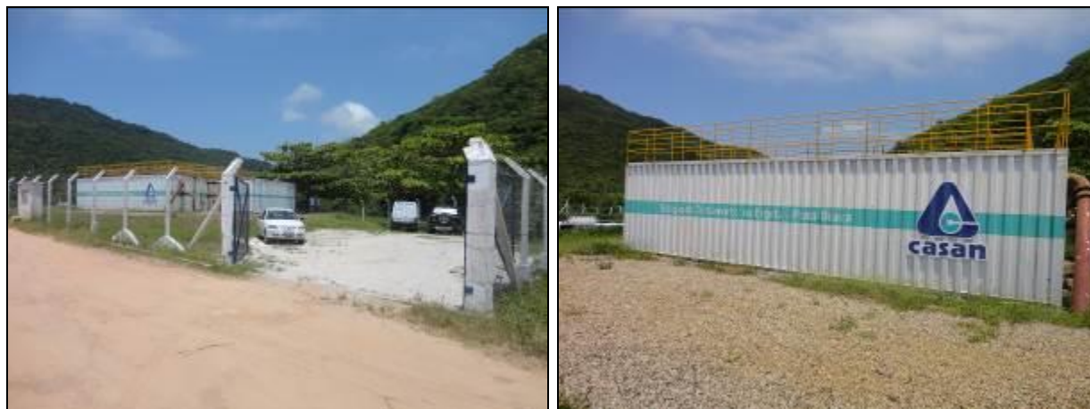
Figura 57: Fachada da ETE Praia Brava (Acompanhamento fev2014)
