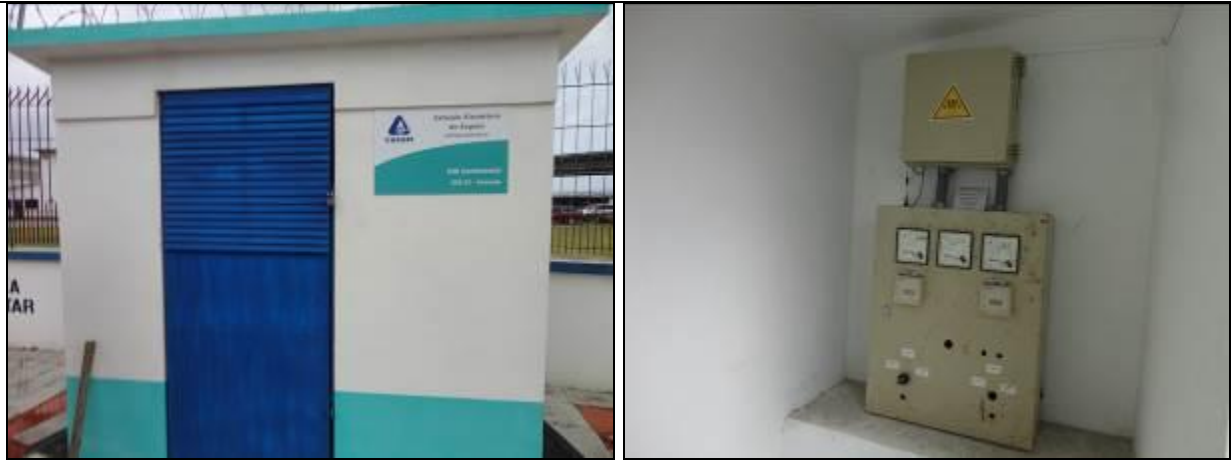
Figura 167: Vista externa e interna da casa de comando (Acompanhamento fev2014)
