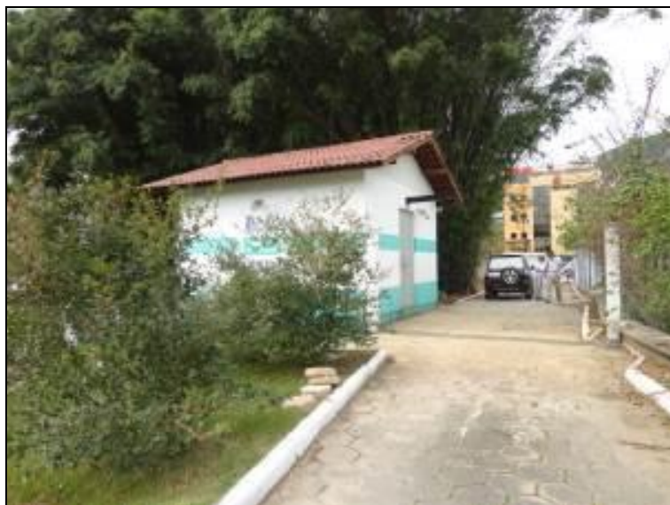
Figura 32: Área de acesso à ETE (Acompanhamento set2013)
