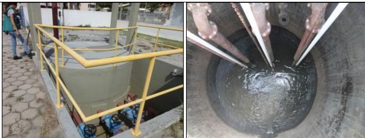
Figura 137: Vista externa e interna do poço úmido (Acompanhamento fev2014)
