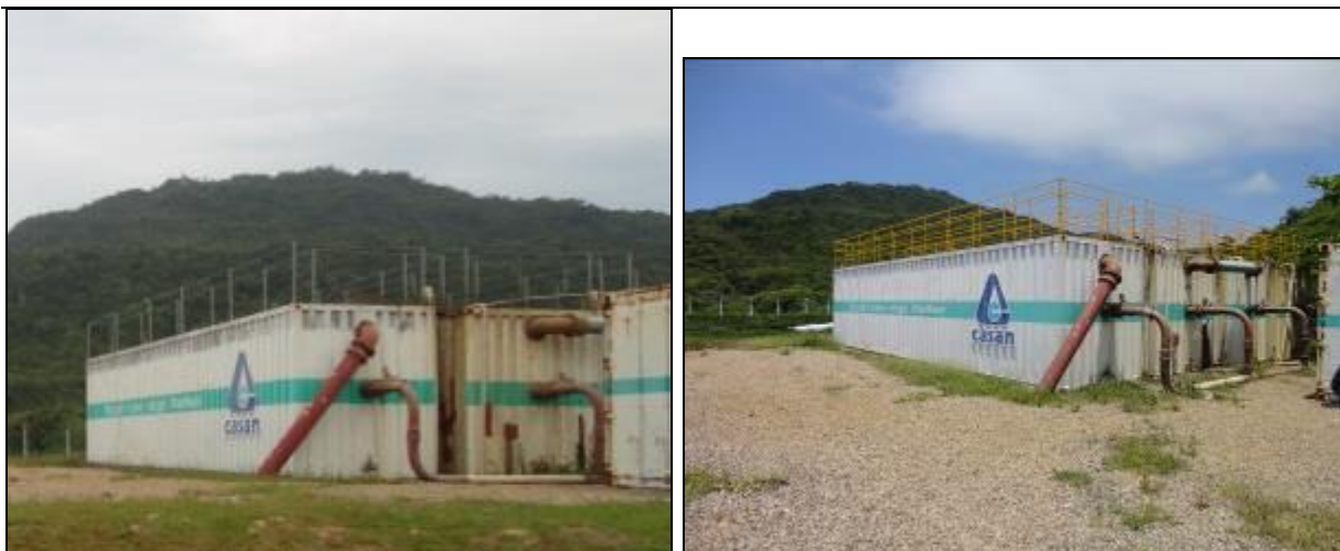
Figura 58: Visão das tubulações de chegada (Acompanhamento set2013 à esquerda e fev2014 à direita)
