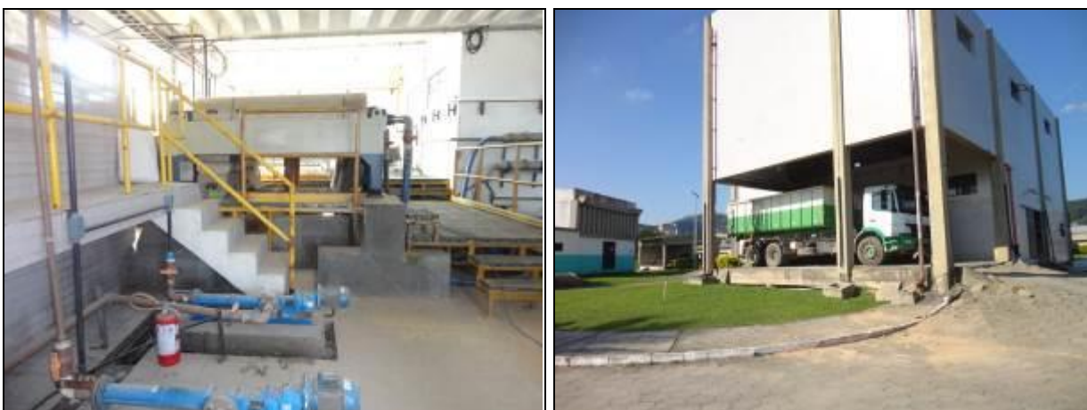
Figura 9: Interior da área de desidratação do lodo (à esquerda) e caminhão sendo carregado com o sólido final (à direita) (Acompanhamento set2013)
