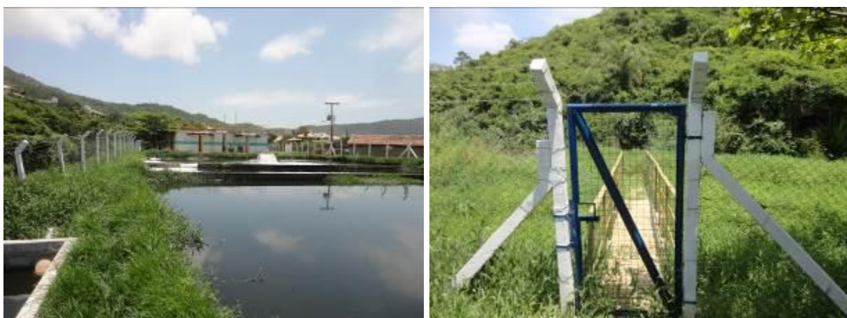
Figura 56: Área dos fundos cercada com portão de acesso à área de lançamento do efluente final (Acompanhamento fev2014)
