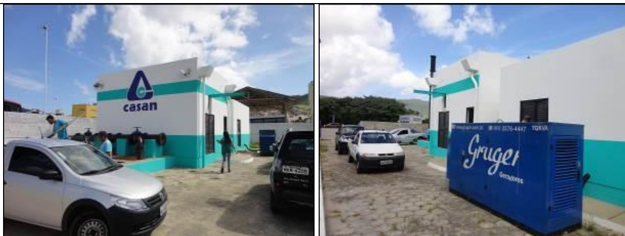
Figura 218: Vista geral da EEE (Acompanhamento fev2014)
