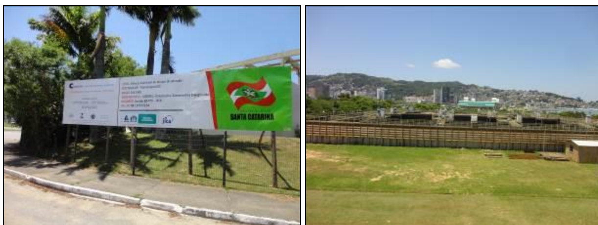
Figura 15: Obras de reforço estrutura do tanque de aeração de uma das unidades de lodos ativados (Acompanhamento fev2014)
