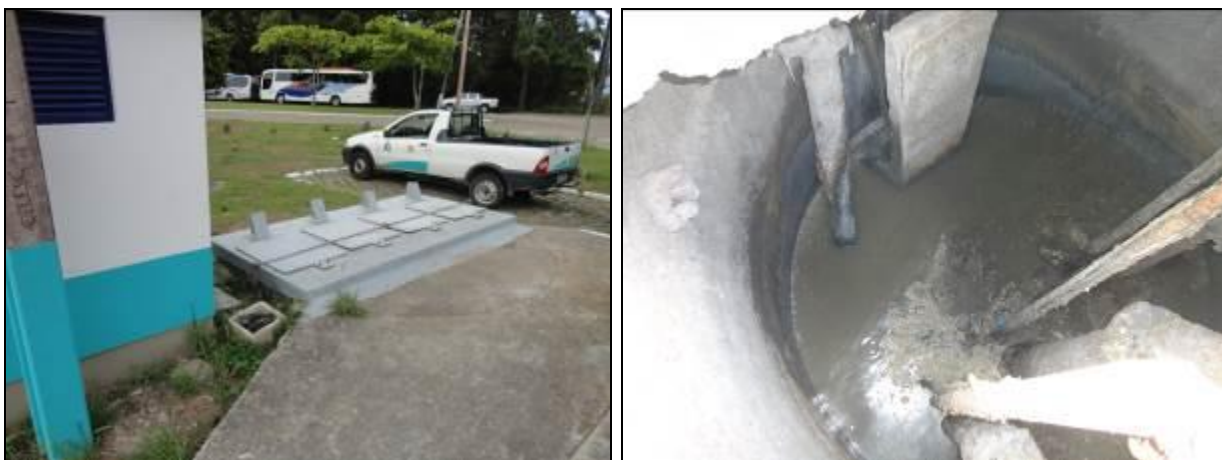
Figura 102: Vista externa e interna do poço úmido (Acompanhamento fev2014)
