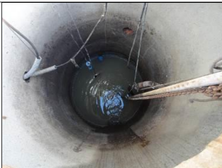
Figura 222: Vista interna do poço úmido (Acompanhamento fev2014)
