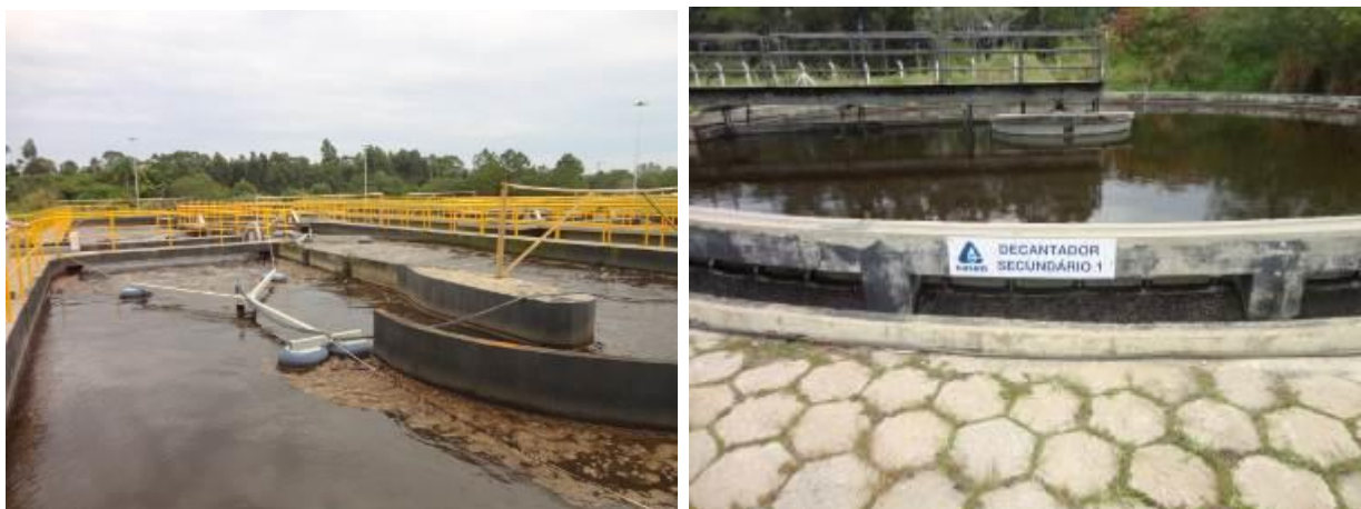
Figura 43: Lodo ativado (à esquerda) e decantador (à direita) (Acompanhamento set2013)
