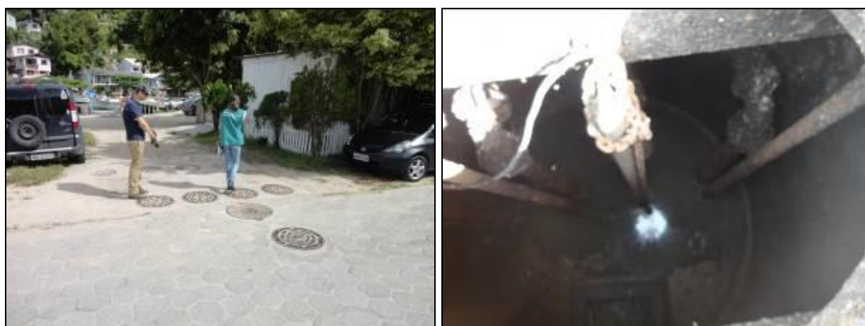
Figura 107: Vista externa e interna do poço úmido (Acompanhamento fev2014)
