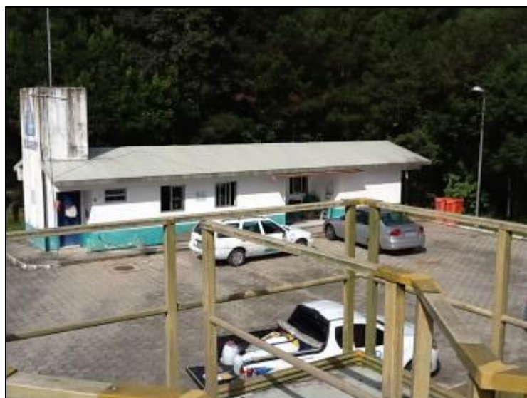
Figura 84: Área de apoio: escritório e depósitos (Inicial)
