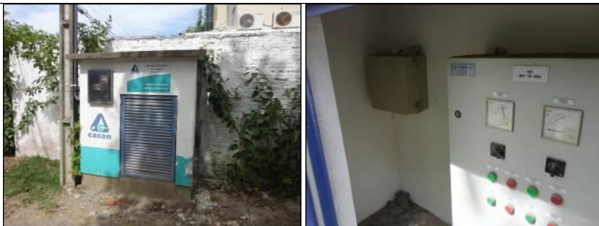
Figura 98: Vista externa e interna da casa de comando (Acompanhamento fev2014)
