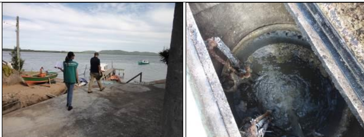
Figura 114: Vista externa e interna do poço úmido (Acompanhamento fev2014)
