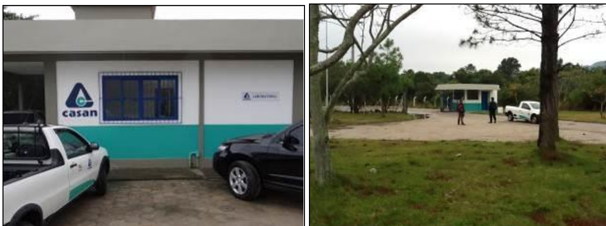
Figura 47: Área do laboratório (à esquerda) e guarita (à direita) (Inicial)
