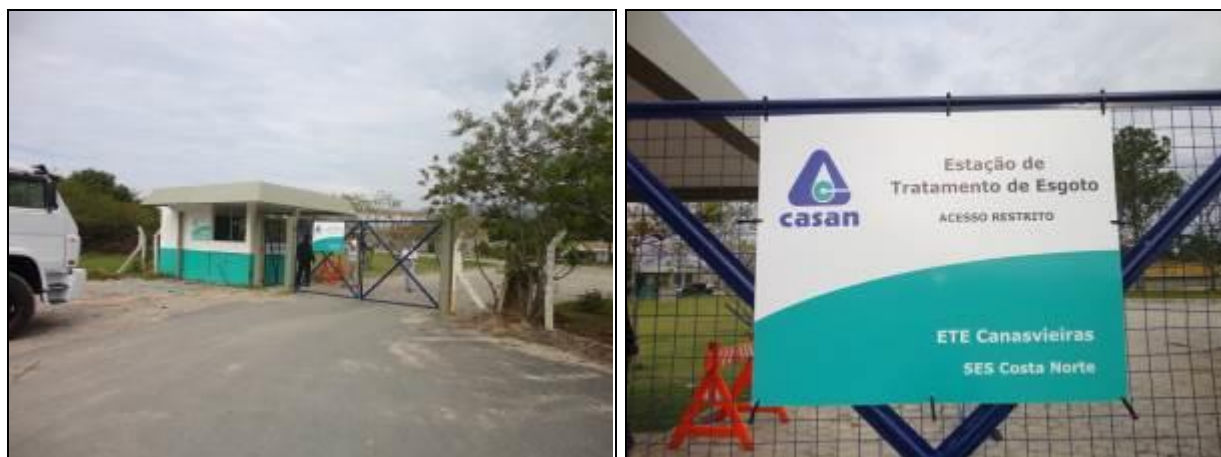
Figura 41: Área de acesso à ETE (Acompanhamento set2013)
