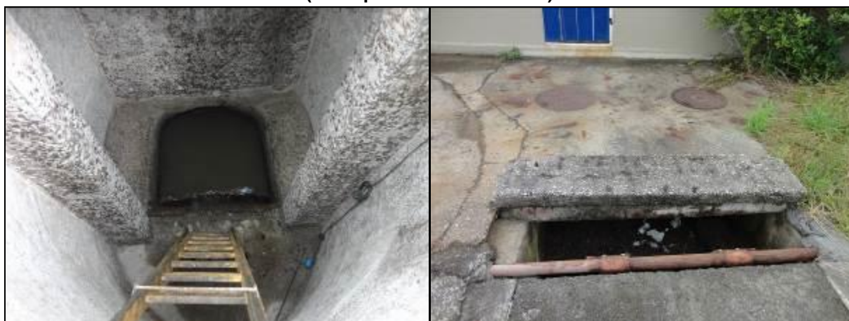
Figura 181: Gradeamento (à esquerda) e extravasor (à direita) (Acompanhamento fev2014)
