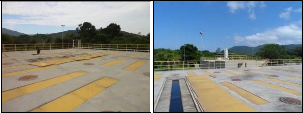
Figura 42: Reatores UASB (Acompanhamento set2013 à esquerda e fev2014 à direita)
