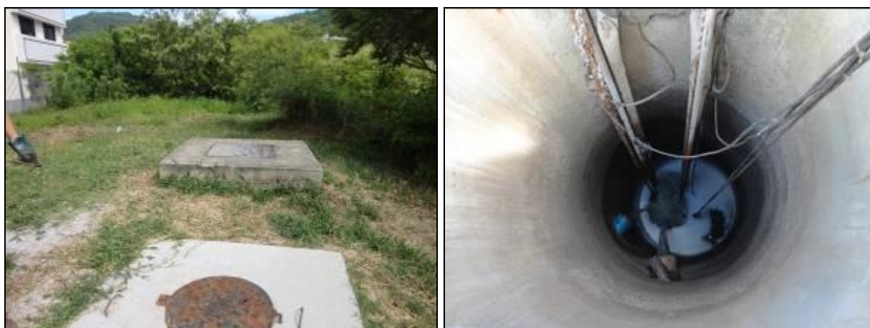
Figura 288: Vista externa e interna do poço úmido (Acompanhamento fev2014)
