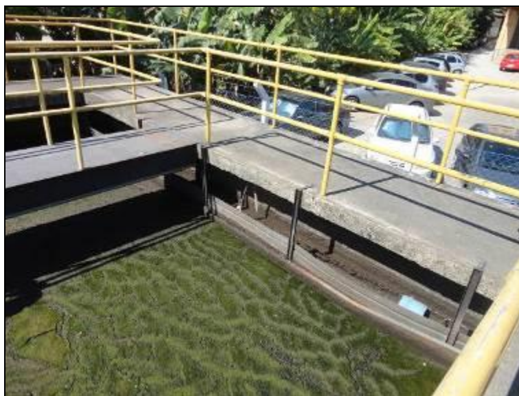
Figura 39: Lodo sobrenadante (Acompanhamento fev2014)
