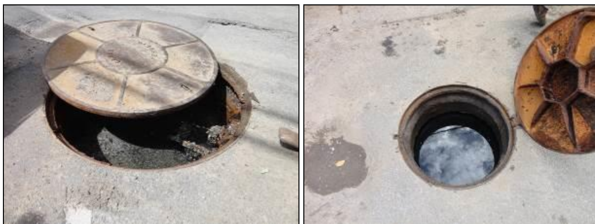
Figura 243: Poços paralisados e entupidos (Acompanhamento fev2014)
