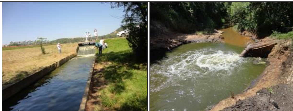
Figura 96: Lançamento do efluente final (Acompanhamento fev2014)
