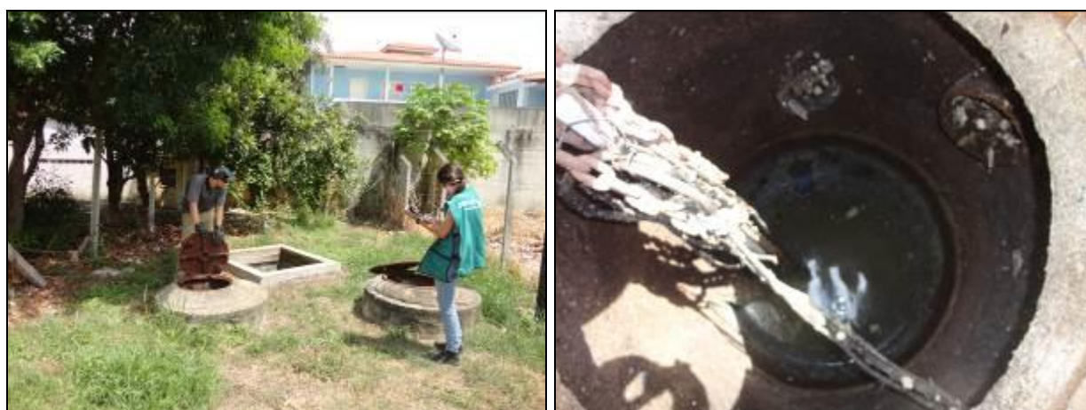
Figura 159: Vista externa e interna do poço úmido (Acompanhamento fev2014)
