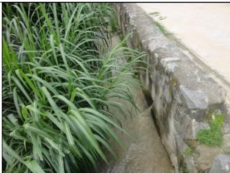
Figura 260: Efluente bruto sendo lançado (Acompanhamento fev2014)
