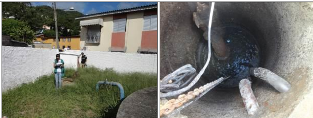
Figura 294: Vista externa e interna do poço úmido (Acompanhamento fev2014)
