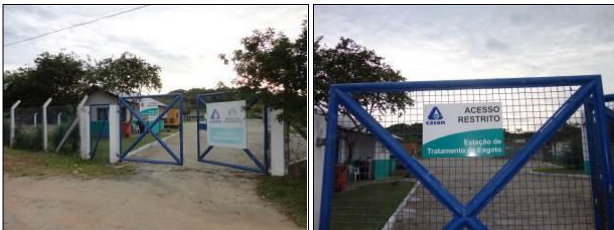
Figura 70: Acesso à ETE (Acompanhamento set2013)
