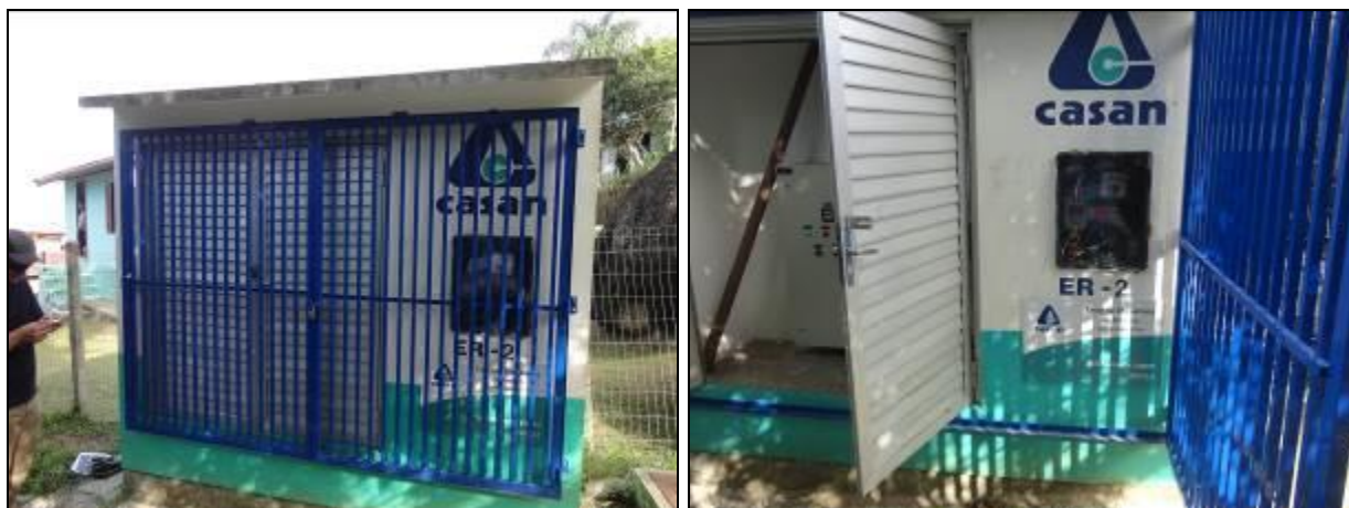
Figura 113: EEE 02 Costa da Lagoa (Acompanhamento fev2014)
