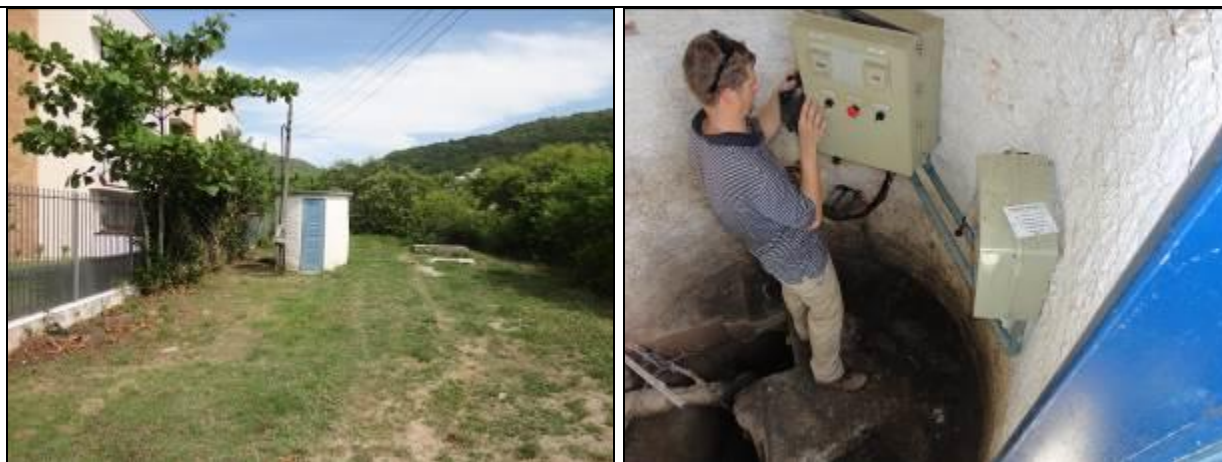
Figura 287: Vista externa e interna da casa de comando (Acompanhamento fev2014)
