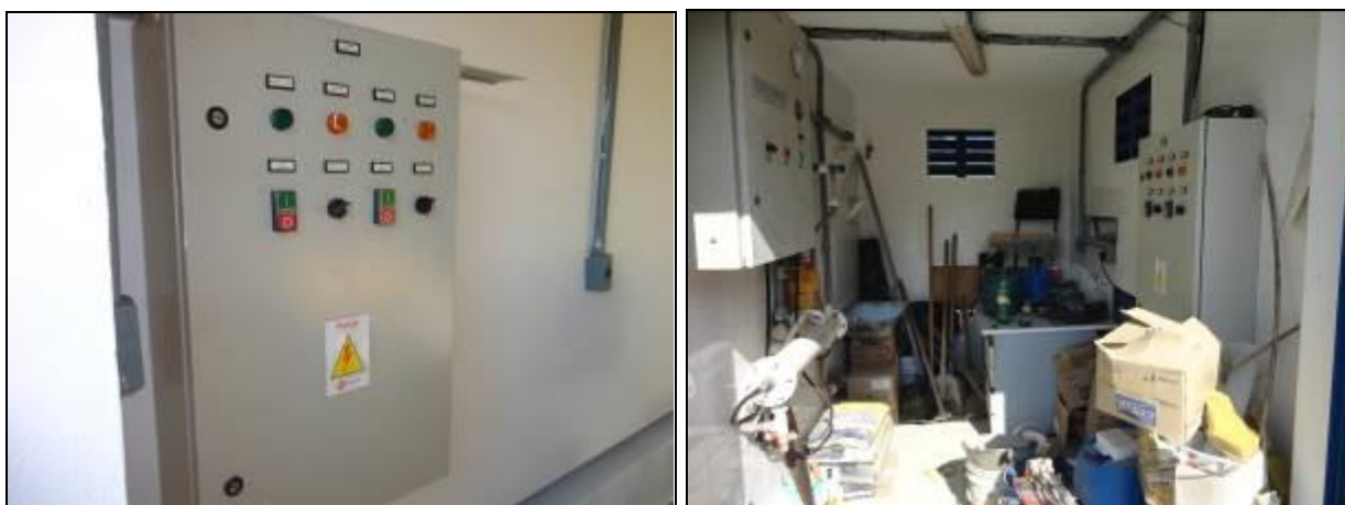
Figura 29: Casa de comando (Acompanhamento set2013 à esquerda e fev2014 à direita – local de entulho)
