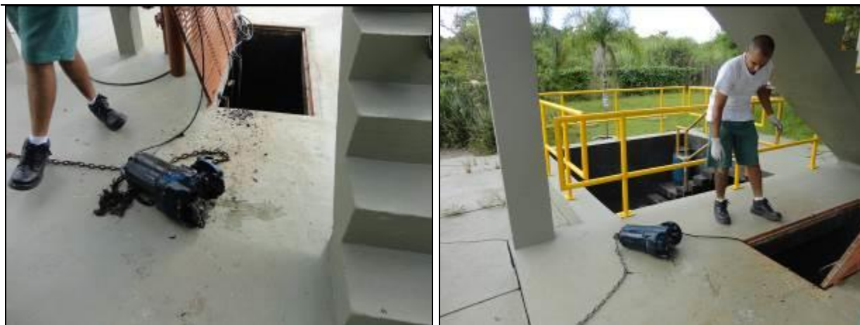
Figura 232: Técnicos da CASAN desentupindo a bomba (Acompanhamento fev2014)
