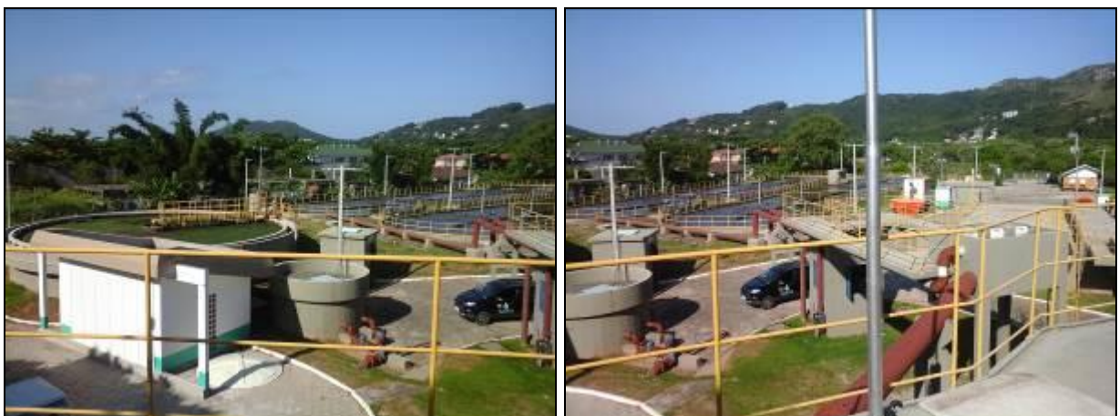
Figura 67: Decantador (à esquerda) e Valos de Oxidação (à direita) (Acompanhamento fev2014)
