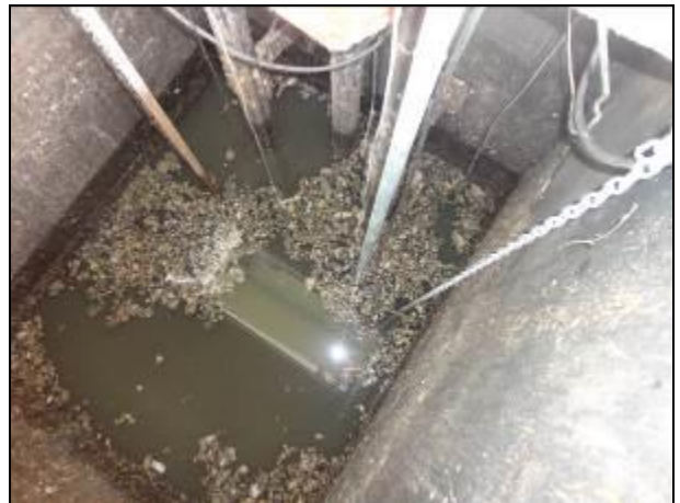
Figura 231: Gradeamento entupido (à esquerda) e poço úmido (à direita) (Acompanhamento fev2014)
