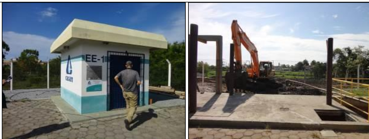
Figura 130: Vista da EEE em obras (Acompanhamento fev2014)
