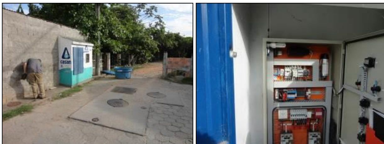
Figura 146: Vista externa e interna da casa de comando (Acompanhamento fev2014)
