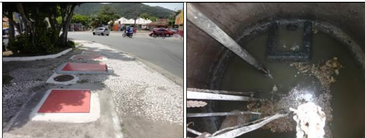
Figura 263: Vista externa e interna do poço úmido (Acompanhamento fev2014)
