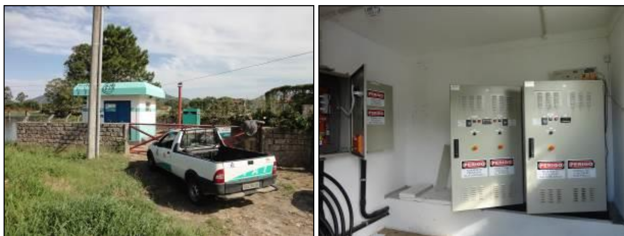
Figura 124: Vista externa e interna da casa de comando (Acompanhamento fev2014)
