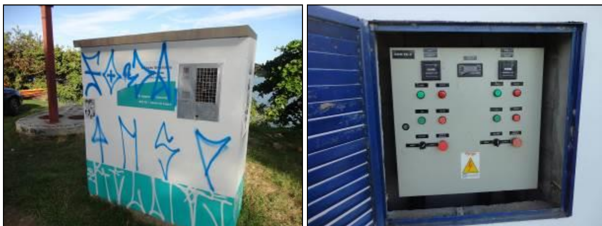
Figura 281: Vista externa e interna da casa de comando (Acompanhamento fev2014)
