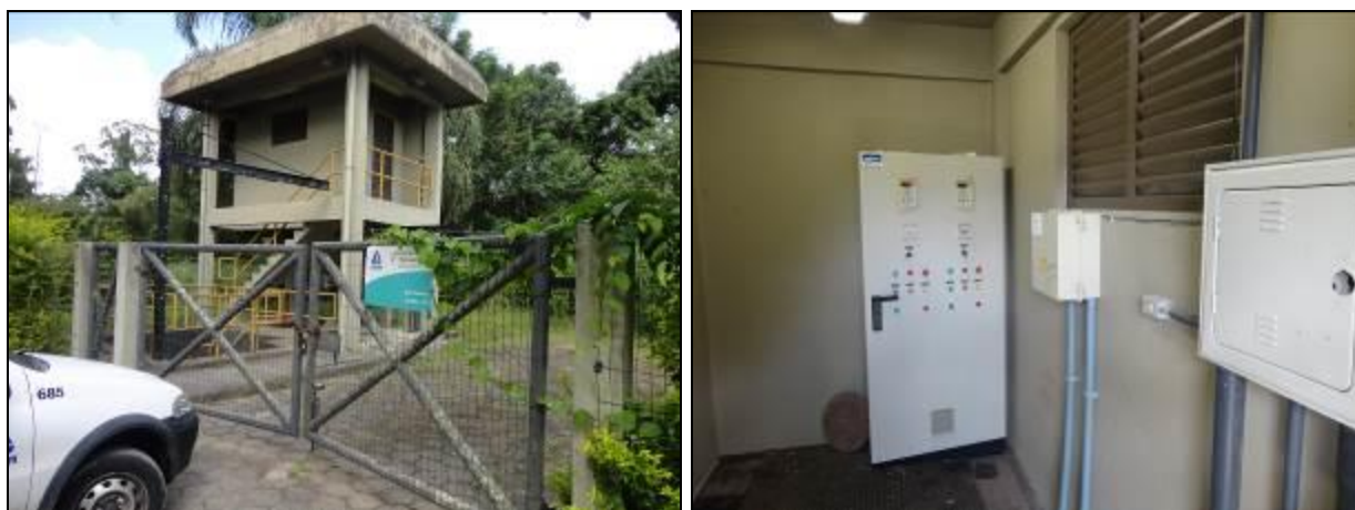
Figura 224: Vista externa e interna da casa de comando (Acompanhamento fev2014)
