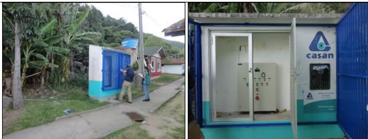
Figura 111: Vista externa e interna da casa de comando (Acompanhamento fev2014)
