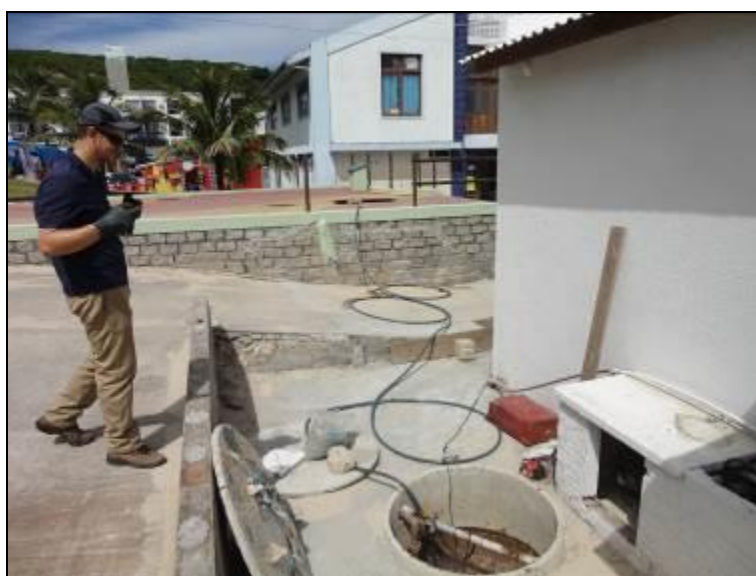
Figura 273: Ligação indevida (Acompanhamento fev2014)
