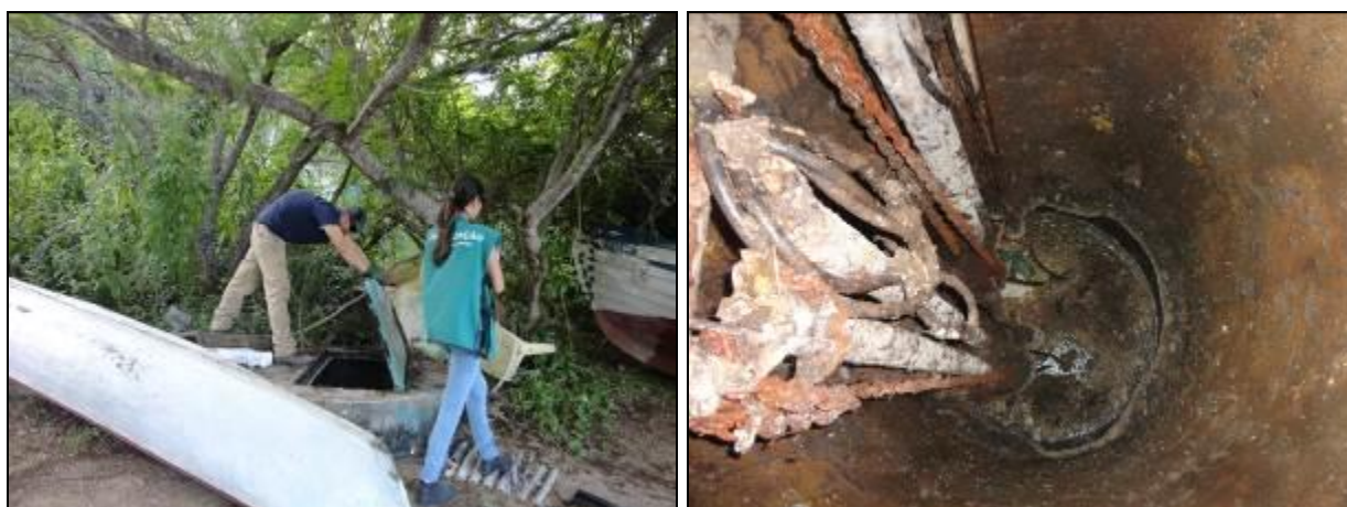
Figura 116: Vista externa e interna do poço úmido (Acompanhamento fev2014)
