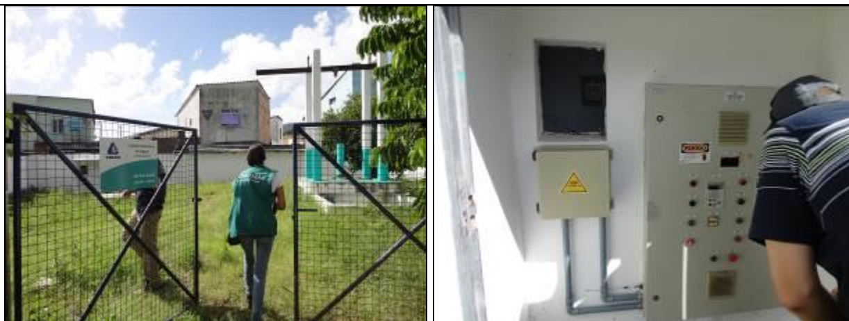
Figura 290: Vista externa e interna da casa de comando (Acompanhamento fev2014)
