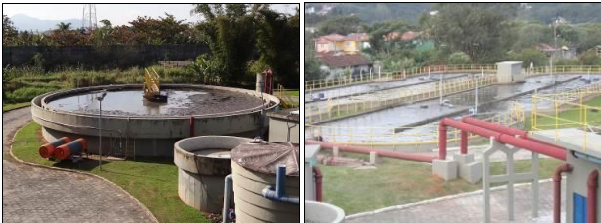
Figura 66: Decantador (à esquerda) e Valos de oxidação (à direita) (Acompanhamento set2013)
