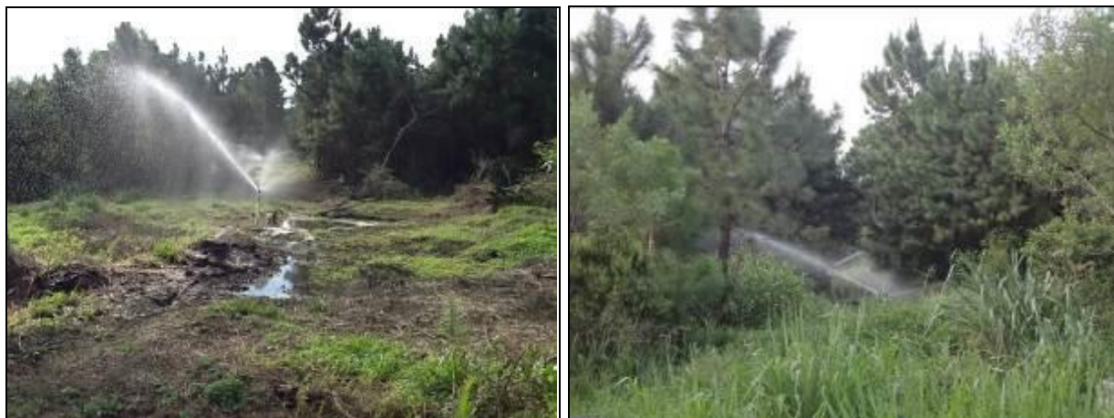
Figura 86: Lançamento do efluente final (Inicial à esquerda e Acompanhamento fev2014 à direita)
