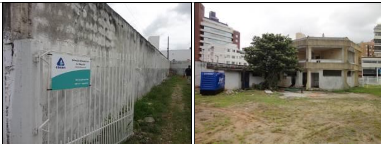
Figura 164: Vista geral da EEE (Acompanhamento fev2014)
