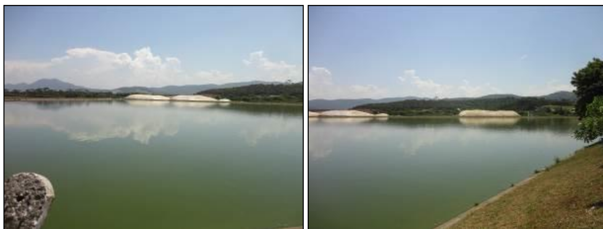
Figura 90: Lagoas de decantação (Acompanhamento fev2014)
