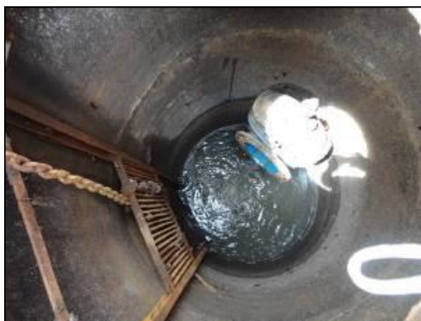
Figura 256: Casa de comando (à esquerda) e gradeamento inoperante (à direita) (Acompanhamento fev2014)
