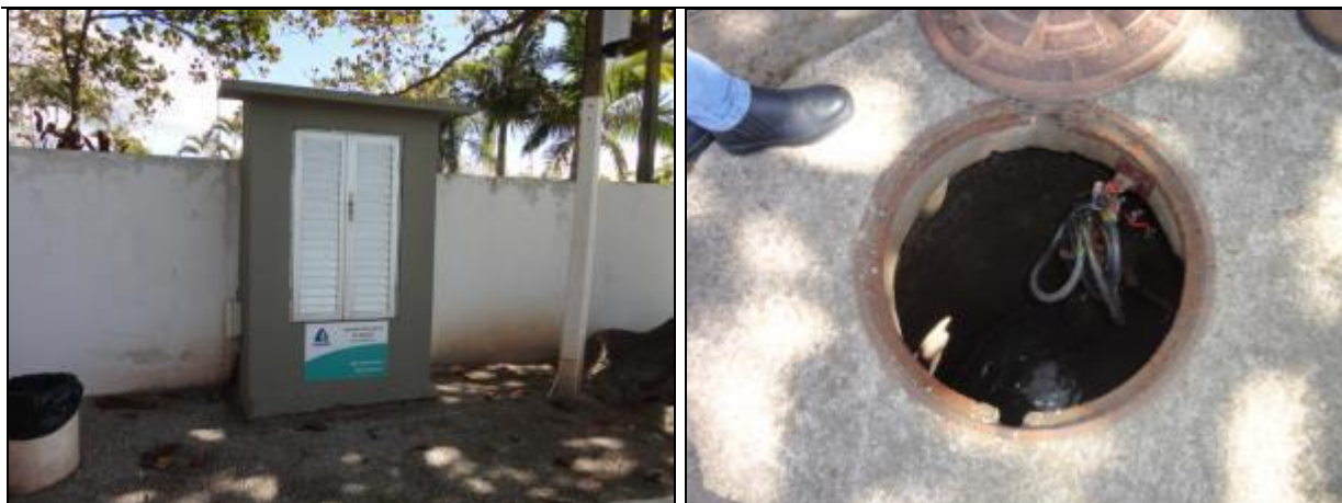
Figura 141: EEE Canajurê I (Acompanhamento set2013)
