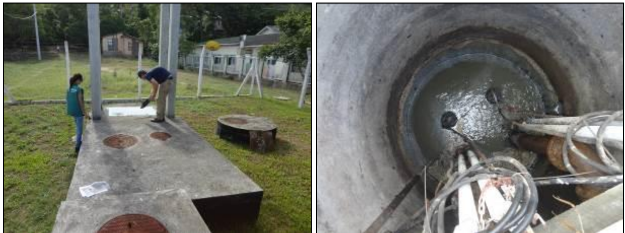
Figura 118: Vista externa e interna do poço úmido (Acompanhamento fev2014)
