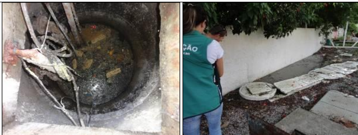
Figura 297: Poço úmido (à esquerda) e vazamento no terreno da Estação (à direita) (Acompanhamento fev2014)
