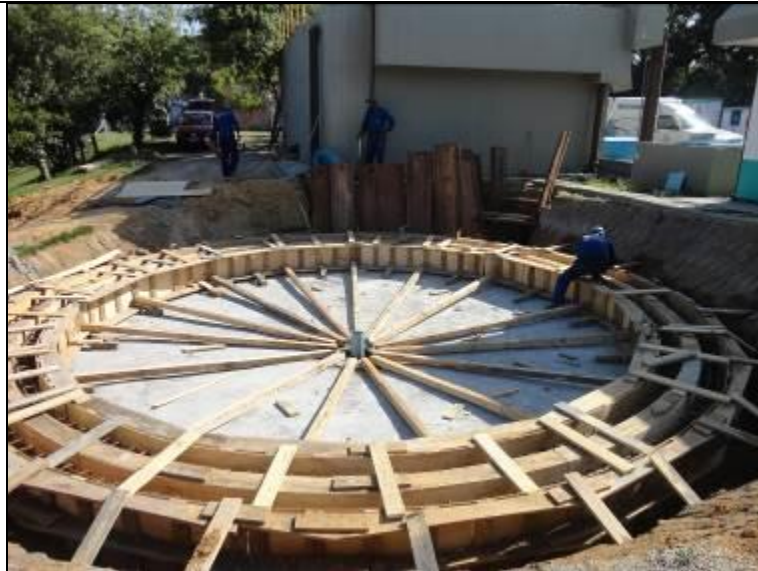
Figura 30: Novo decantador (Acompanhamento fev2014)
