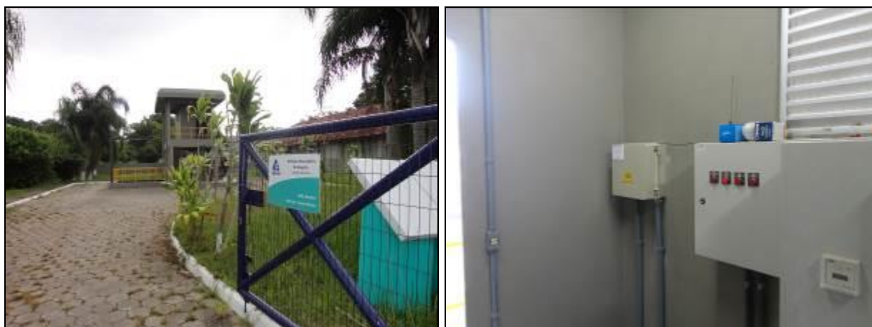
Figura 227: Vista externa e interna da casa de comando (Acompanhamento fev2014)
