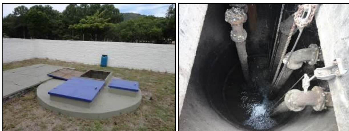
Figura 110: Vista externa e interna do poço úmido (Acompanhamento fev2014)
