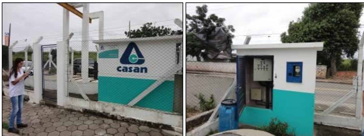
Figura 177: Vista externa e interna da casa de comando (Acompanhamento fev2014)
