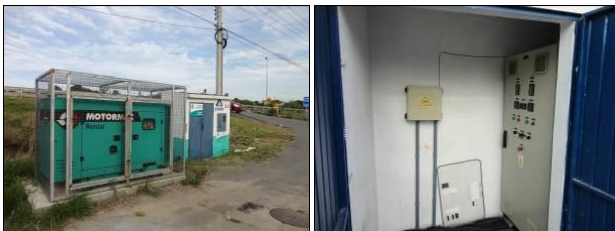
Figura 149: Vista externa e interna da casa de comando (Acompanhamento fev2014)
