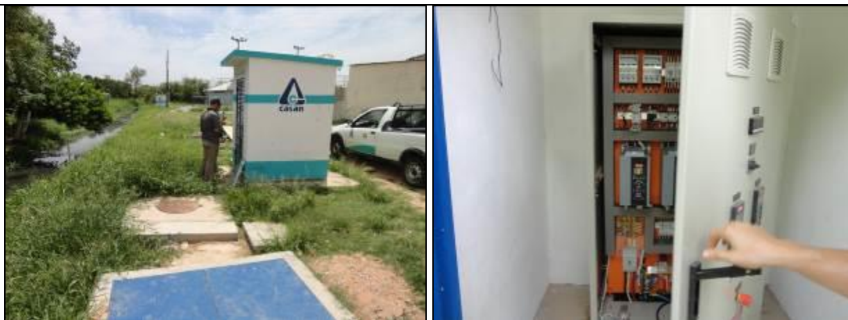
Figura 161: Vista externa e interna da casa de comando (Acompanhamento fev2014)
