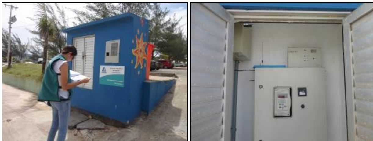
Figura 271: Vista externa e interna da casa de comando (Acompanhamento fev2014)
