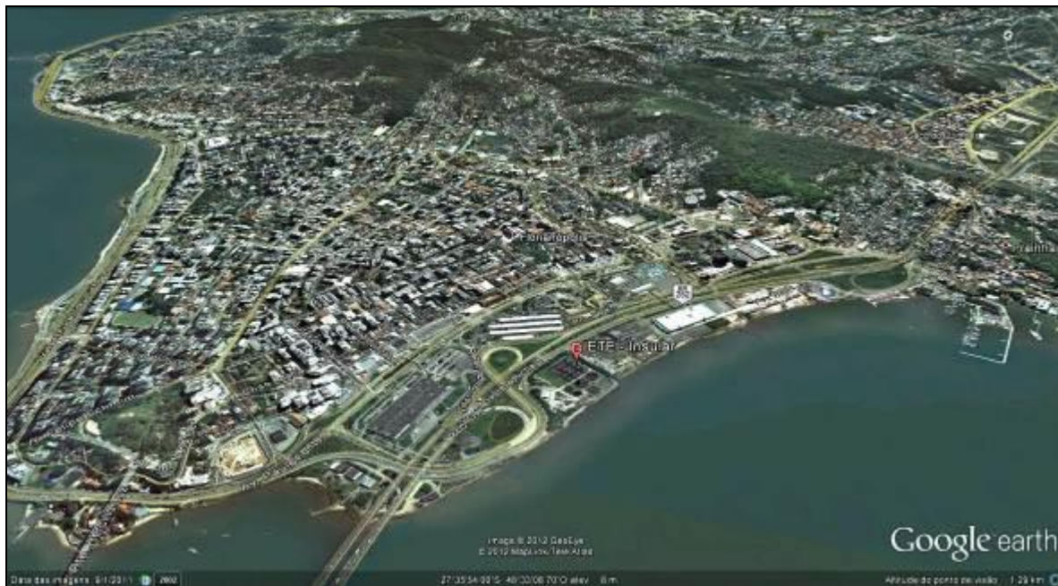
Figura 1: Localização da ETE Insular, no Aterro da Baía Sul. Coordenadas Geográficas: 27° 35' 54" S / 48° 33' 08" O
