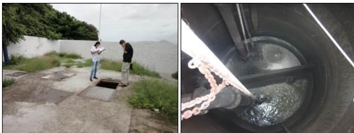
Figura 187: Vista externa e interna do poço úmido (Acompanhamento fev2014)
