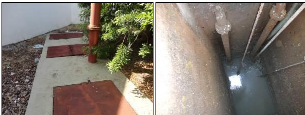
Figura 128: Vista externa e interna do poço úmido (Acompanhamento fev2014)
