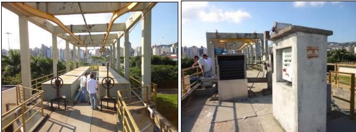
Figura 7: Estruturas da área de recepção de esgoto bruto (Acompanhamento set2013)
