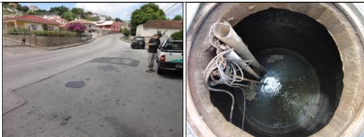
Figura 257: Vista externa e interna do poço úmido (Acompanhamento fev2014)
