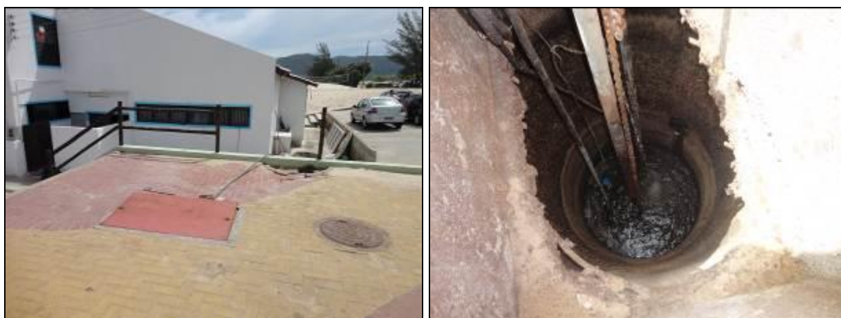
Figura 272: Vista externa e interna do poço úmido (Acompanhamento fev2014)
