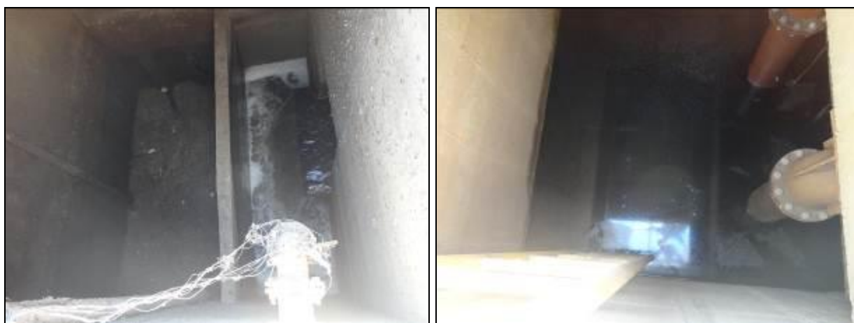
Figura 131: Vista interna do poço úmido (Acompanhamento fev20140)
