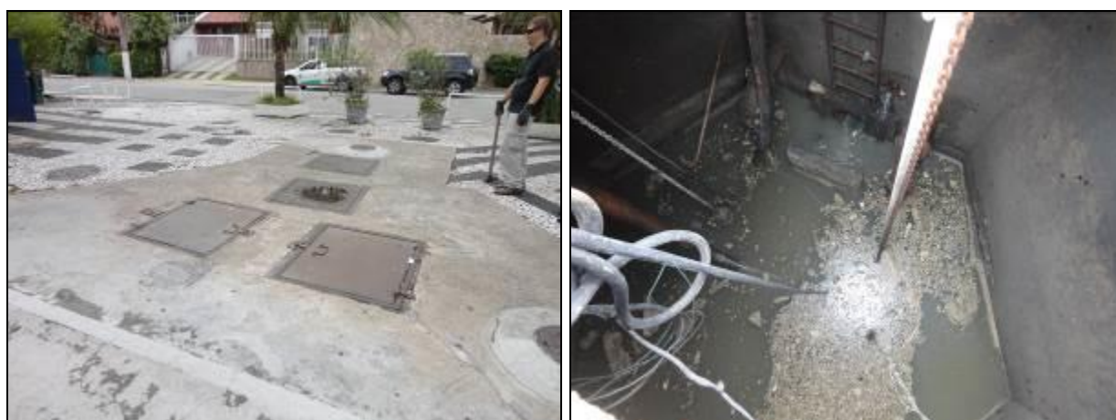
Figura 184: Vista externa e interna do poço úmido (Acompanhamento fev2014)
