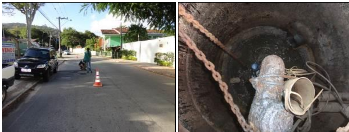
Figura 279: Vista externa e interna do poço úmido (Acompanhamento fev2014)
