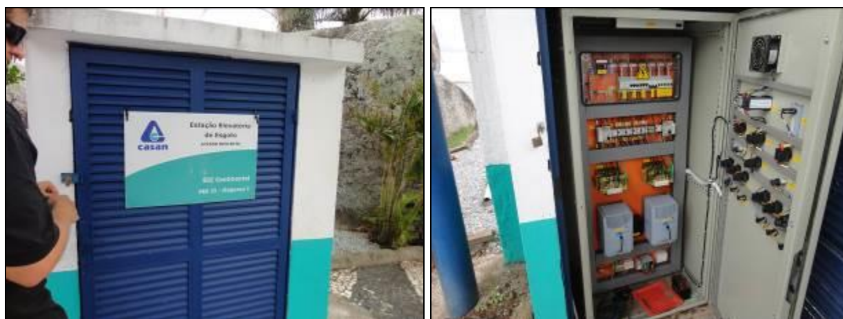
Figura 183: vista externa e interna da casa de comando (Acompanhamento fev2014)
