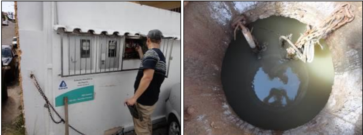
Figura 215: EEE BAc Servidão Franzoni (Acompanhamento fev2014)
