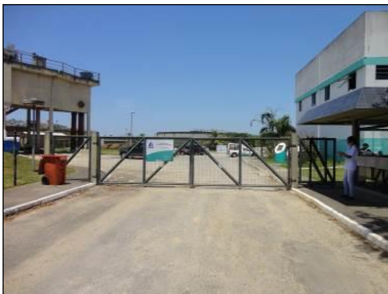
Figura 5: Acesso à ETE Insular (Acompanhamento fev2014)
