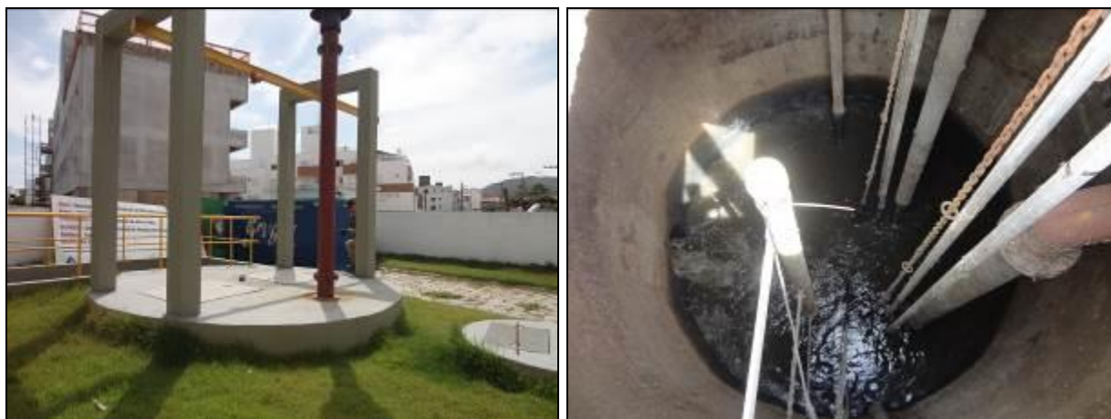
Figura 153: Vista externa e interna do poço úmido (Acompanhamento fev2014)
