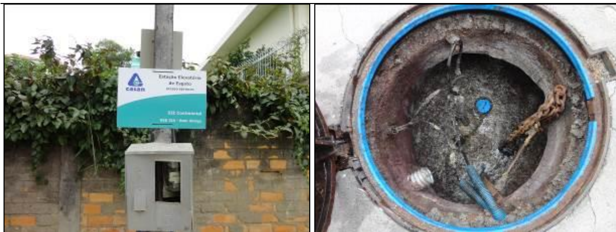
Figura 175: EEE J2A Bom Abrigo e poço úmido com lodo sobrenadante (Acompanhamento fev2014)
