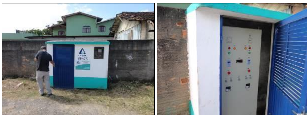
Figura 251: Vista externa e interna da casa de comando (Acompanhamento fev2014)
