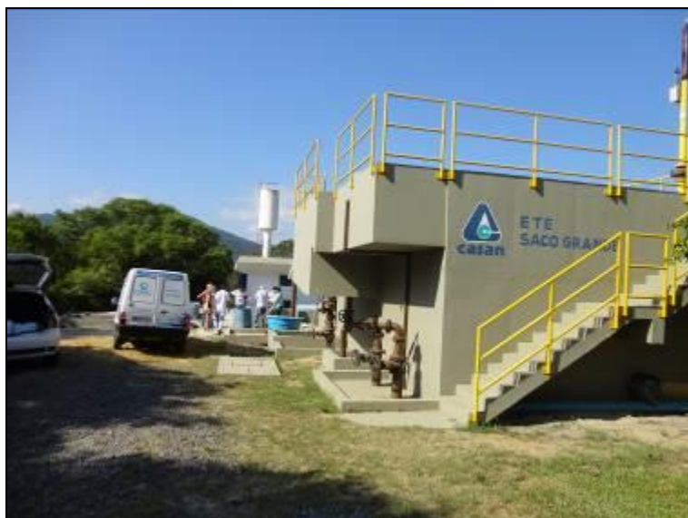
Figura 18: Fachada da ETE Saco Grande (Acompanhamento fev2014)
