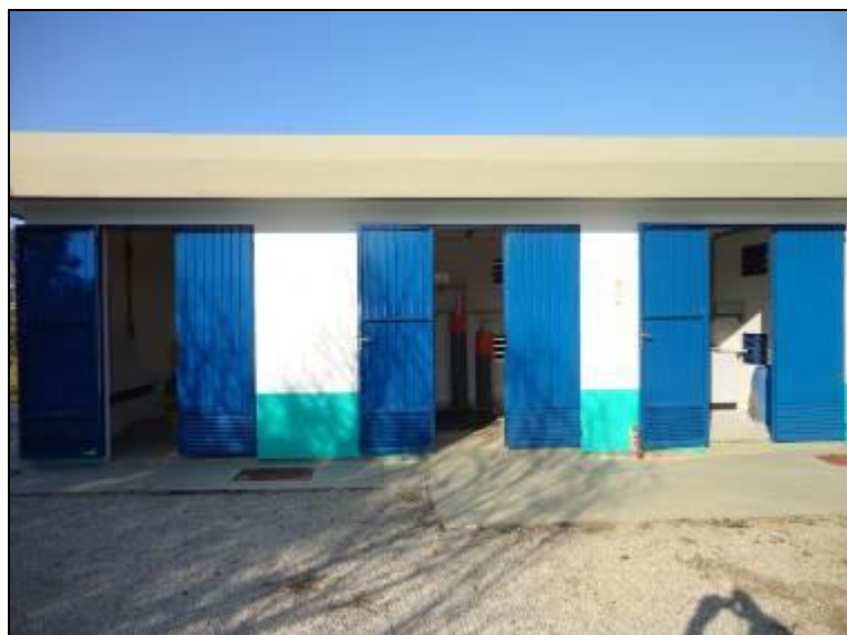
Figura 23: Estrutura de apoio: depósitos e escritórios (Acompanhamento set2013)
