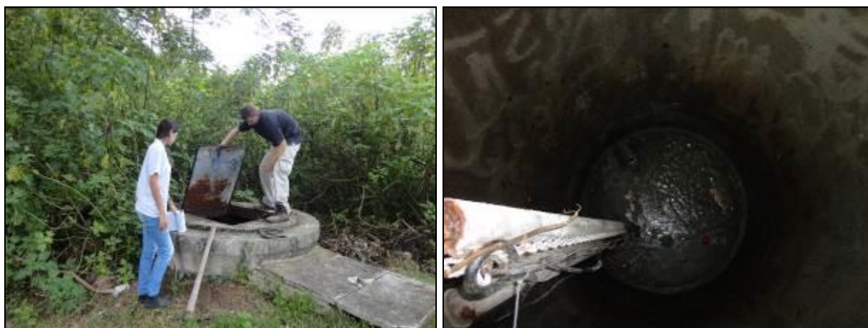
Figura 196: Vista externa e interna do poço úmido (Acompanhamento fev2014)
