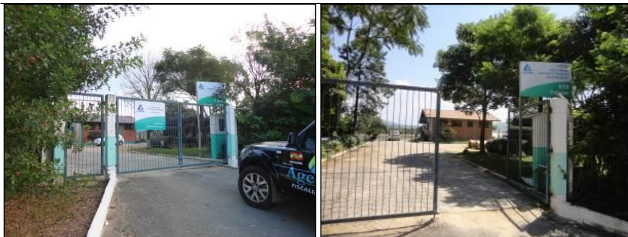
Figura 91: Acesso à ETE e placa de identificação (Acompanhamento set2013 à esquerda e fev2014 à direita)
