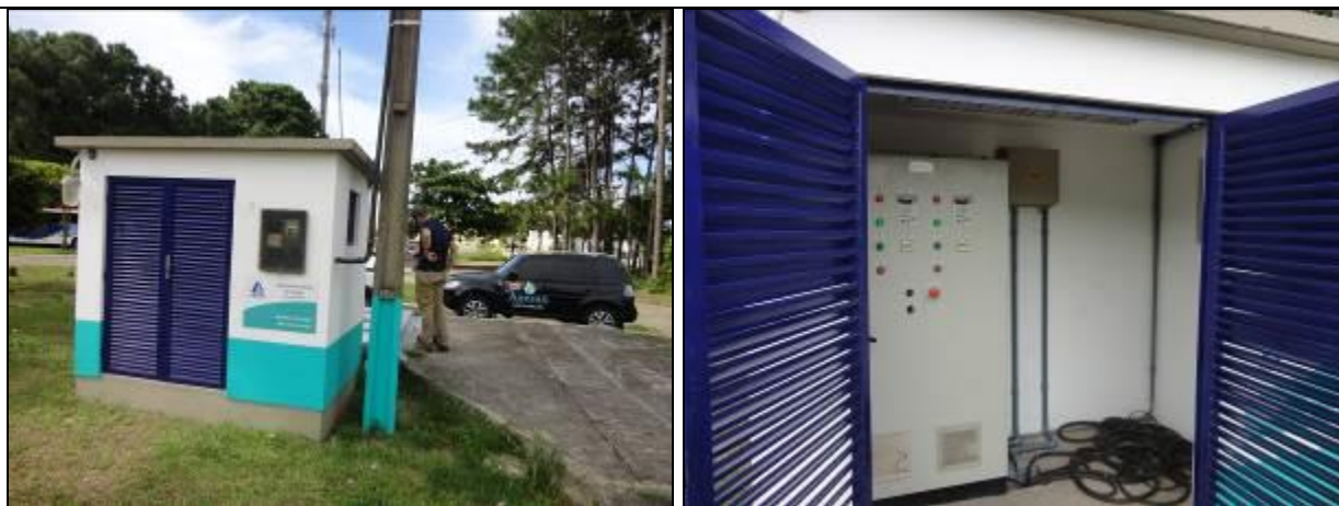
Figura 101: Vista externa e interna da casa de comando (Acompanhamento fev2014)
