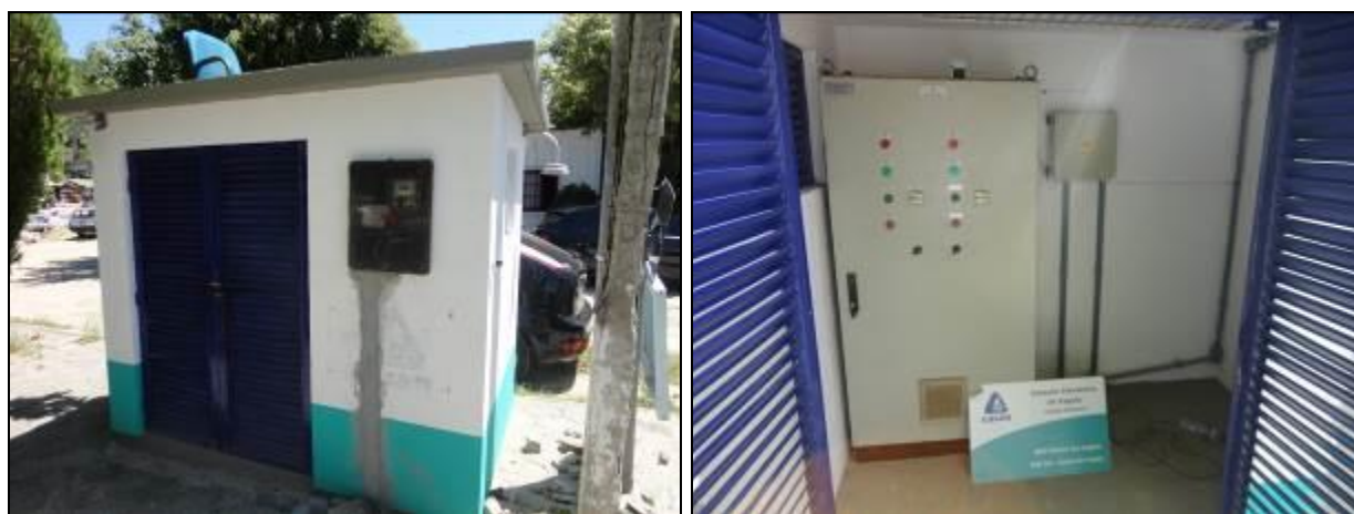
Figura 106: Vista externa e interna da casa de comando (Acompanhamento fev2014)
