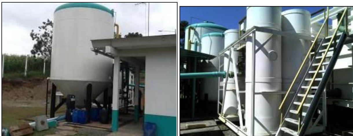
Figura 10: Imagens da ETA (inicial e acompanhamento)
