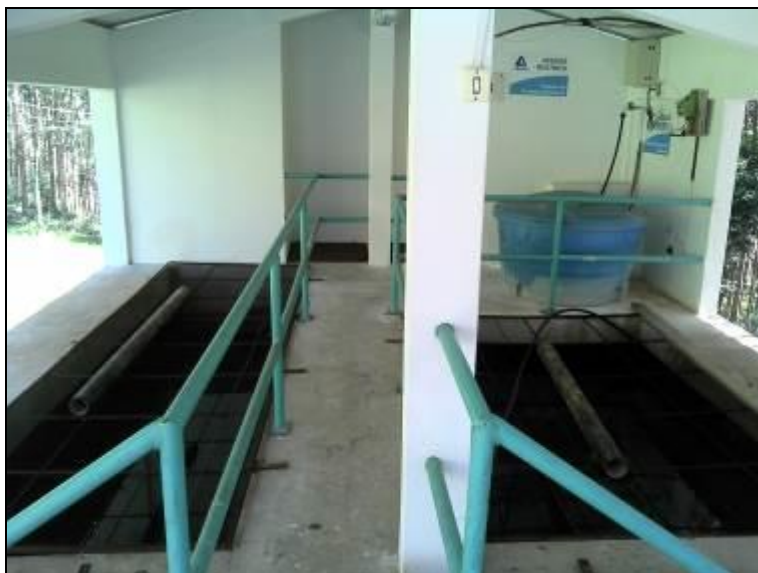
Figura 20: Filtro e decantador ETA (acompanhamento)
