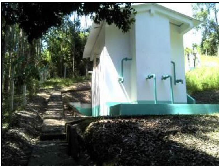
Figura 18: ETA Residência Fuck (acompanhamento)
