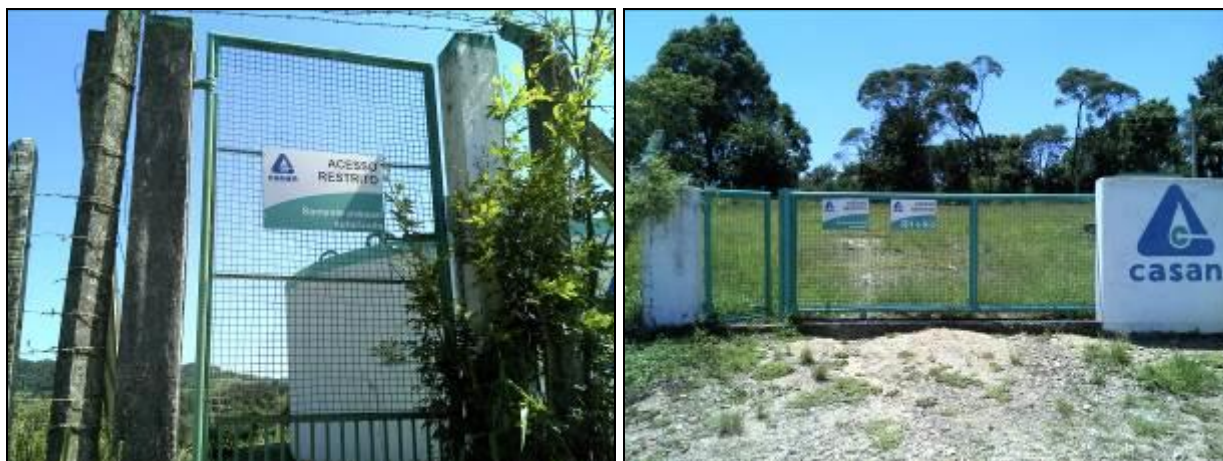
Figura 23: Identificações nos Reservatórios (acompanhamento)
