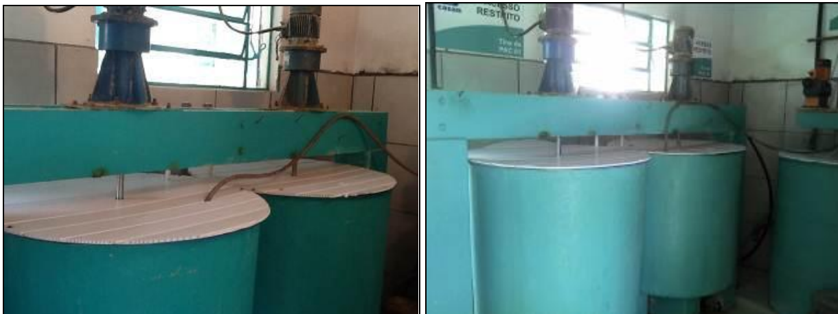
Figura 16: Casa de Química (inicial e acompanhamento)
