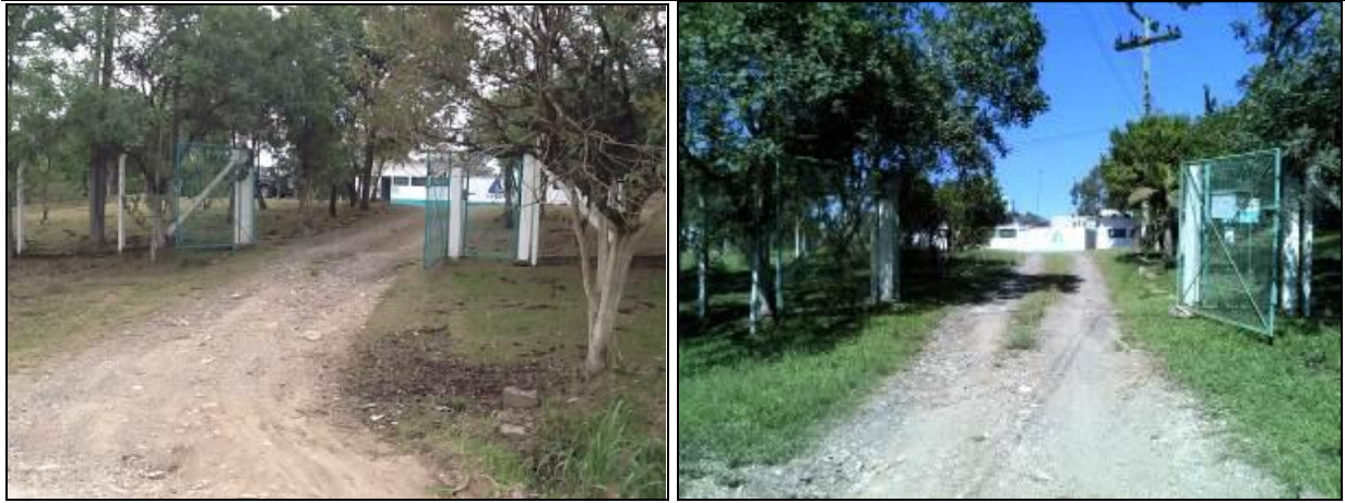
Figura 8: Acesso a Captação (inicial e acompanhamento)
