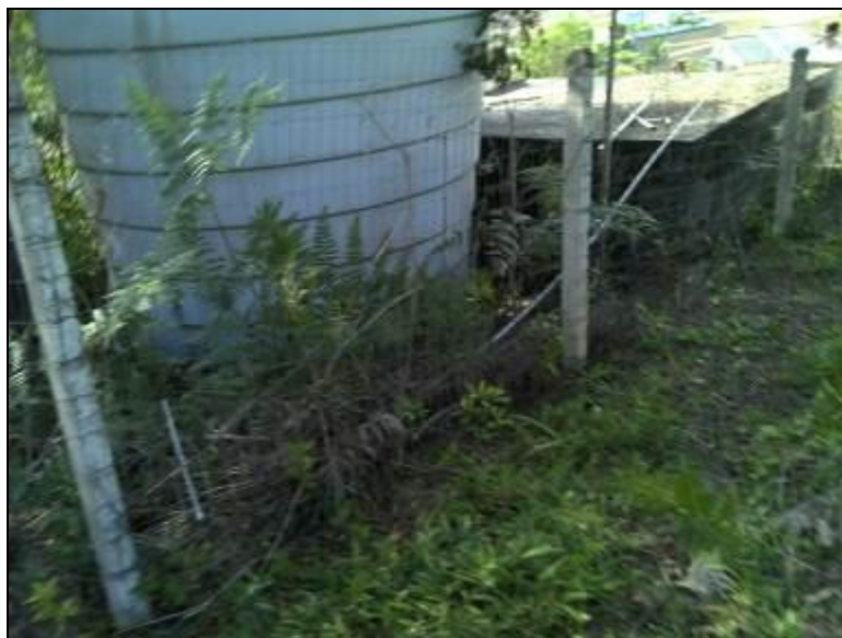
Figura 12: Reservatório do Viracopos
