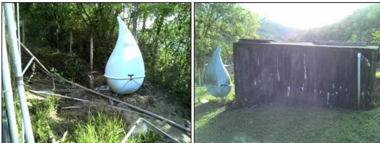
Figura 7: Dosador de Santa Tereza.
