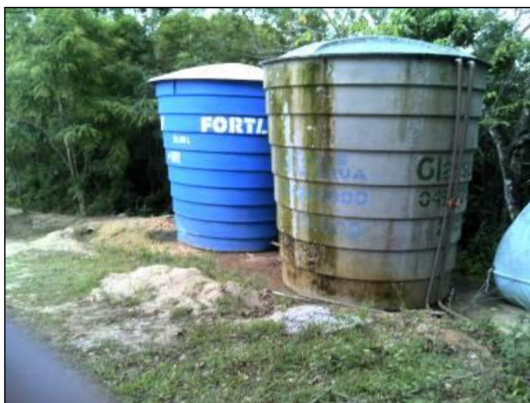
Figura 9: Reservatório Boa Parada
